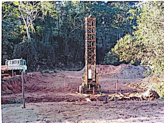
FIGURA 8 – CRAVAÇÃO DE ESTACAS
