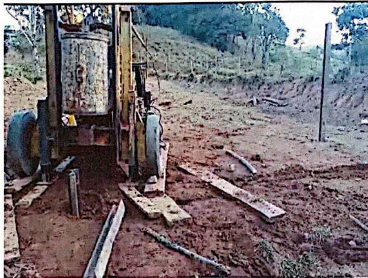
FIGURA 3 - CRAVAÇÃO ESTACAS
