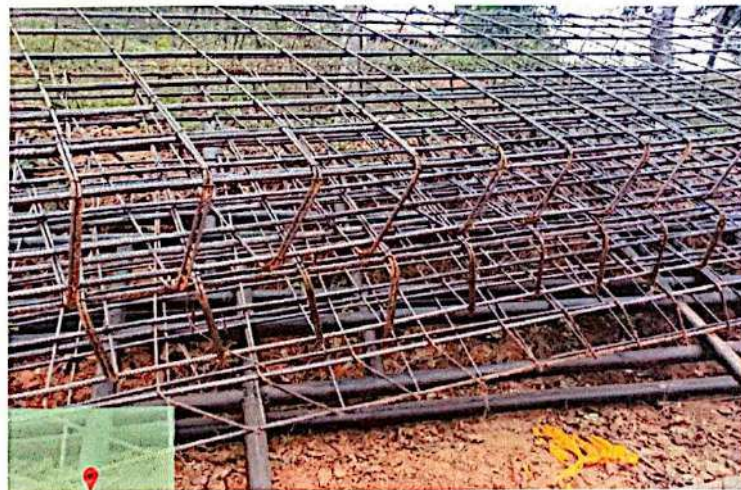
FIGURA 4 - FERRAGENS DA FUNDAÇÃO
