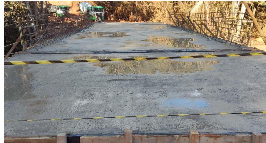
CONCRETAGEM TABULEIRO E LAJES DE TRANSIÇÃO
