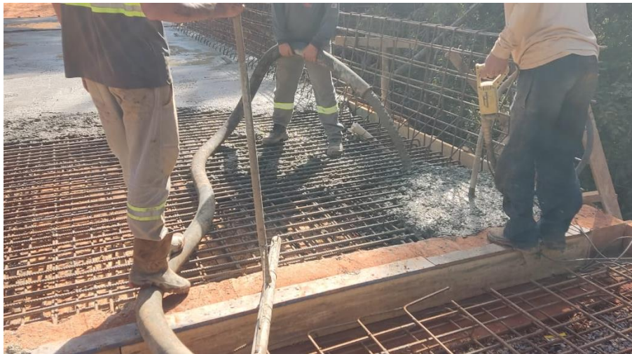
CONCRETAGEM DO TABULEIRO
