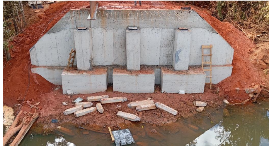
PILARES E PAREDE PRONTOS
