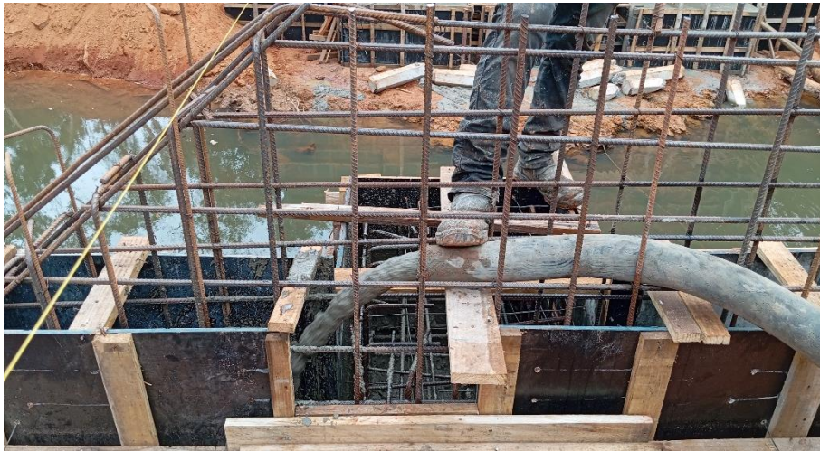
CONCRETAGEM DOS PILARES E PAREDE
