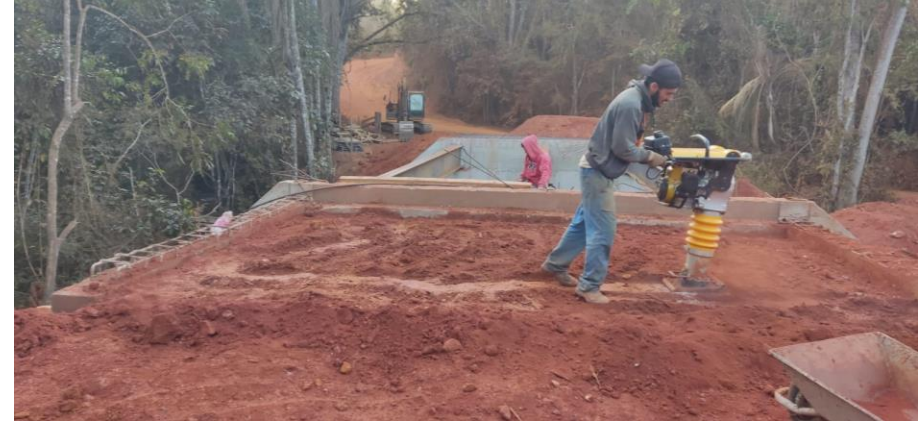
PREPARO DE FUNDO PARA LAJES DE TRANSIÇÃO
