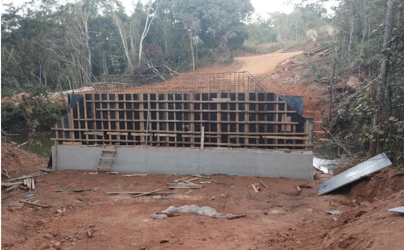
FORMAS E FERRAGENS DOS PILARES E PAREDE
