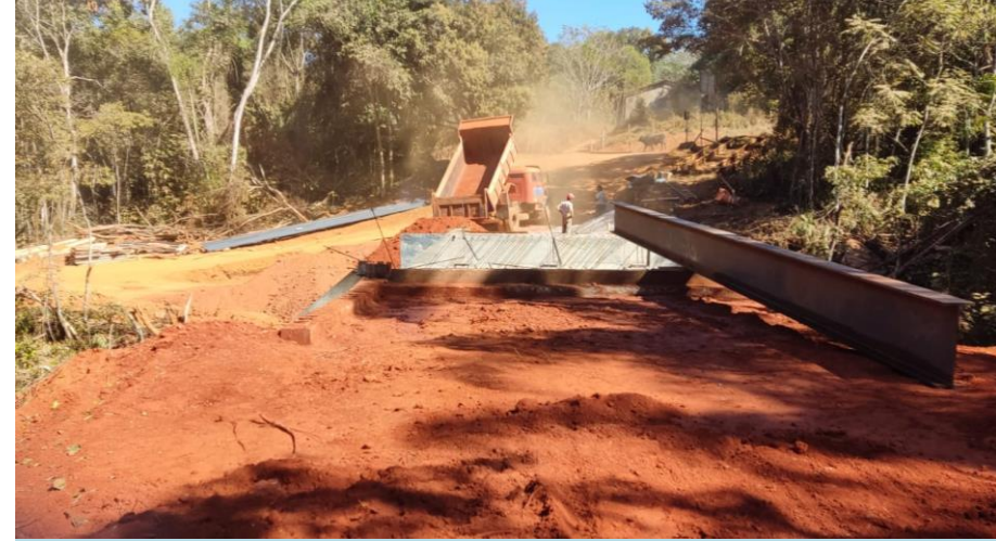
ASSENTAMENTO DAS VIGAS DE AÇO
