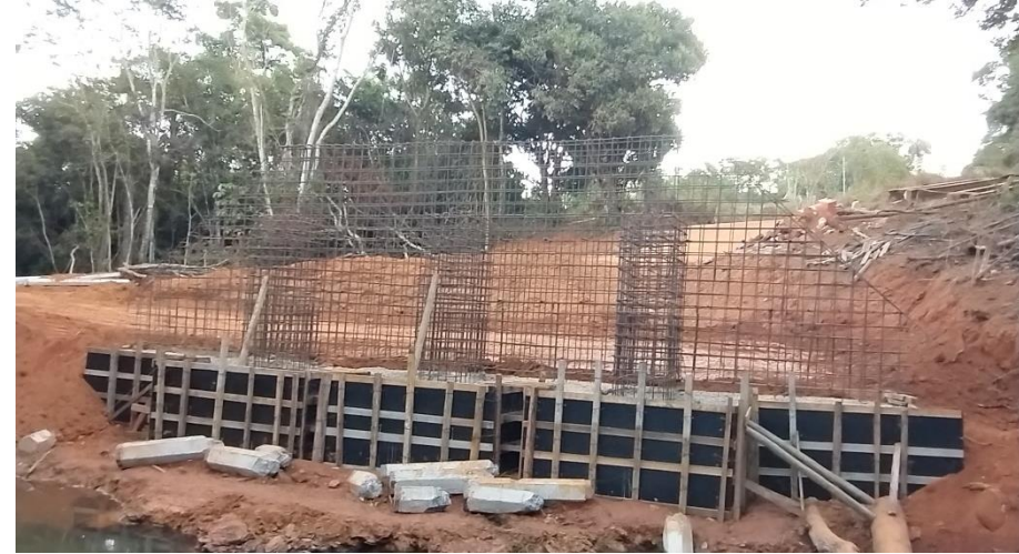
FERRAGEM DAS PAREDE E PILARES
