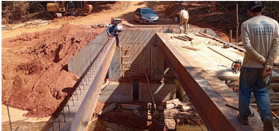
FIXAÇÃO DAS VIGAS E FORMAS DO FUNDO DO TALUDE
