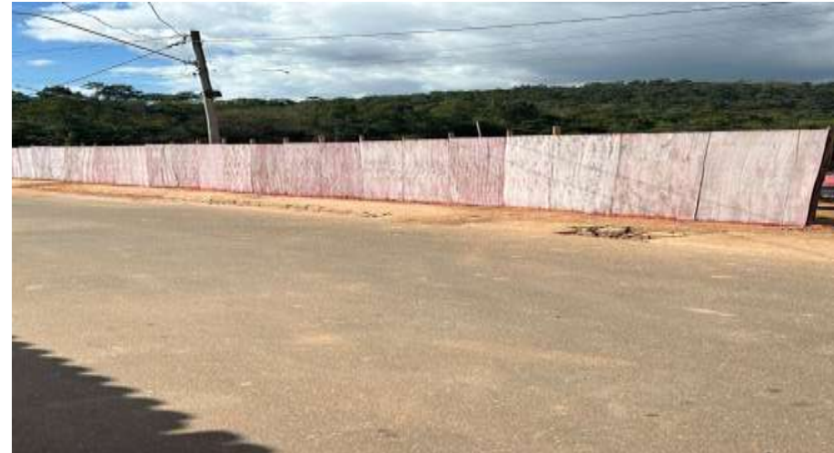
FECHAMENTO DA OBRA COM TAPUME
