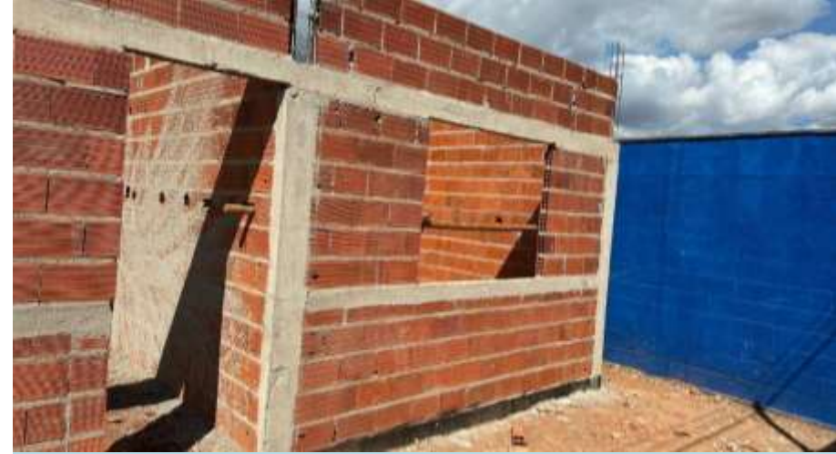
PAREDE COM VIGAS E PILAR
