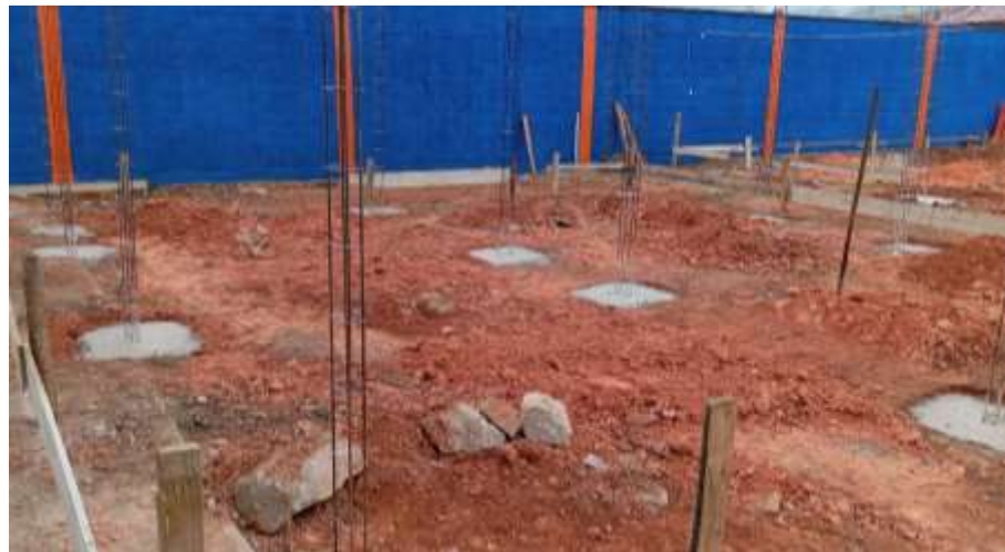
SAPATAS COM FERRAGENS DOS PILARES
