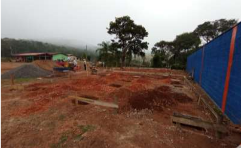
ABERTURA PARA SAPATA DOS PILARES
