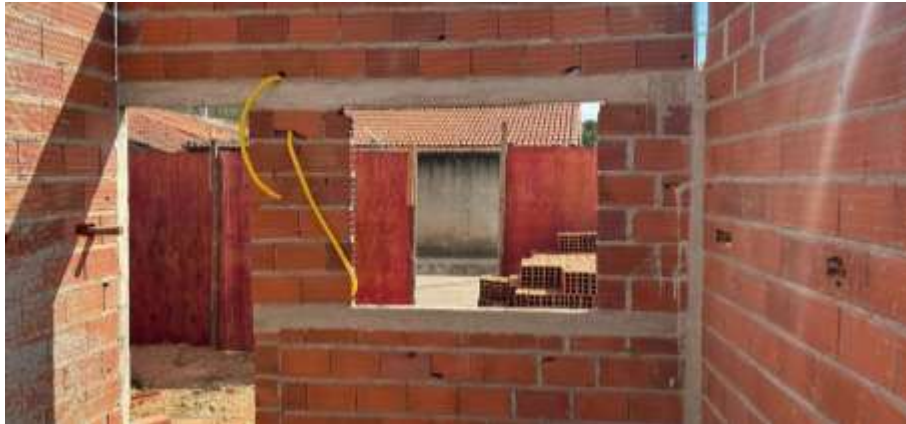
VIGAS NAS JANELAS E PORTAS
