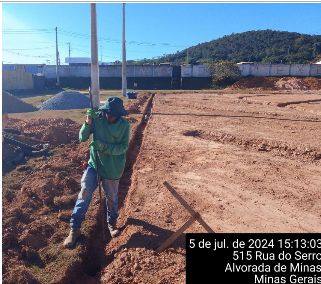
ABERTURA MANUAL DAS VALAS DA VIGA BALDRAME
