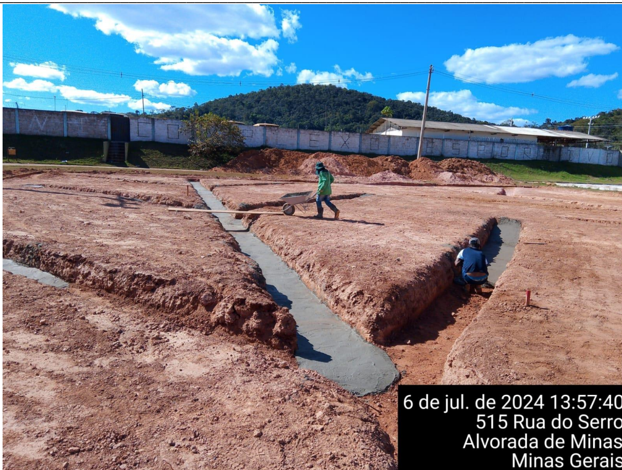
EXECUÇÃO DA CONCRETAGEM DA BASE DA DRENAGEM
