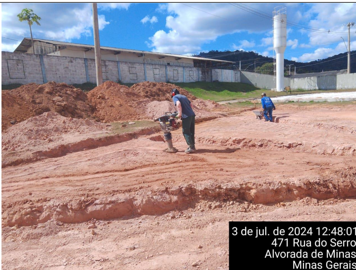
COMPACTAÇÃO COM REBAIXO DIFERENCIAL DE +/- 4CM
