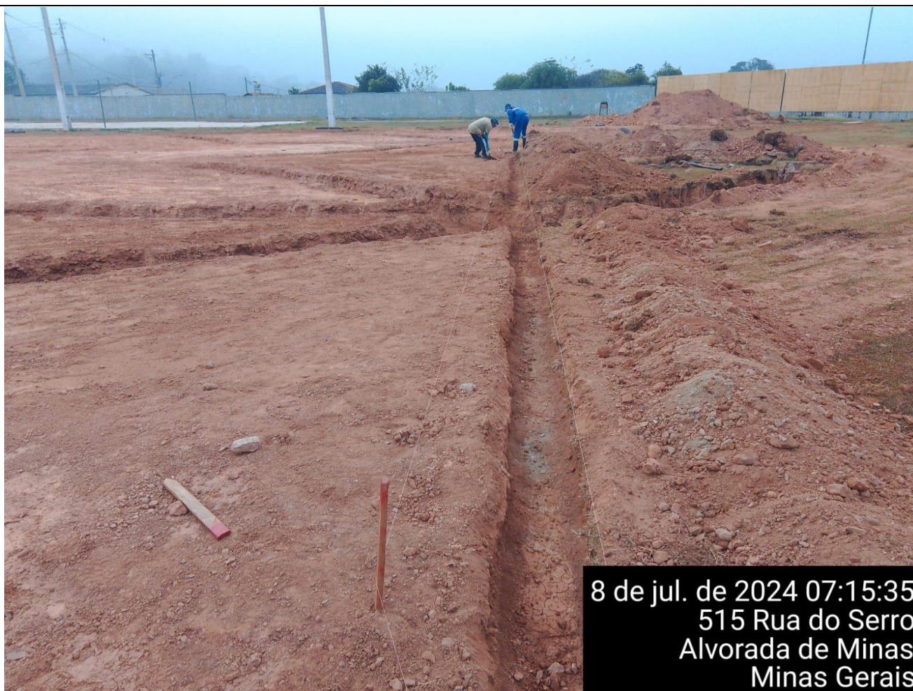
ESCAVAÇÃO DA VALA DA VIGA BALDRAME DO CAMPO
