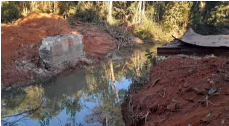
REMOÇÃO DA PONTE ANTIGA
