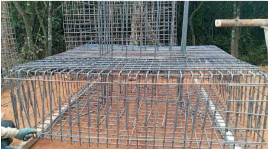
FERRAGEM BASE DOS PILARES
