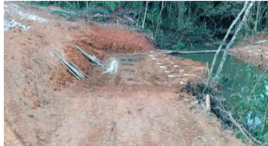
ESCAVAÇÃO E BASE PARA AS ESTACAS
