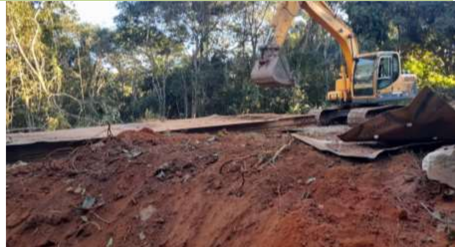
REMOÇÃO DA PONTE ANTIGA
