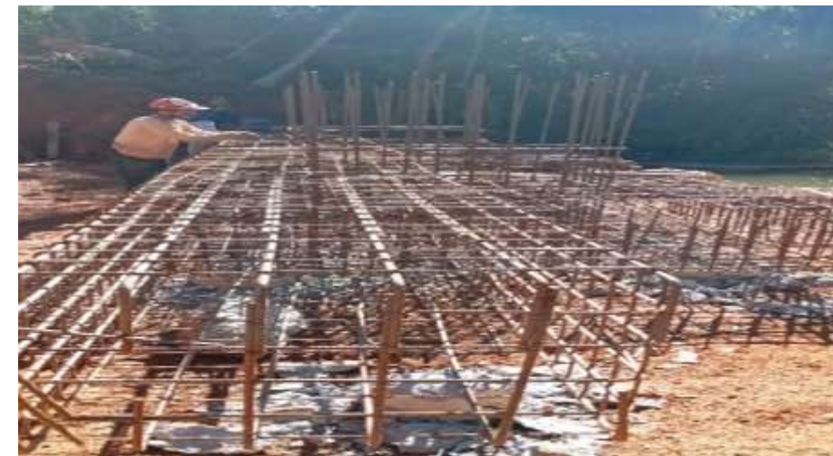
BASE DOS PILARES E ARRANQUE
