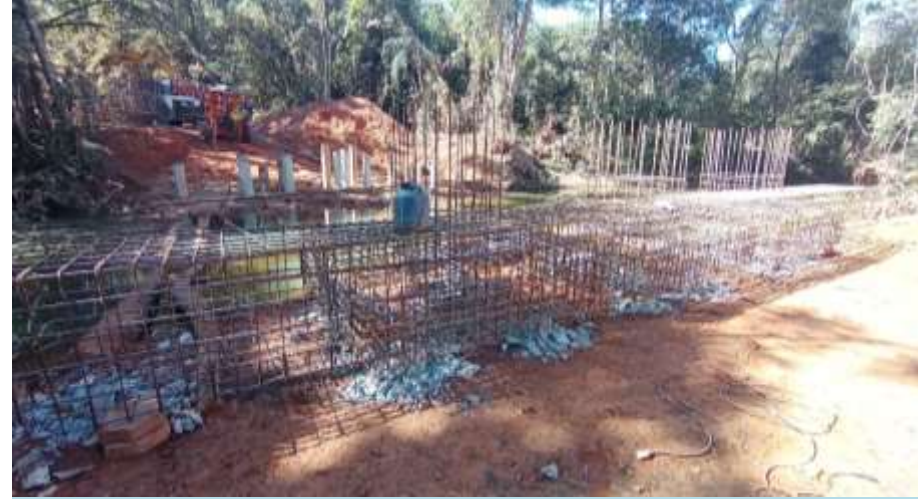
MONTAGEM DA FERRAGEM SOBRE AS ESTACAS
