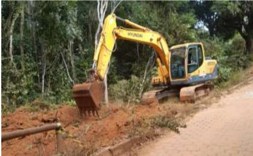
LIMPEZA DA ÁREA
