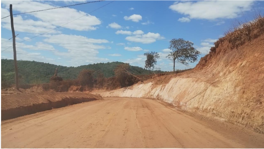
Figura 5 - Rua a ser pavimentada
