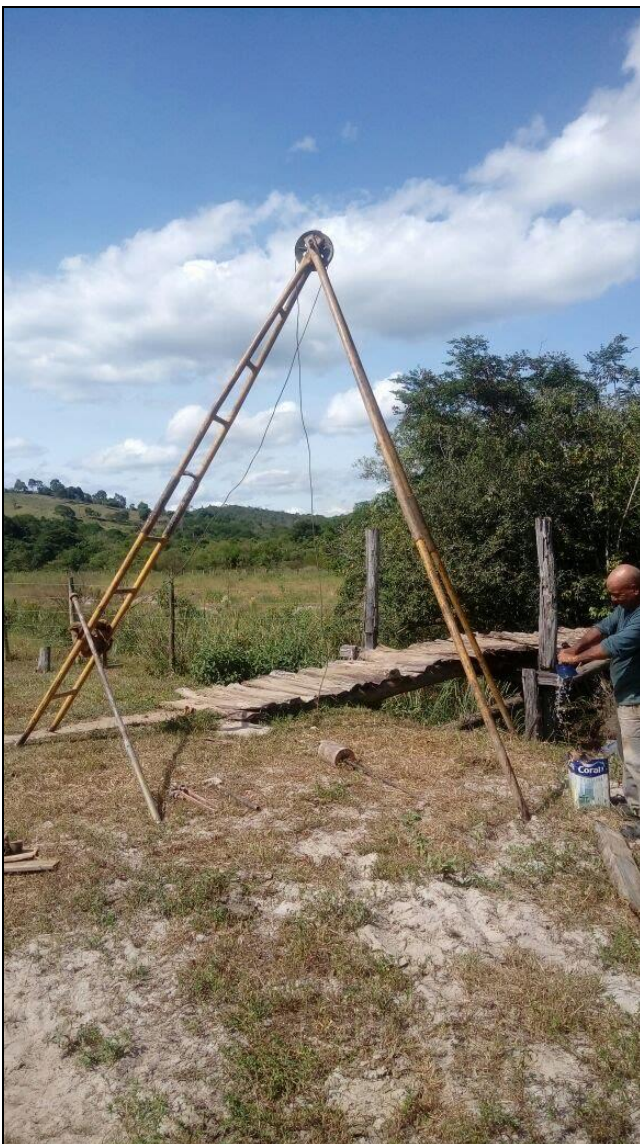
Execução do furo SPT 01
