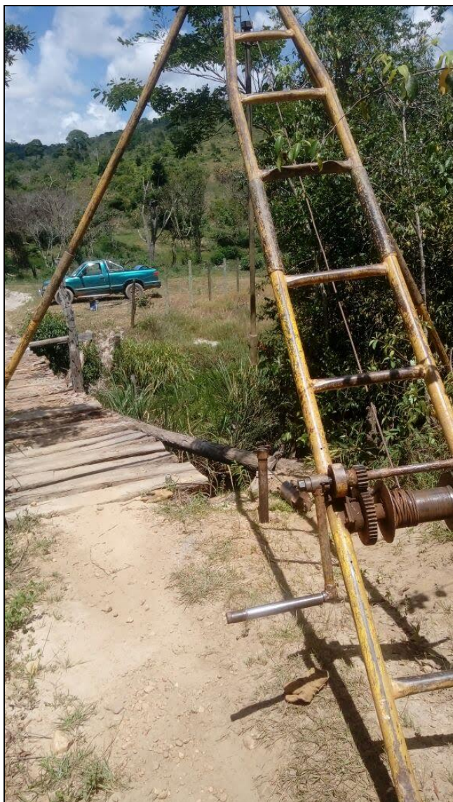
Execução do furo SPT 05
