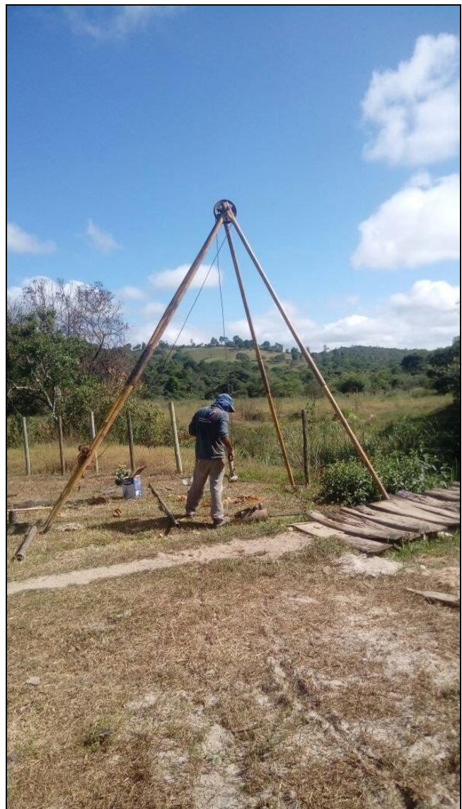
Execução do furo SPT 02
