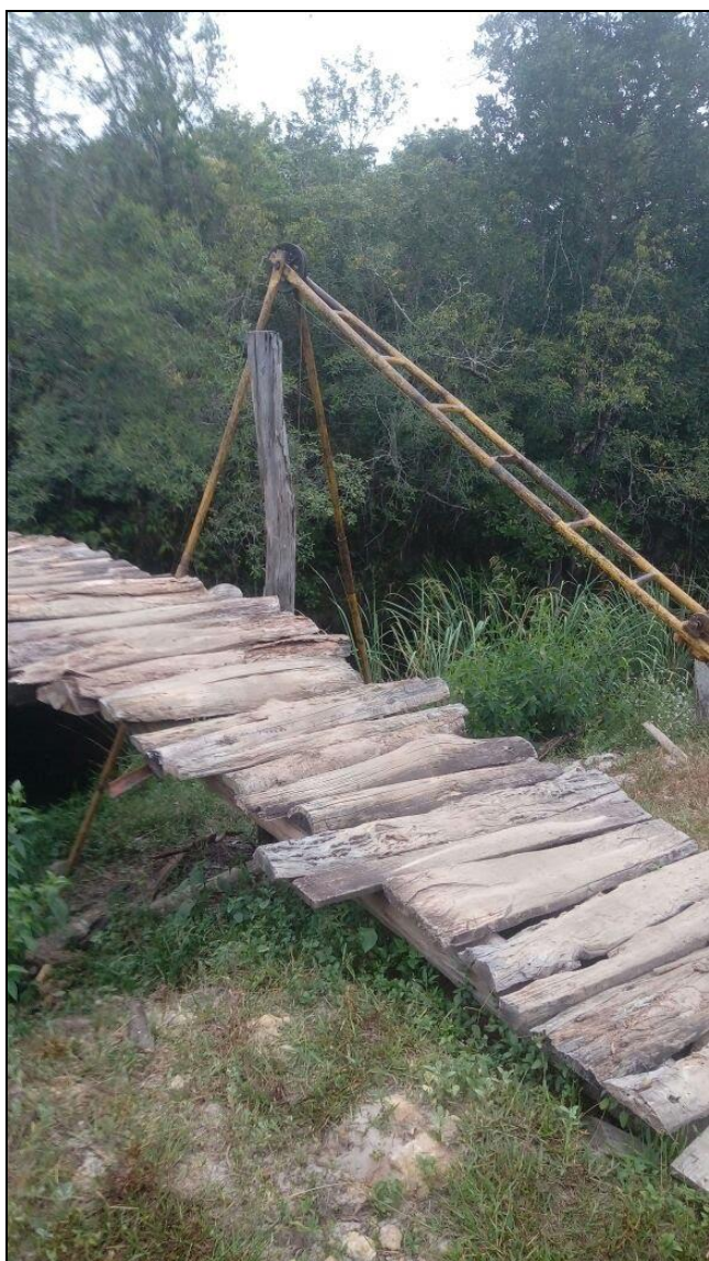
Execução do furo SPT 03
