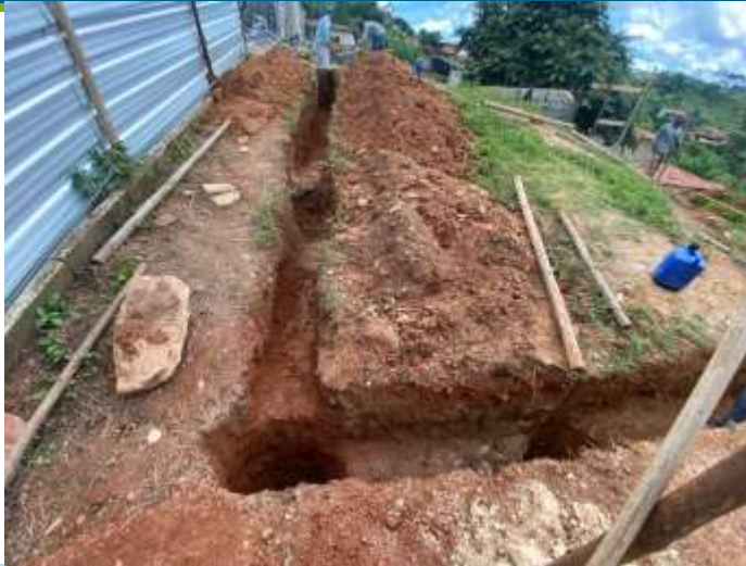
ESCAVAÇÃO MANUAL DE VALA PARA VIGA BALDRAME
