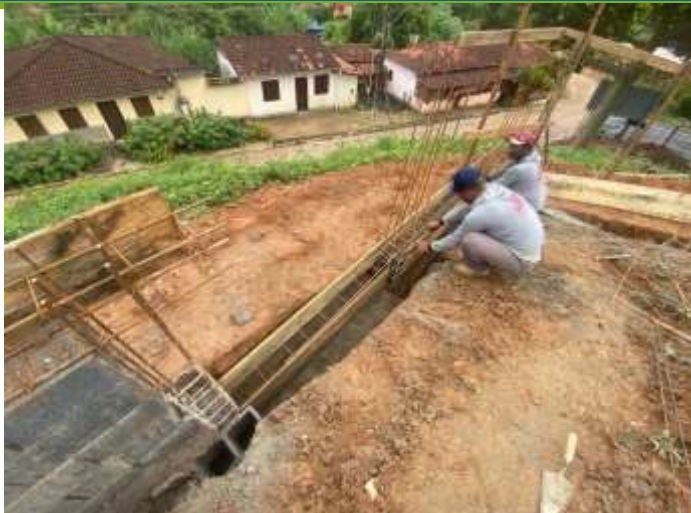
FABRICAÇÃO, MONTAGEM E DESMONTAGEM DE FORMA.
