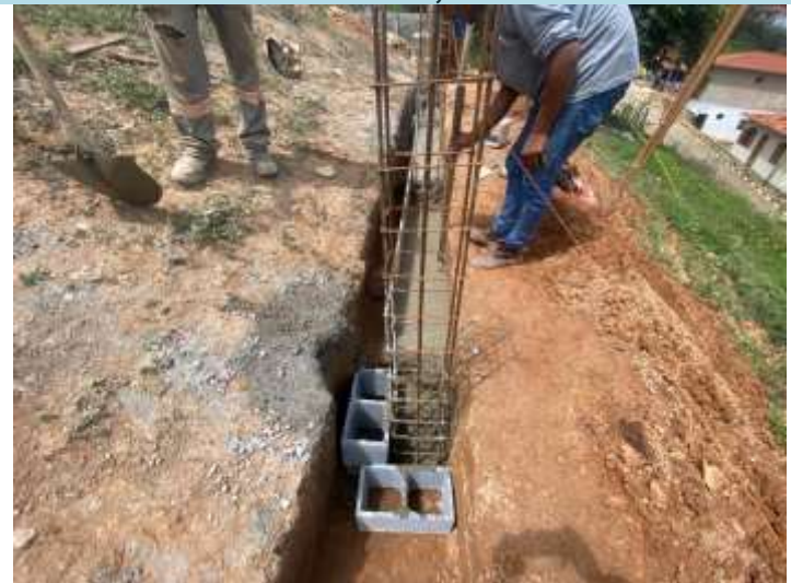
LASTRO DE CONCRETO MAGRO
