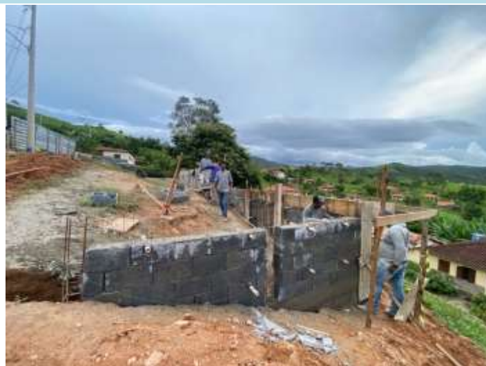
ALVENARIA DE BLOCO CHEIO COM ARMAÇÃO
