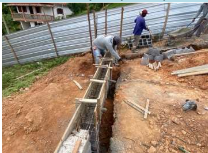
FABRICAÇÃO, MONTAGEM E DESMONTAGEM DE FORMA.
