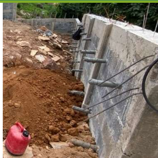
EXECUÇÃO DE BOLSÃO DE BRITA PARA TUBOS DRENANTES – TIPO BARBACÃ
