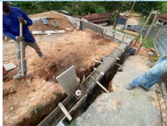
CONCRETAGEM DA CINTA
