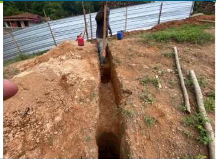
ESCAVAÇÃO MANUAL DE VALA COM PROFUNDIDADE ATÉ 1,5M.
