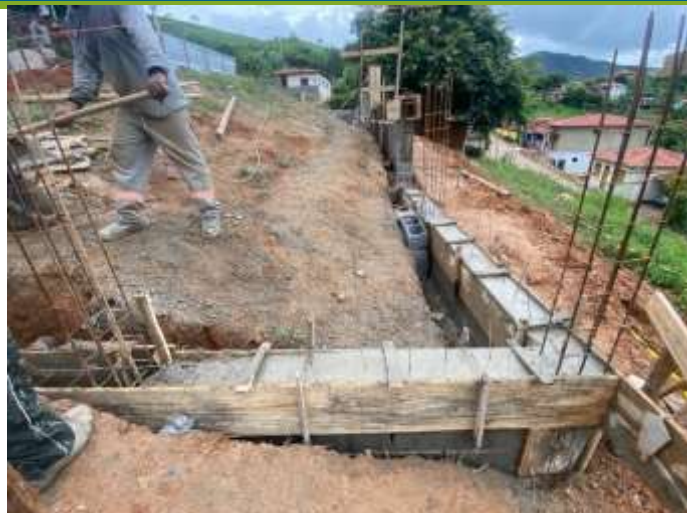
CONCRETAGEM DA VIGA BALDRAME
