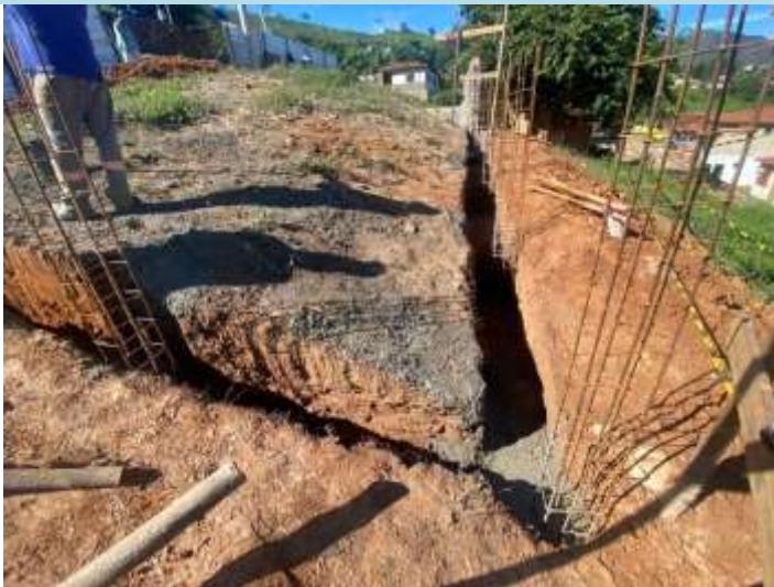
COMCRETAGEM DAS ESTACAS
