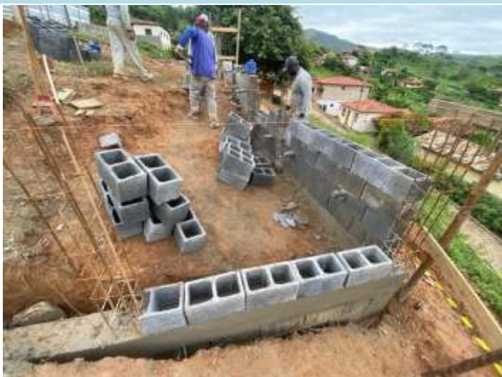
ALVENARIA DE BLOCO CHEIO COM ARMAÇÃO
