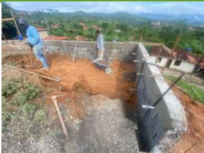
EXECUÇÃO DE BOLSÃO DE BRITA PARA TUBOS DRENANTES – TIPO BARBACÃ
