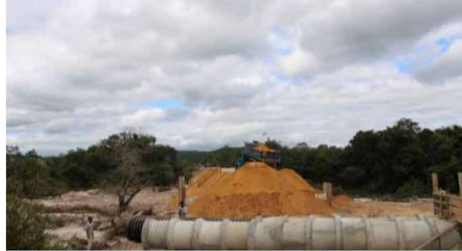
MONTAGEM DOS DRENOS
