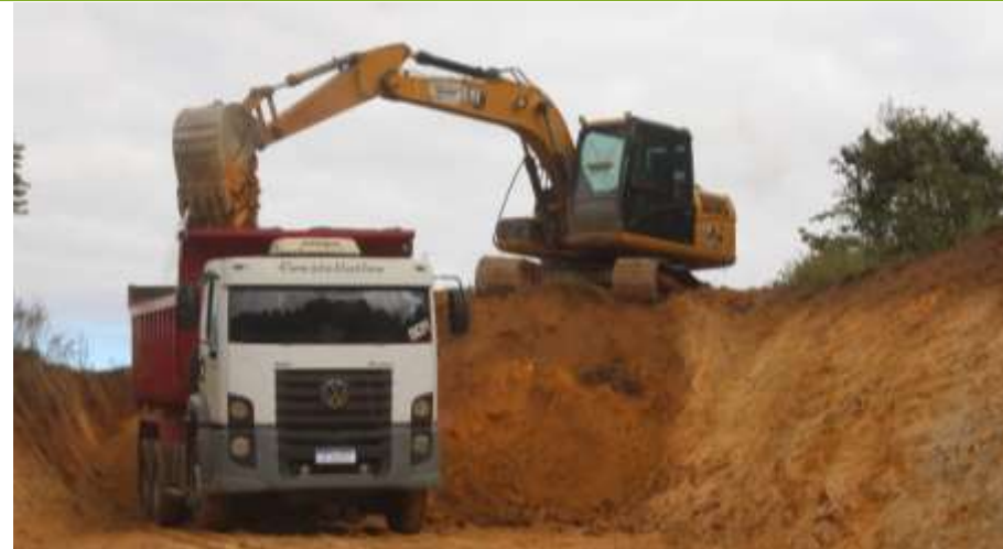
MOVIMENTAÇÃO DE TERRA PARA ATERRO
