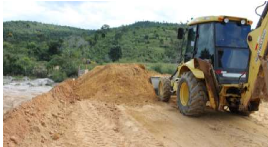
ESPALHAMENTO DE TERRA
