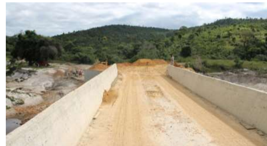
ATERRO DA CABECEIRA DA PONTE
