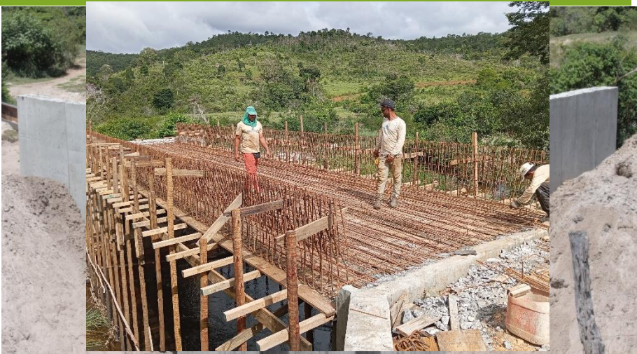
ARMAÇÃO DAS FERRAGENS DO TABULEIRO
