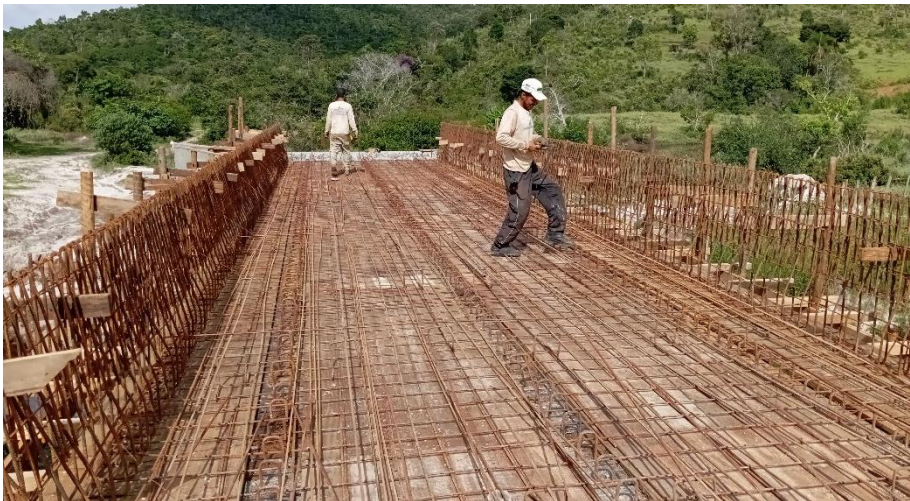
ARMAÇÃO DAS FERRAGENS DO TABULEIRO
