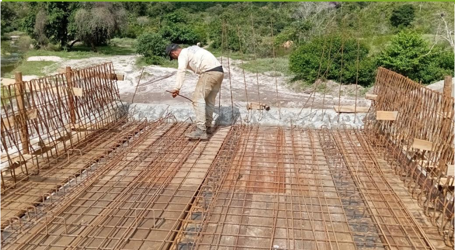
ARMAÇÃO DAS FERRAGENS DO TABULEIRO
