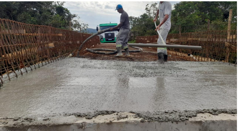
CONCRETAGEM DO TABULEIRO
