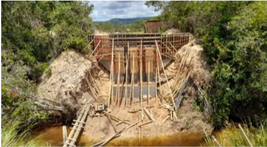
MONTAGEM DAS GAIOLAS
