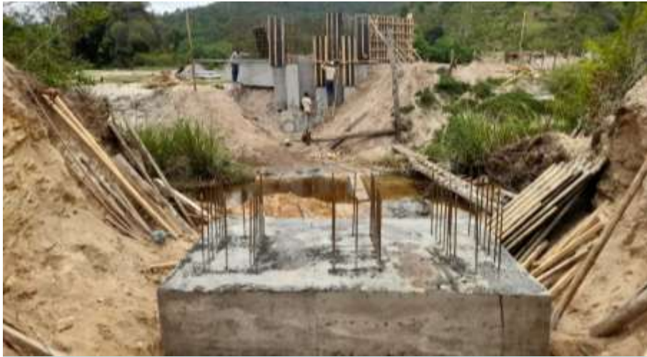
SAPATAS E ARRANQUE DOS PILARES
