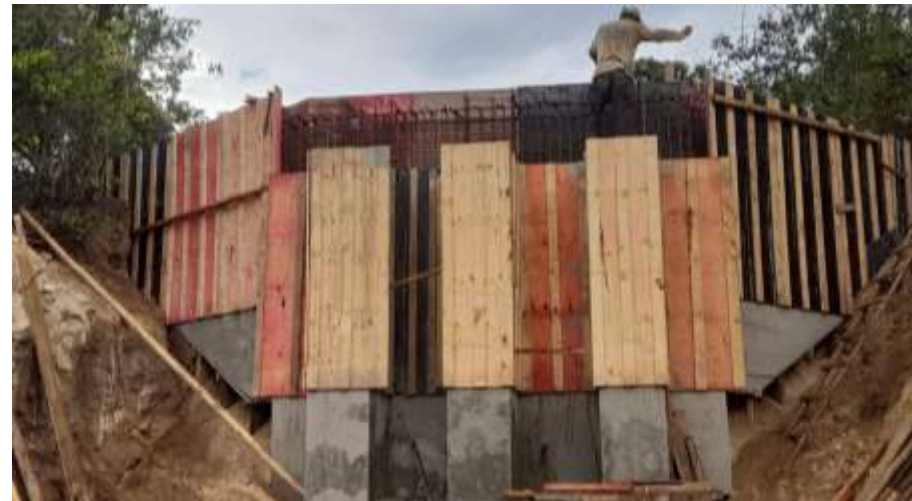
FORMAS PARA ULTIMA CONCRETAGEM
