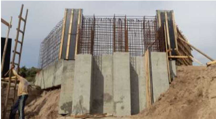
MONTAGEM DAS FORMAS DOS PILARES E CORTINA
