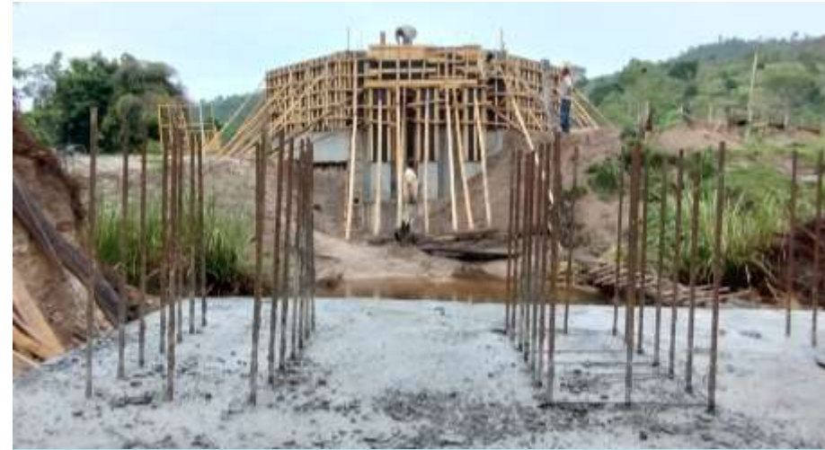
ARRANQUE DOS PILARES
