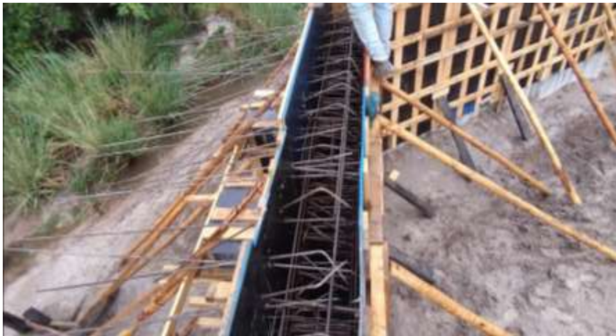
ARRANQUES DE FERRO PARA LAJE DA PONTE
