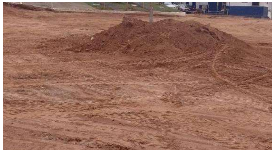
DEMOLIÇÃO E REGULARIZAÇÃO
