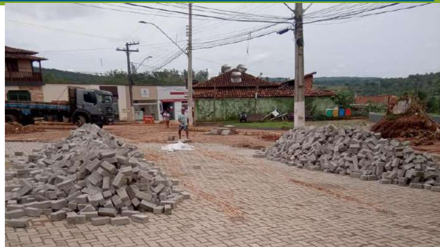
MATERIAL PARA REALIZAR CALCAMENTO
