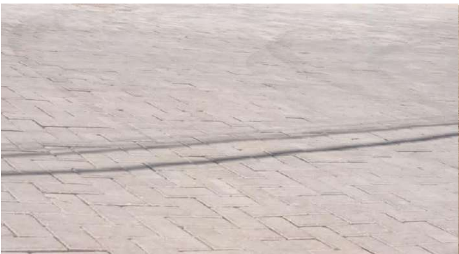
EXECUÇÃO DE CALCAMENTO
