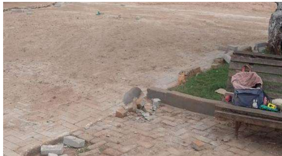
REMOÇÃO DE MEIO FIO ANTIGO PARA TROCA POR NOVO
