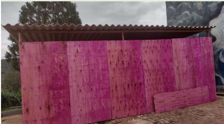
EXECUÇÃO DO BARRACAO DA OBRA
