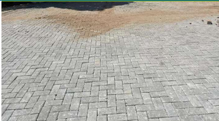
INICIO DE CALCAMENTO
