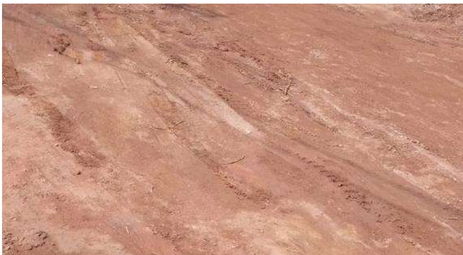
TERRAPLANAGEM E MOVIMENTAÇÃO DE TERRA
