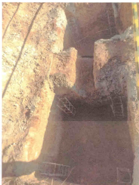
Foto 07 – ESTACAS FUNDAÇÃO
