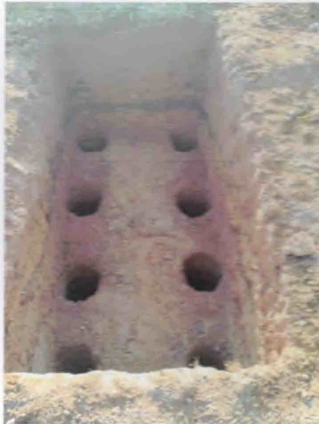
Foto 03 – FUNDAÇÃO PARA BLOCO E ESTACAS
