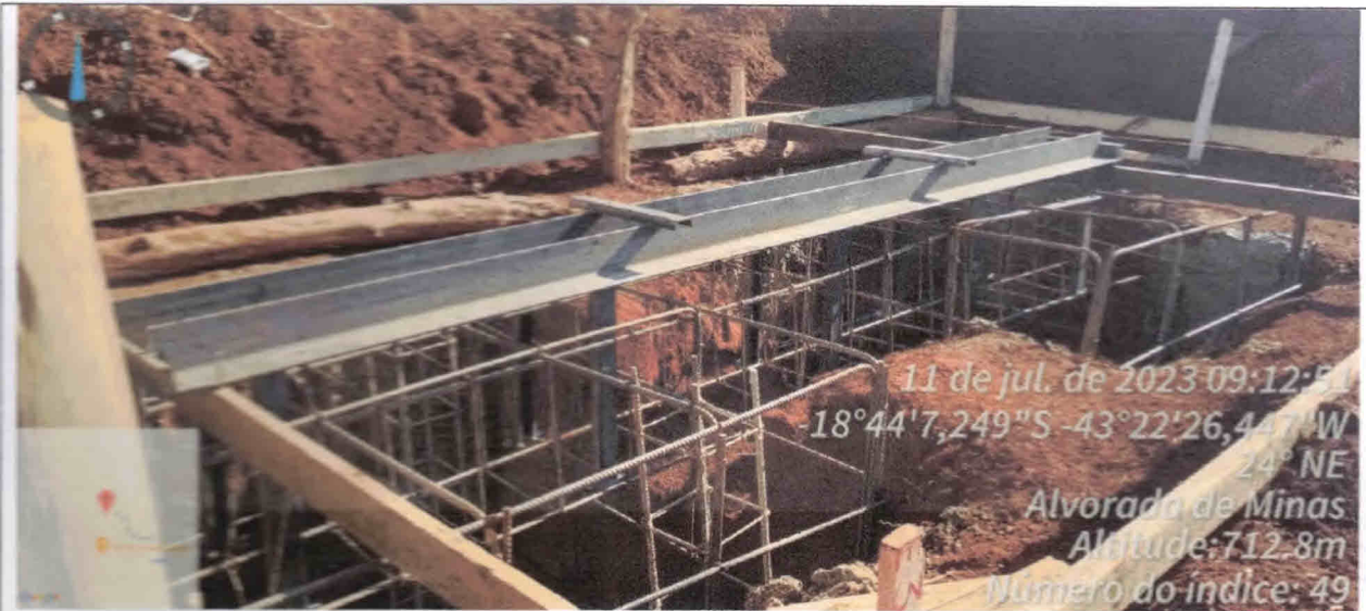
Foto 11 – fixação da base da estrutura metálica
