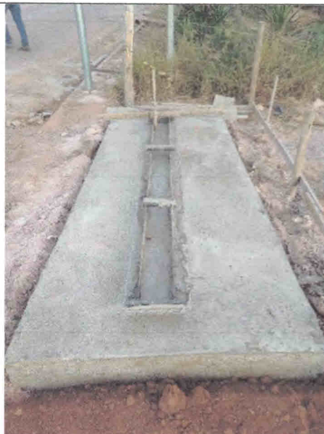
Foto 08 – BASE DE CONCRETO E BASE DA ESTRUTURA METALICA RUA DO SERRO
