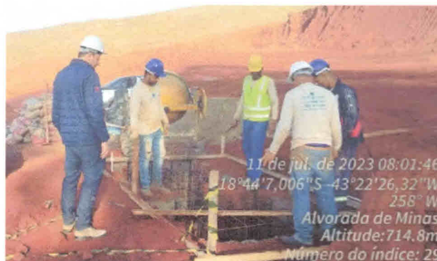
Foto 10 – PREPARAÇÃO DA FERRAGEM DOS BLOCOS DE FUNDAÇÃO
