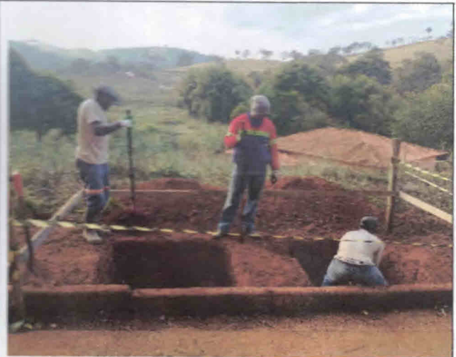
Foto 04 – ESCAVAÇÃO PARA FUNDAÇÃO FAZENDA DA PONTE
