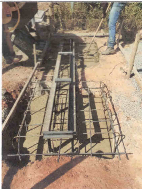
Fotos 05 – BLOCO DE CONCRETO COM BASE PARA ESTRUTURA METÉLICA
