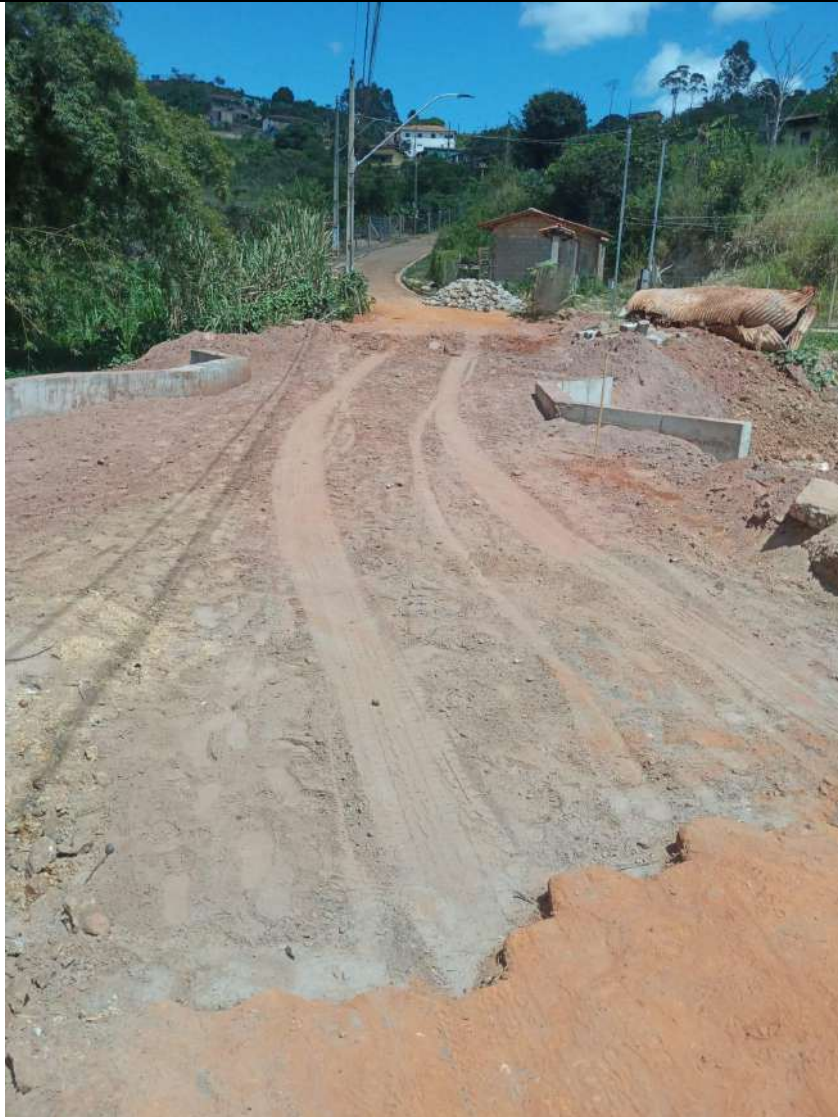
Aterro e compactação da obra- Conclusão
