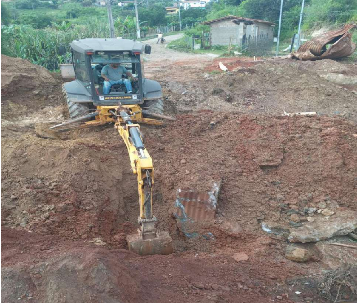
Limpeza do terreno/Remoção do tubo de ferro existente
