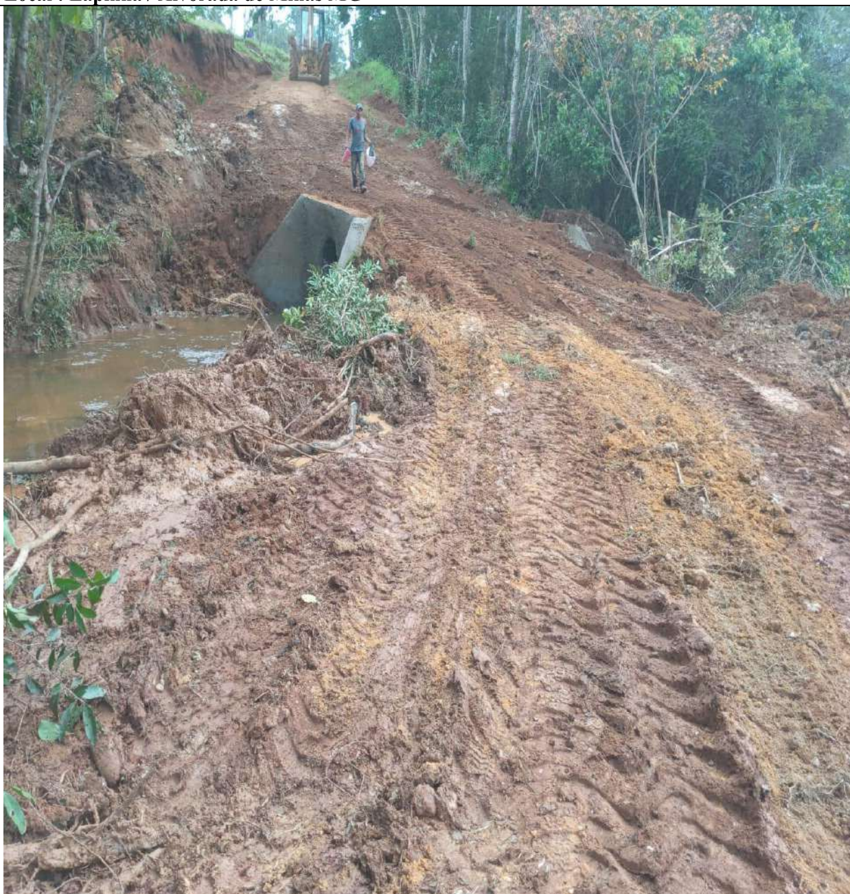
Conclusão da obra
