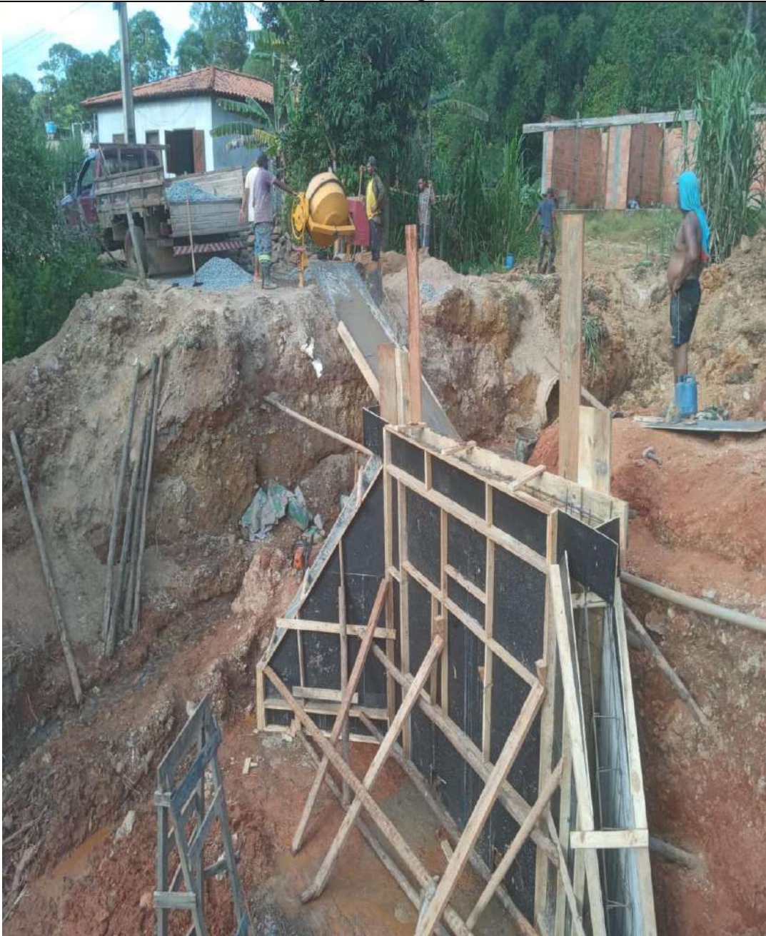
Montagem de forma e Concretagem
