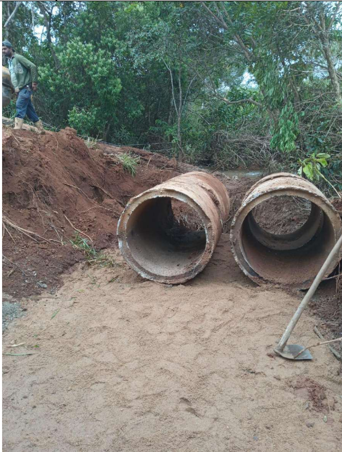
Remoção da manilhas existentes com reaproveitamento
