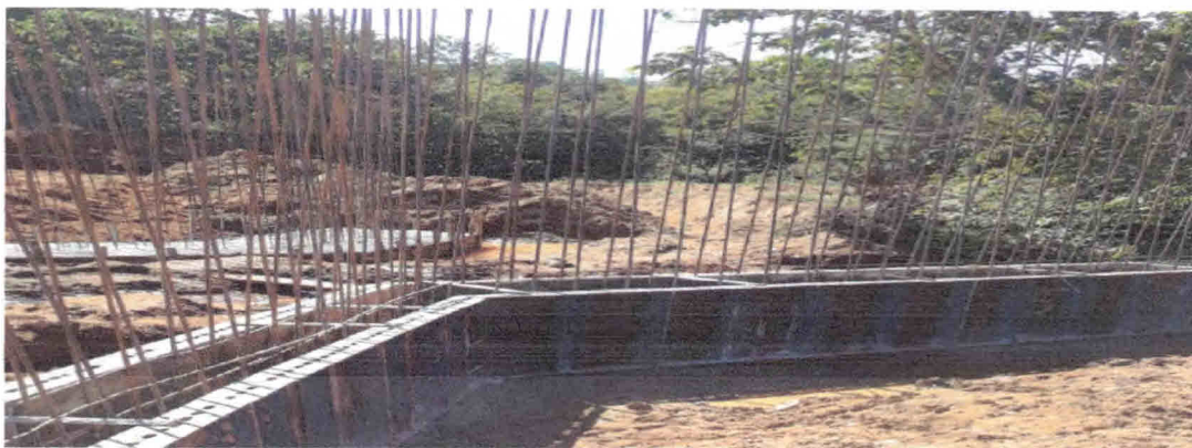
FIGURA 4 FORMAS E PREPARAÇÃO PARA CONCRETAGEM DA MESO ESTRUTURA
