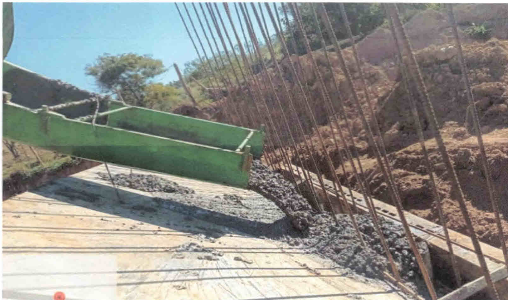
FIGURA 5 INICIO DA CONCRETAGEM DA MESO ESTRUTURA
