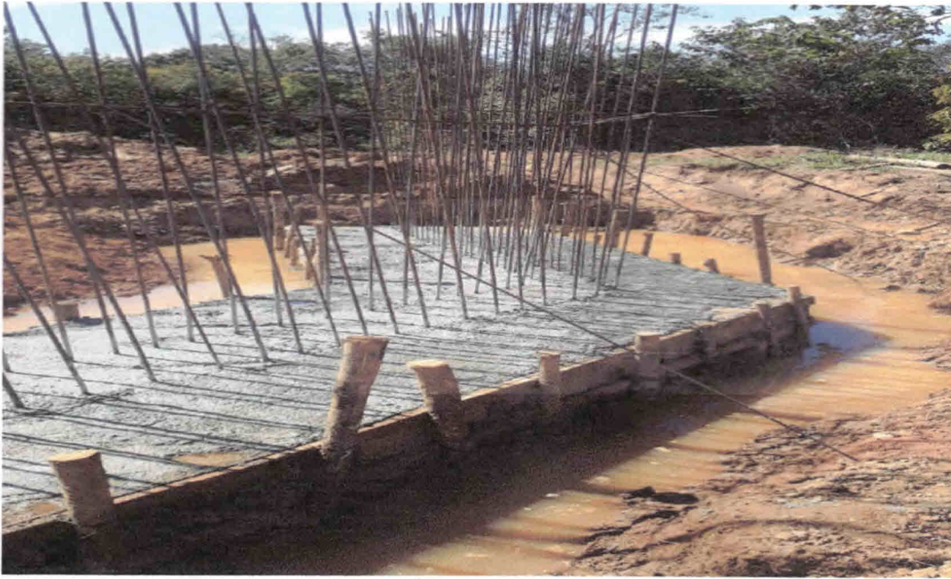
FIGURA 3 CONCRETAGEM DA FUNDAÇÃO E FERRAGEM DA MESO ESTRURURA
