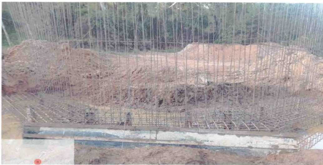
FIGURA 1 ARMAÇÃO DA FUNDAÇÃO
