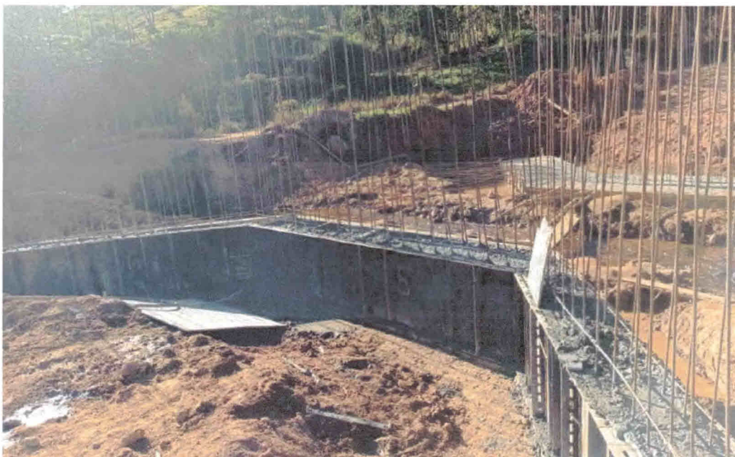
FIGURA 6 CONCRETAGEM E FERRAGEM DA MESO ESTRUTURA.
