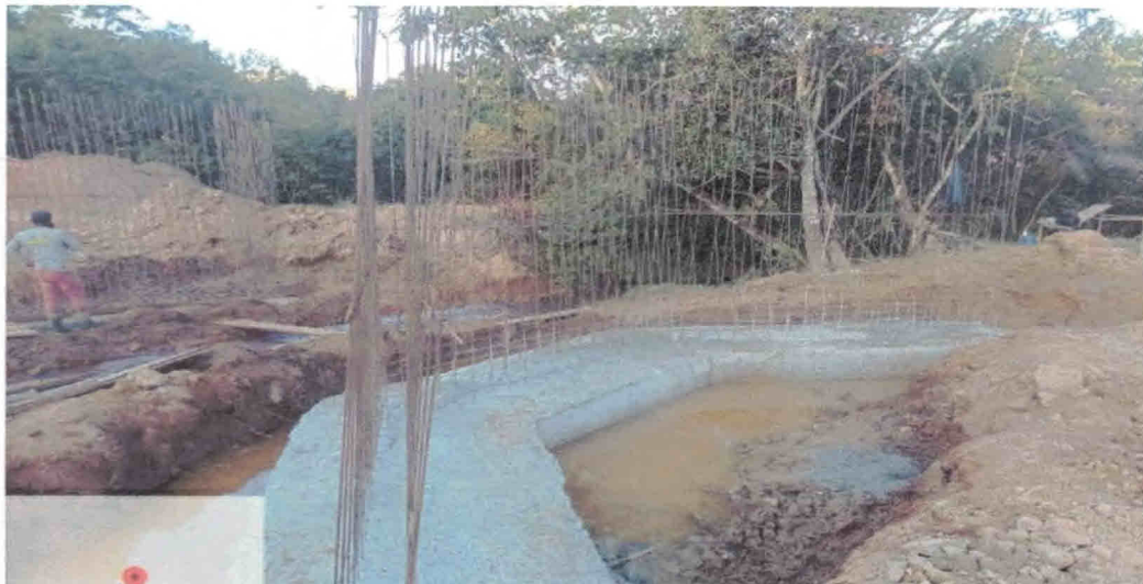
FIGURA 2 – ARMAÇÃO FUNDAÇÃO AS DUAS MARGENS E CONCRETAGEM
