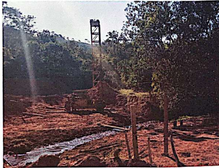
FIGURA 9 – CRAVAÇÃO DE ESTACAS
