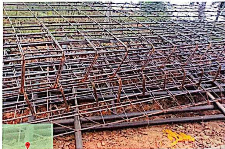
FIGURA 4 - FERRAGENS DA FUNDAÇÃO
