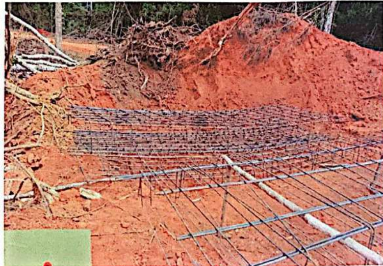
FIGURA 6 - FERRAGENS FUNDAÇÃO
