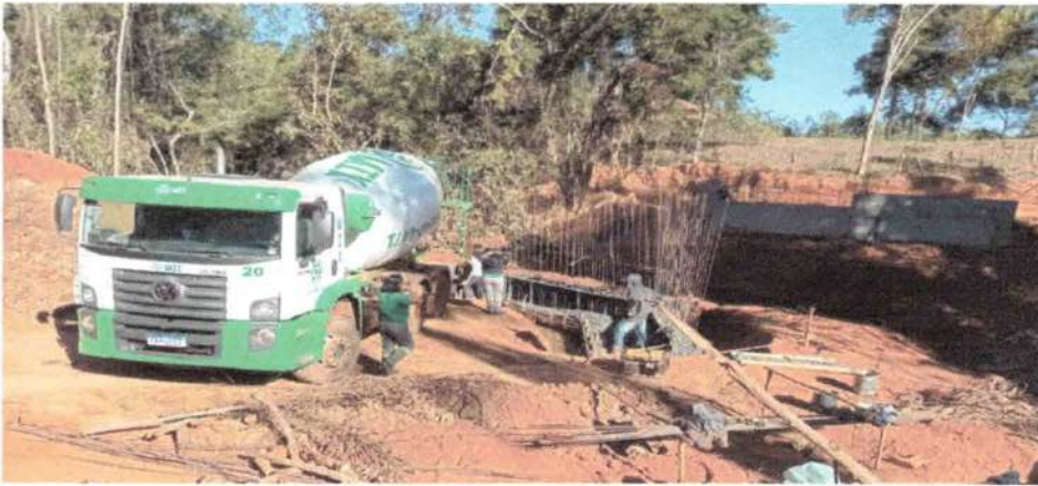
1ª Figura- Concretagem da fundação
