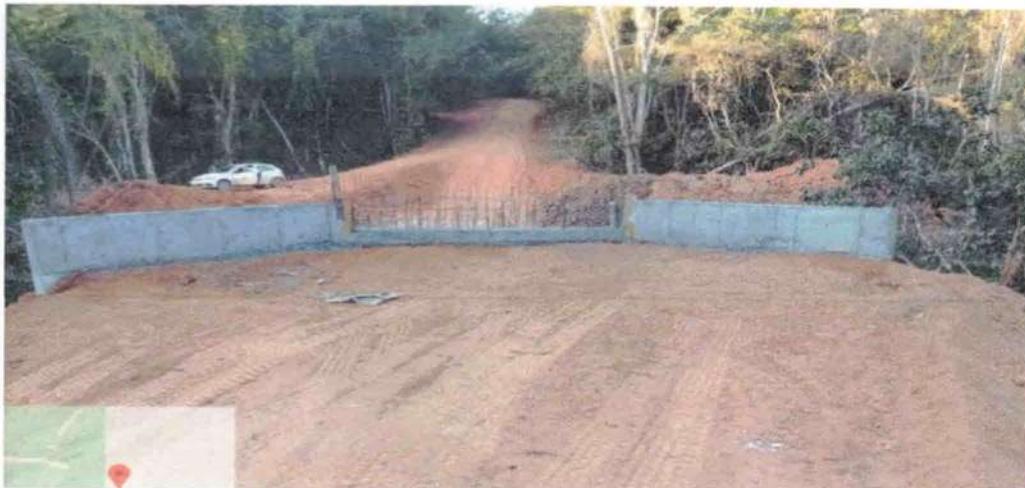
5ª Figura - Meso estrutura concretada a ponto de vigas/perfil
