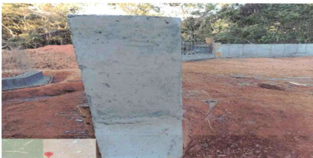
4ª Figura - Meso estrutura concretada
