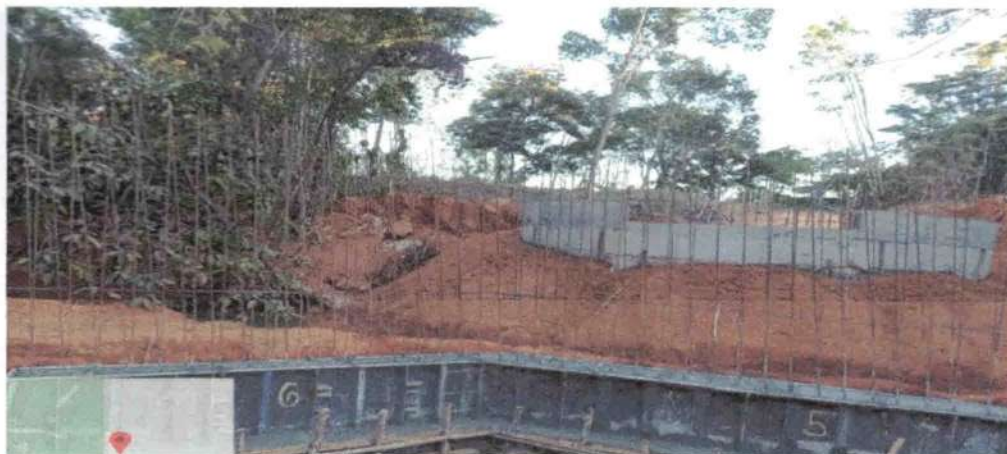
3ª Figura - Meso estrutura formas e ferragens
