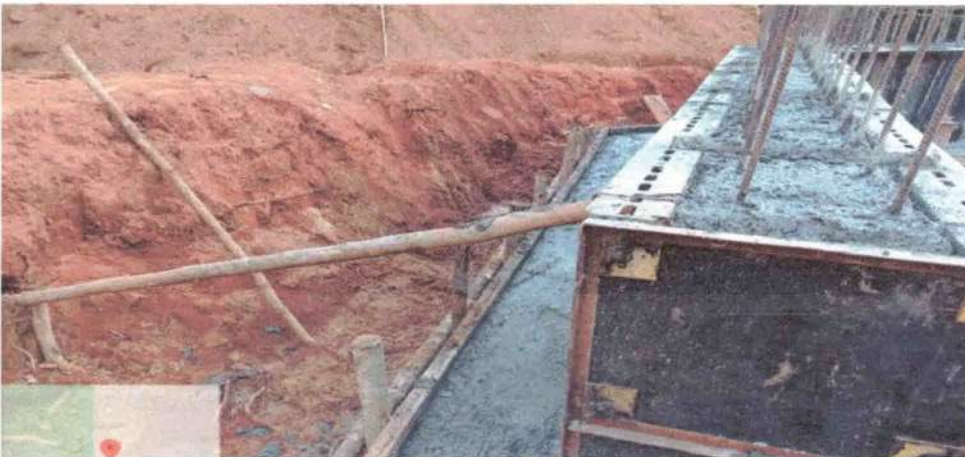
2ª Figura - Concretagem final da fundação
