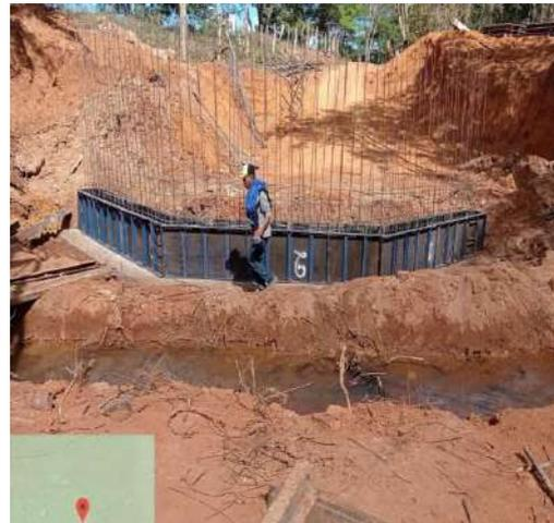
*Figura 8 FERRAGENS COM ARRANQUES DA MESO*
