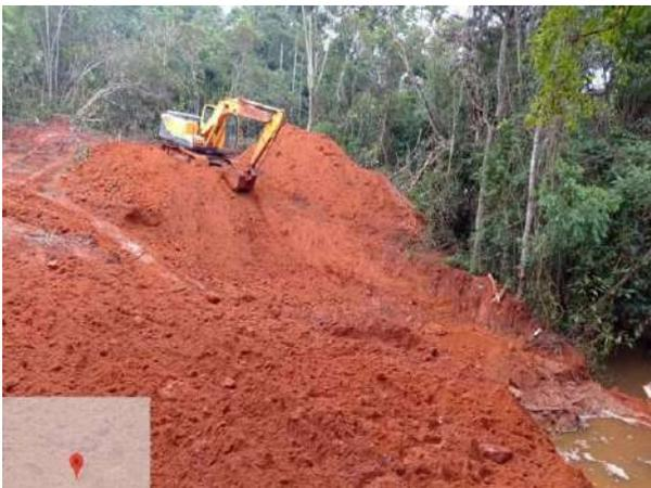
**Figura 1 ESCAVAÇÃO MECANIZADA**
