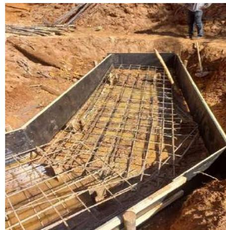
**Figura 4 FORMAS DA SAPATAS (FUNDAÇÃO)**
