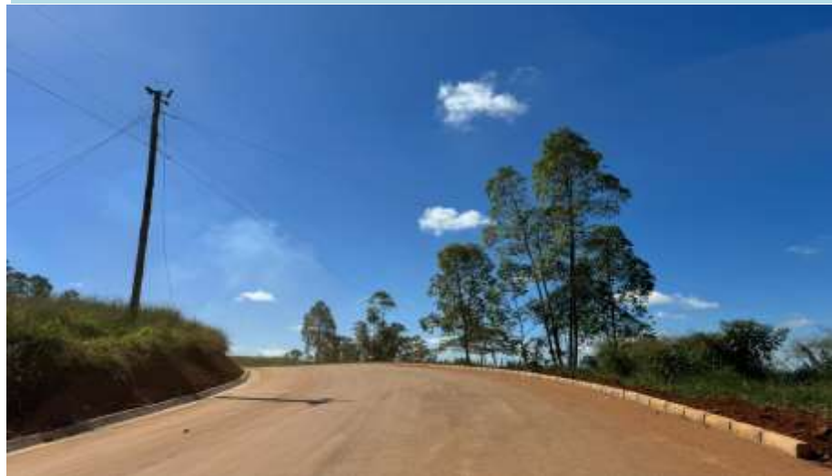
EXECUÇÃO DE MEIO-FIO E-270 A E-356
