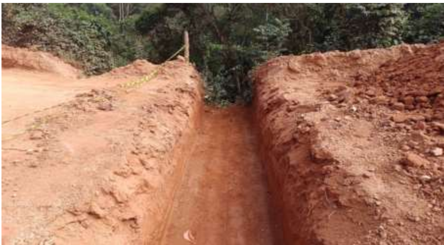
EXECUÇÃO DE BUEIROS E187
