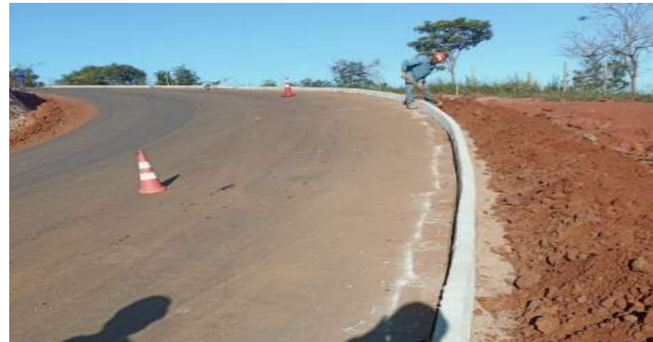
EXECUÇÃO DE MEIO-FIO E-270 A E-356
