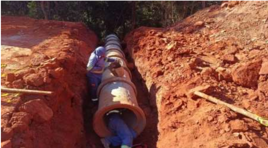
EXECUÇÃO DE BUEIROS E187
