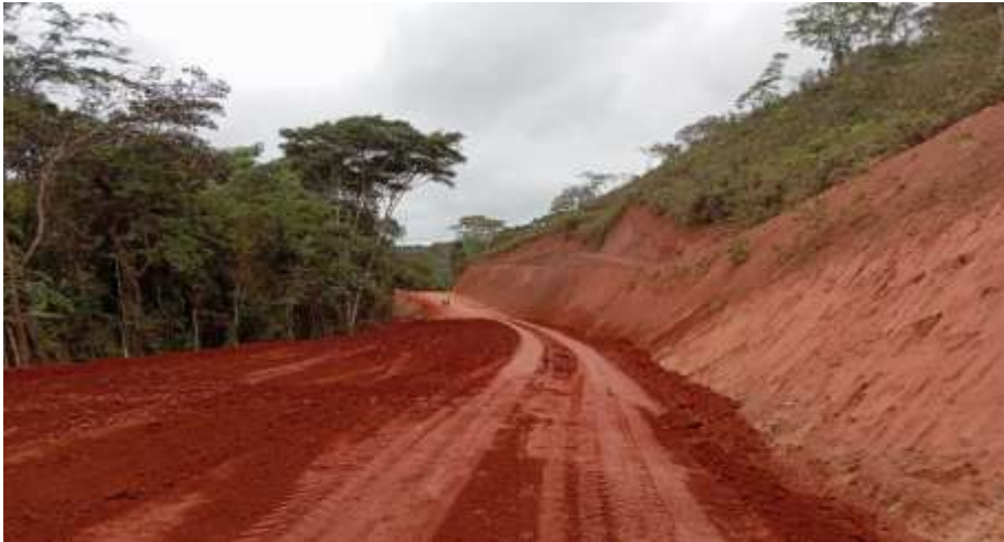
ACABAMENTO DE TERRAPLENAGEM E164 A E195
