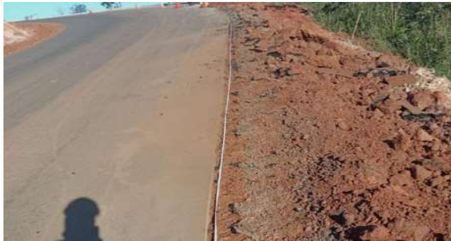
EXECUÇÃO DE MEIO-FIO E-270 A E-356
