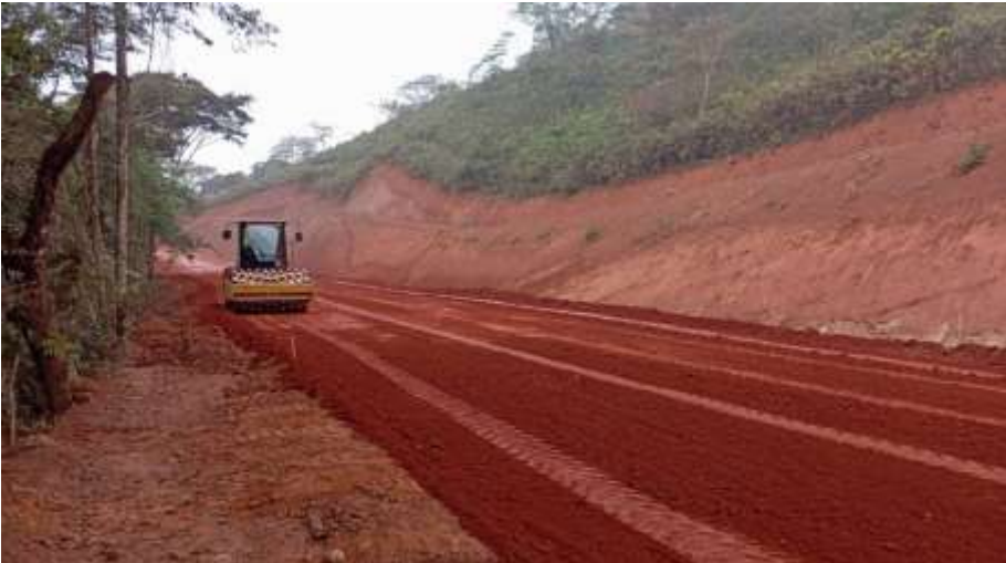
ACABAMENTO DE TERRAPLENAGEM E164 A E195
