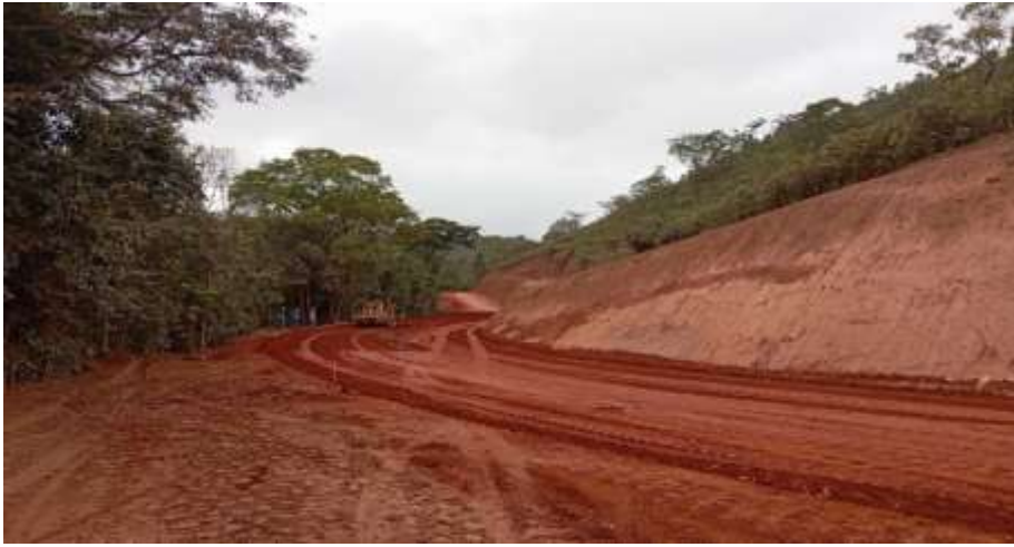
ACABAMENTO DE TERRAPLENAGEM E164 A E195
