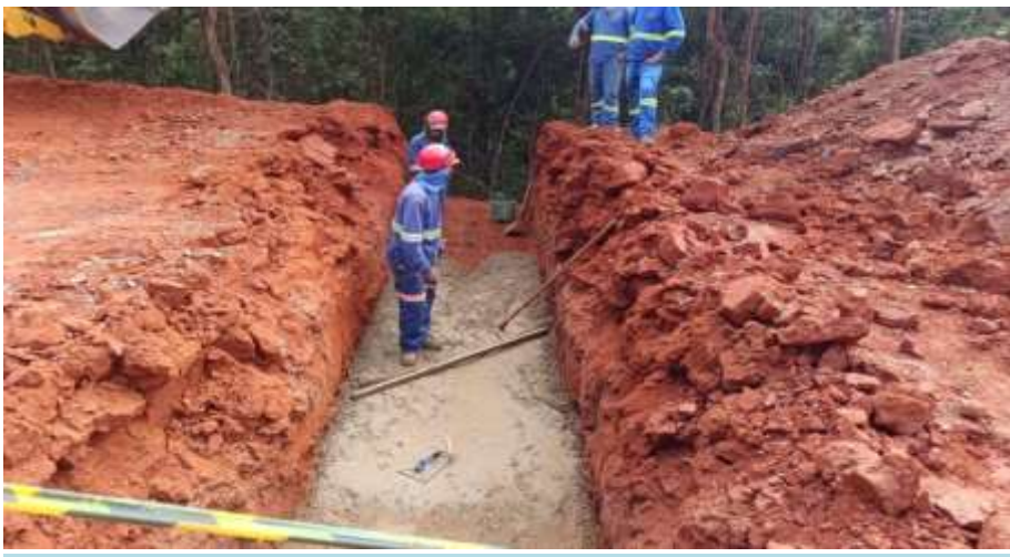
EXECUÇÃO DE BUEIROS E187
