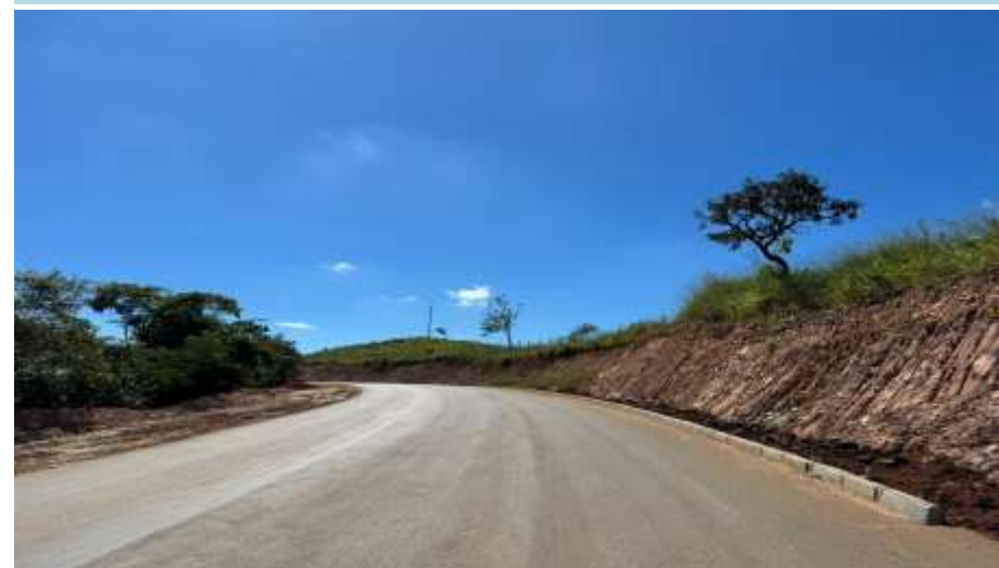
EXECUÇÃO DE MEIO-FIO E-270 A E-356
