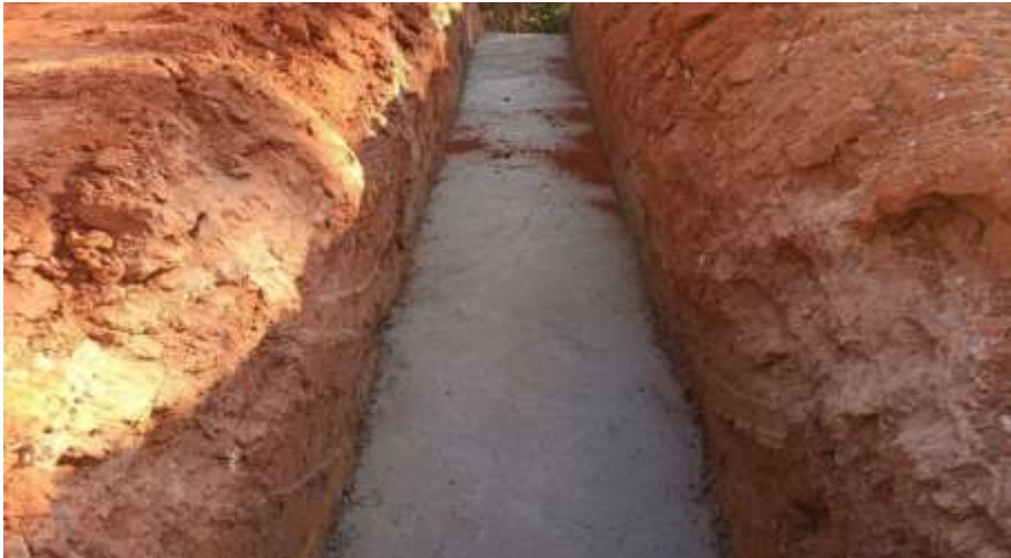
EXECUÇÃO DE BUEIROS E187
