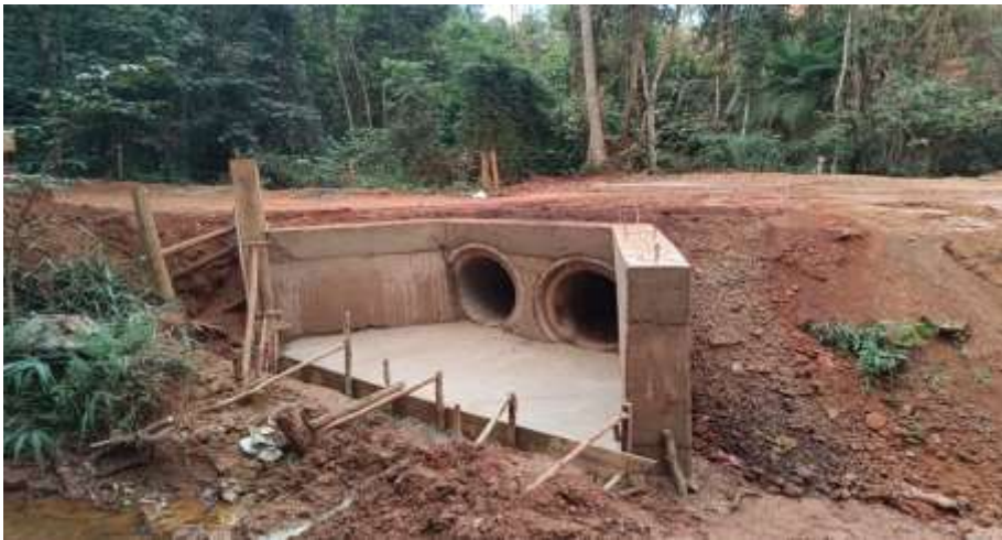
BOCA DE BDTC 1000MM E-203 BE ENTRADA DA ANGLO
