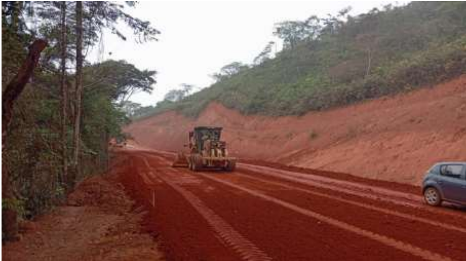
ACABAMENTO DE TERRAPLENAGEM E164 A E195
