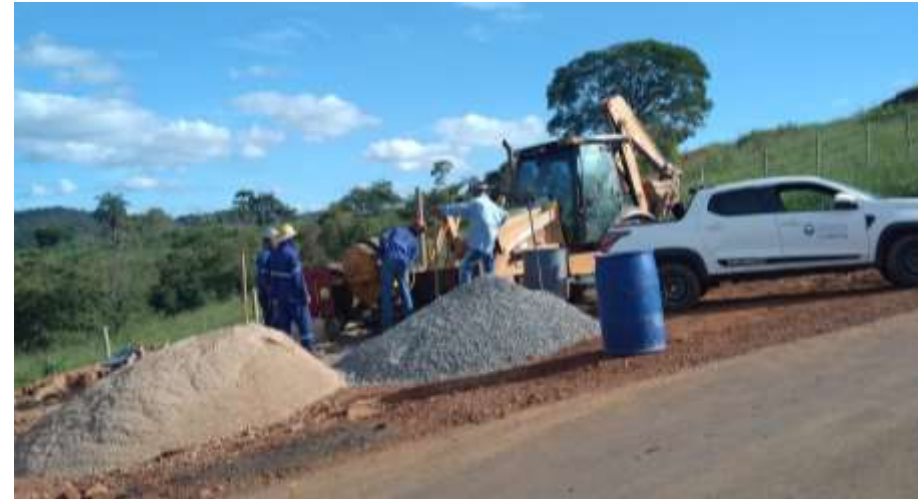
EXECUÇÃO DESARJETA E325+10 A E362
