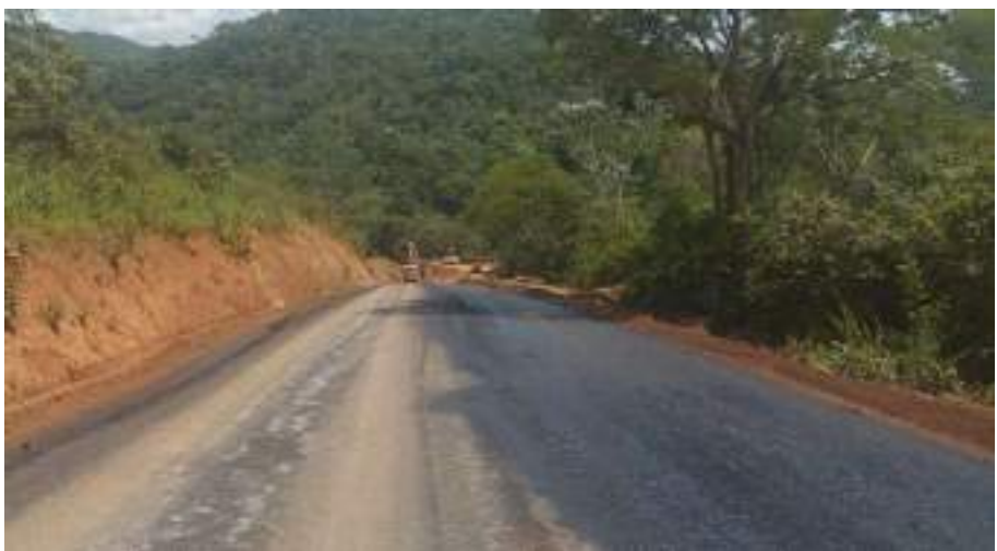
EXECUÇÃO DE IMPRIMAÇÃO E PINTURA E210 A E246
