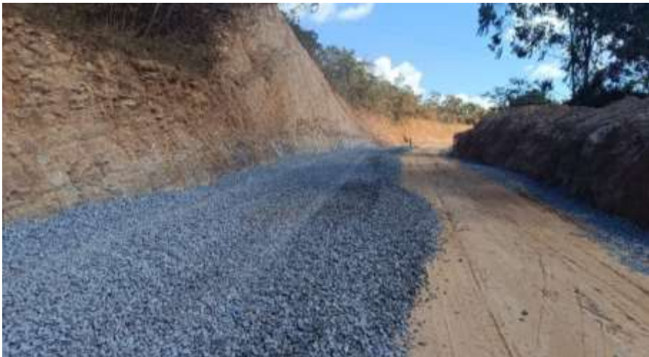
CAMADA HORIZONTAL DRENANTE E241 + 246+10
