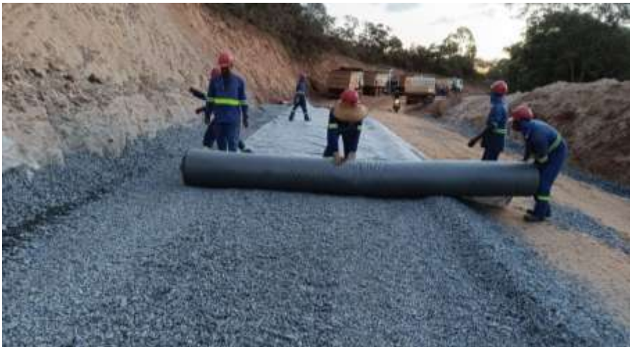
CAMADA HORIZONTAL DRENANTE E241 + 246+10
