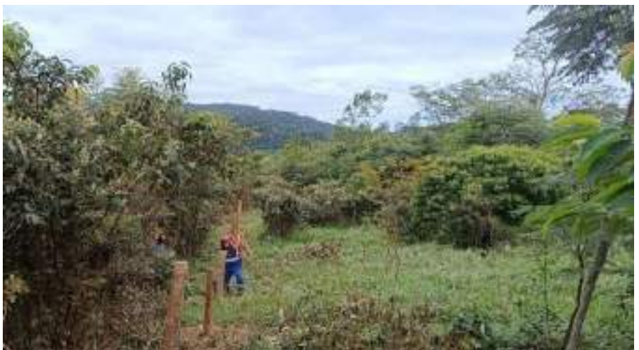
EXECUÇÃO DE CERCA E162 A E231
