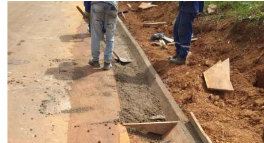
EXECUÇÃO DESARJETA E325+10 A E362
