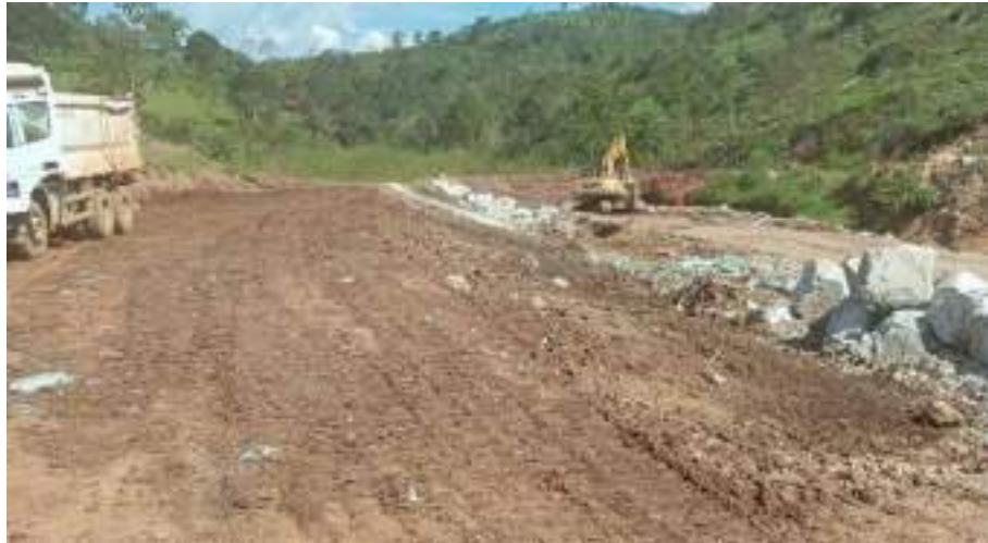
EXECUÇÃO DE BERÇO PARA CORPO BDTc – 1000 MM
