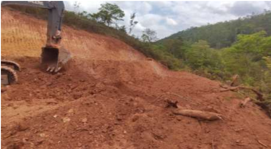
EXECUÇÃO DE CORTE E219-E200
