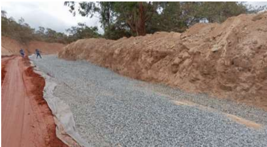
CAMADA HORIZONTAL DRENANTE E241 + 246+10
