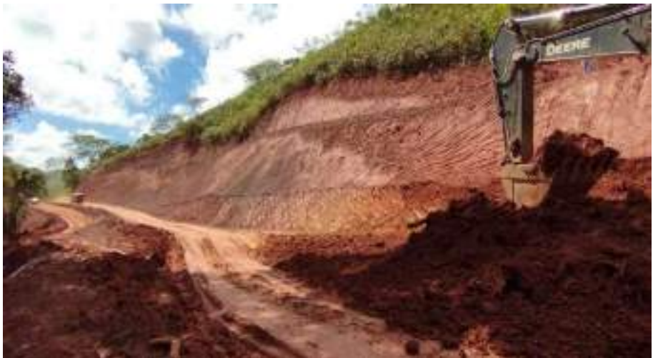
EXECUÇÃO DE CORTE E160-E200
