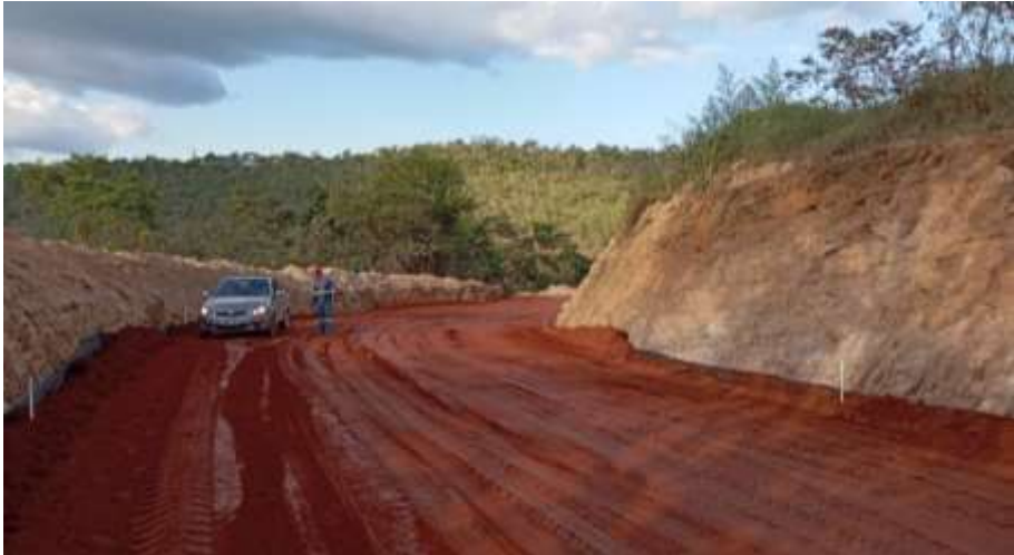
EXECUÇÃO DO SUB BASE E 239 A E 246
