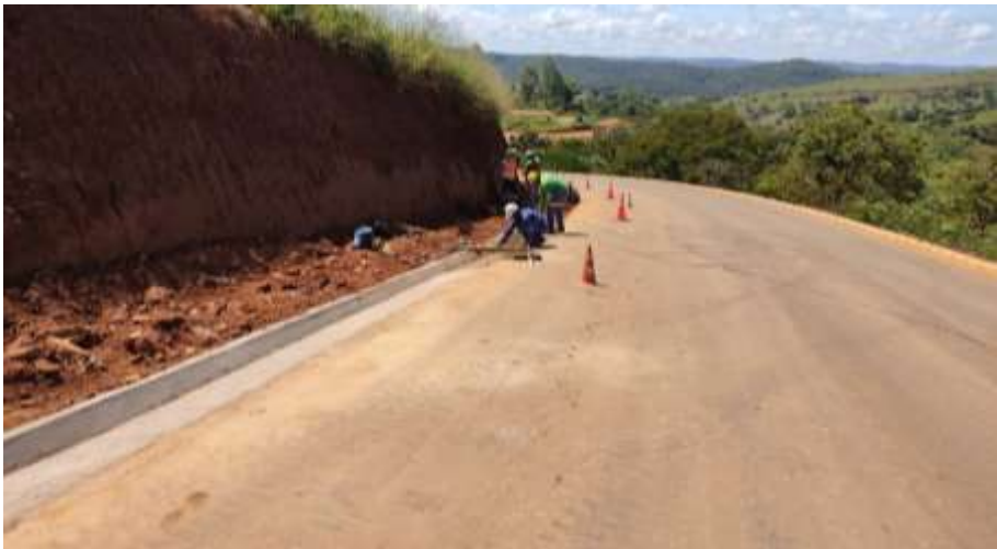
EXECUÇÃO DESARJETA E325+10 A E362
