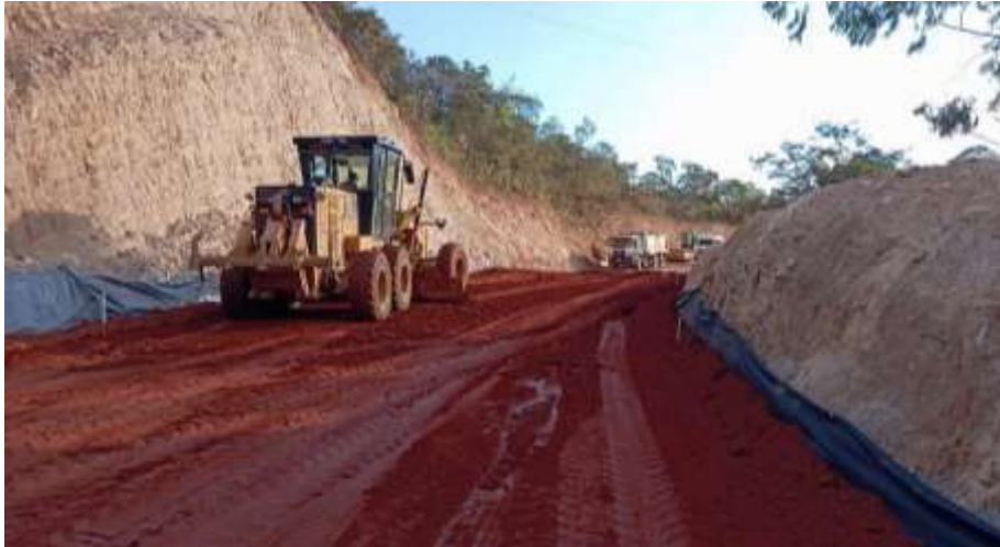
EXECUÇÃO DO SUB BASE E 239 A E 246
