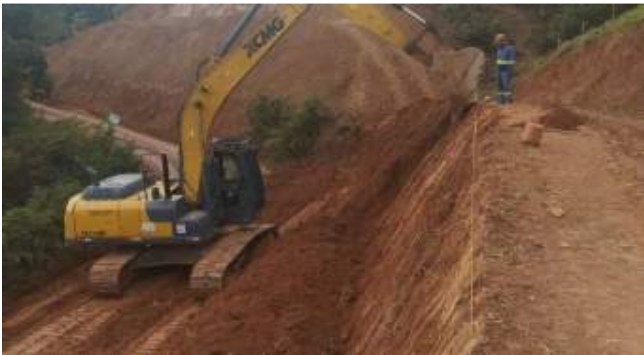
EXECUÇÃO DE CORTE E160-E200
