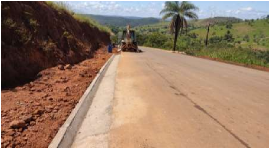
EXECUÇÃO DESARJETA E325+10 A E362
