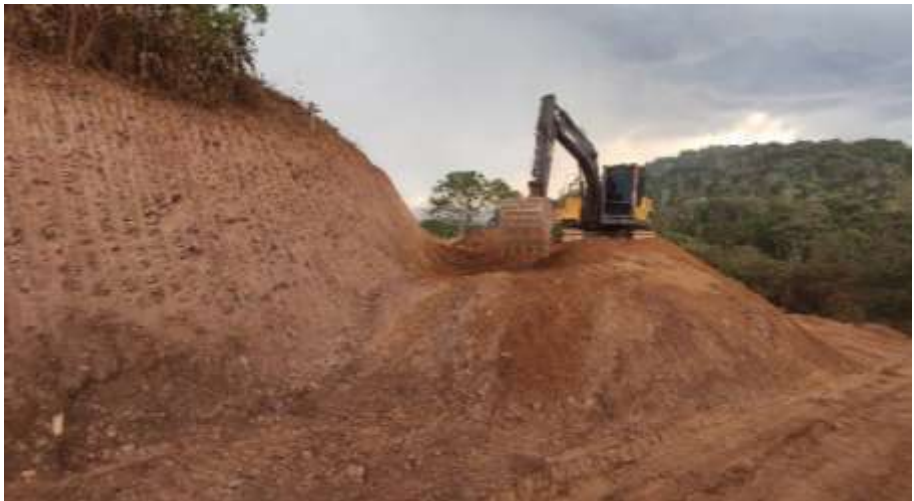
EXECUÇÃO DE CORTE E219-E200
