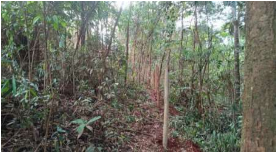
EXECUÇÃO DE CERCA E162 A E231
