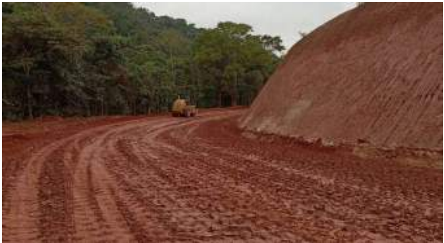
EXECUÇÃO DE ATERRO E160-E200
