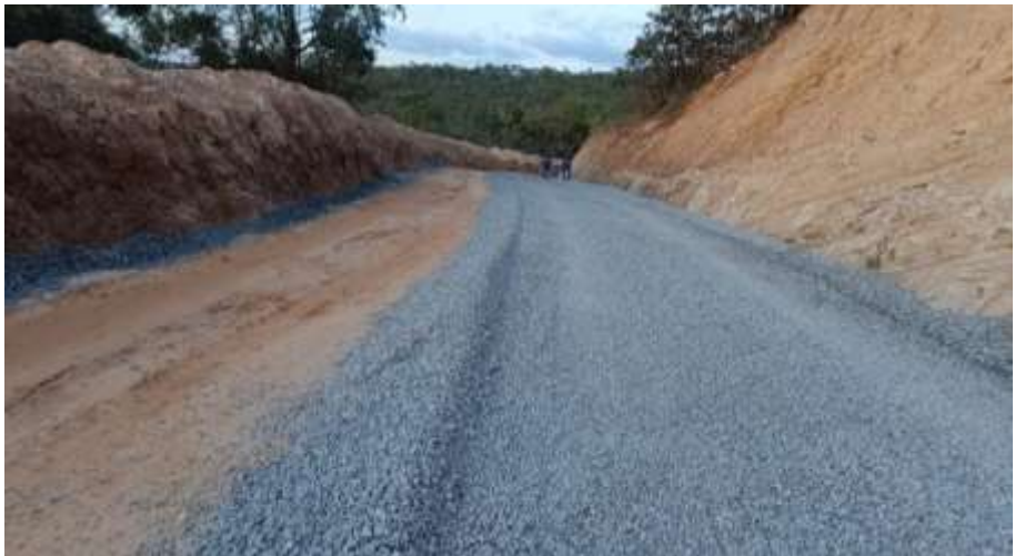
CAMADA HORIZONTAL DRENANTE E241 + 246+10
