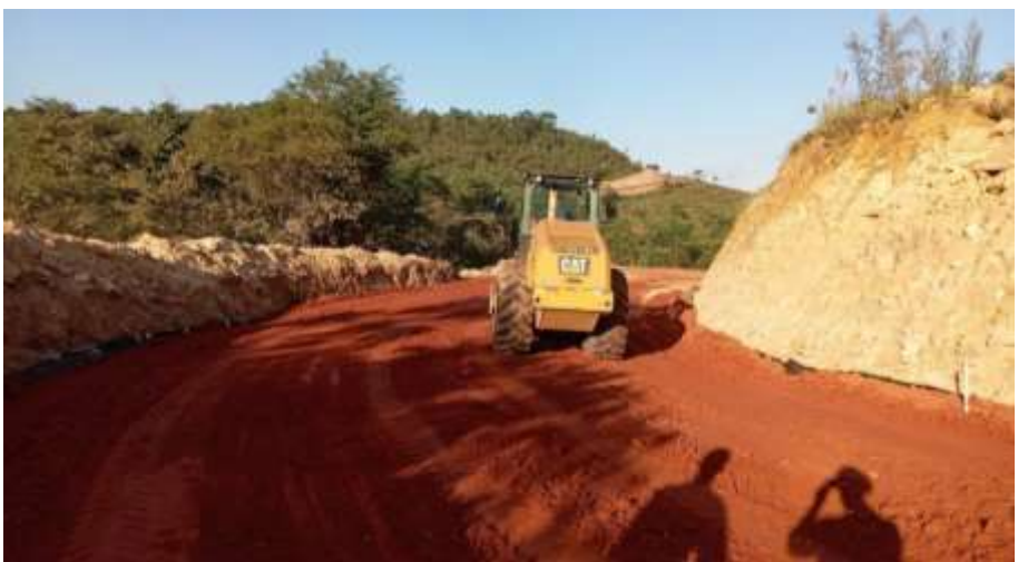
EXECUÇÃO DE BASE E 239 A E 246
