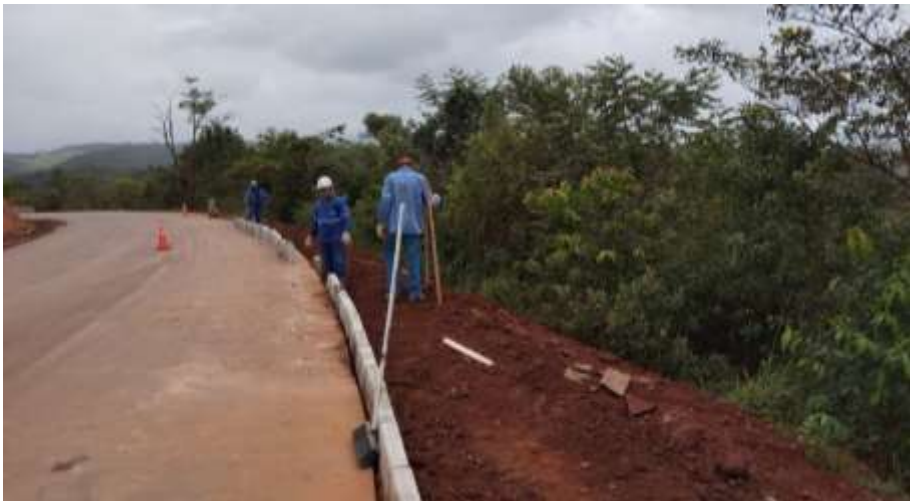
EXECUÇÃO DE MEIO-FIO E302 A E309 BE
