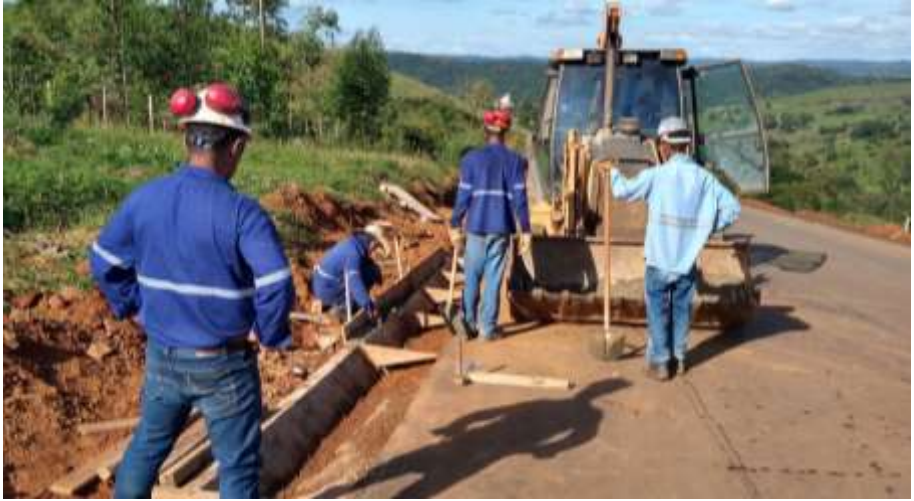
EXECUÇÃO DESARJETA E325+10 A E362
