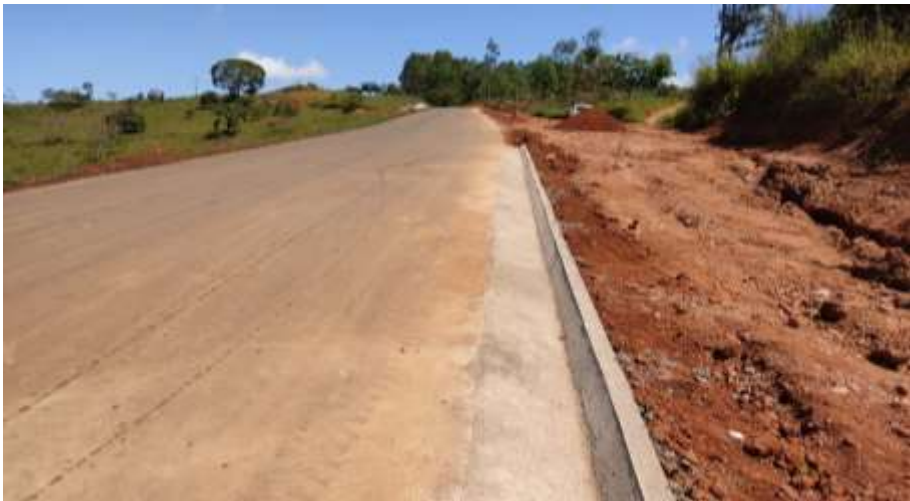
EXECUÇÃO DESARJETA E325+10 A E362
