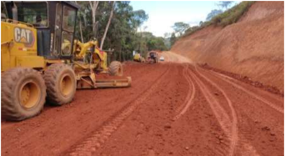
EXECUÇÃO DE ATERRO E160-E200
