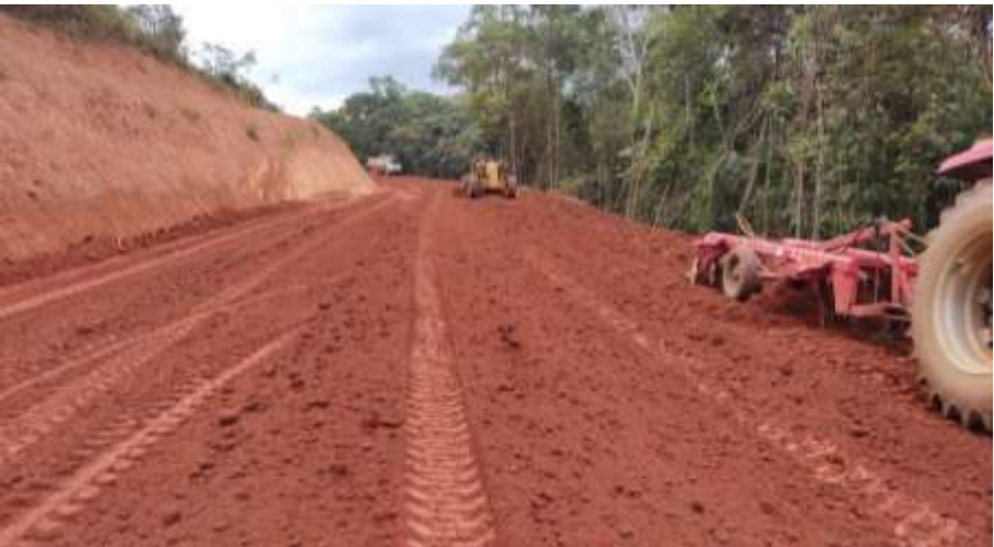
EXECUÇÃO DE ATERRO E160-E200
