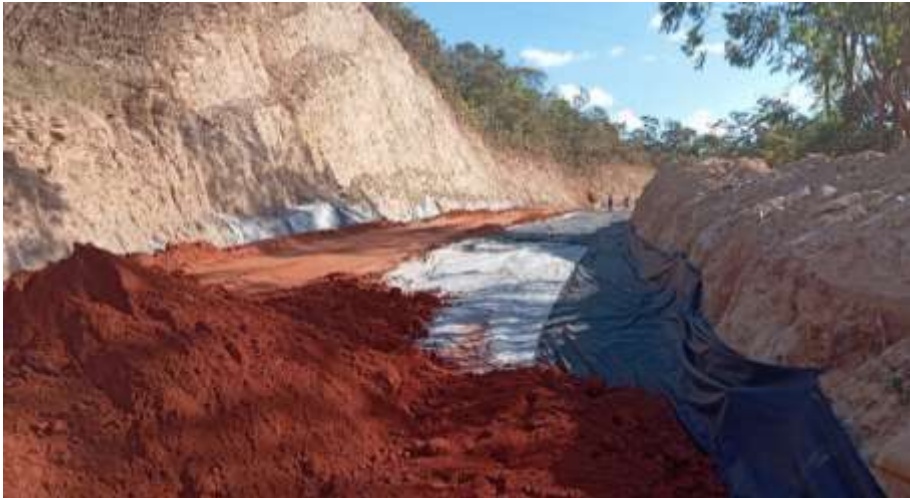
EXECUÇÃO DO SUBLEITO E 238 A E 246
