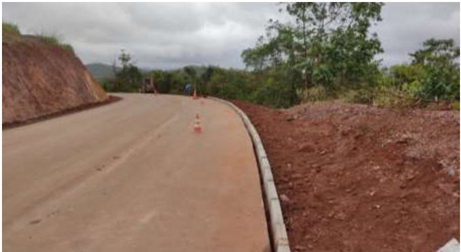
EXECUÇÃO DE MEIO-FIO E302 A E309 BE
