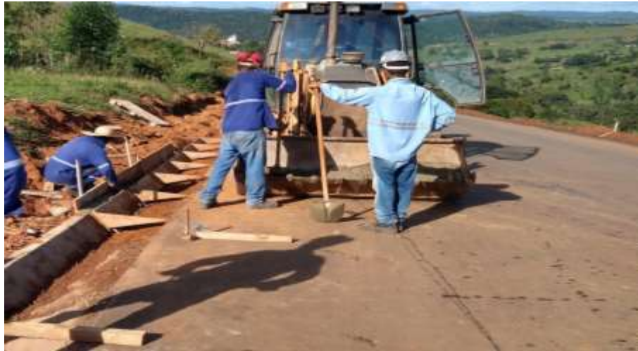
EXECUÇÃO DESARJETA E325+10 A E362
