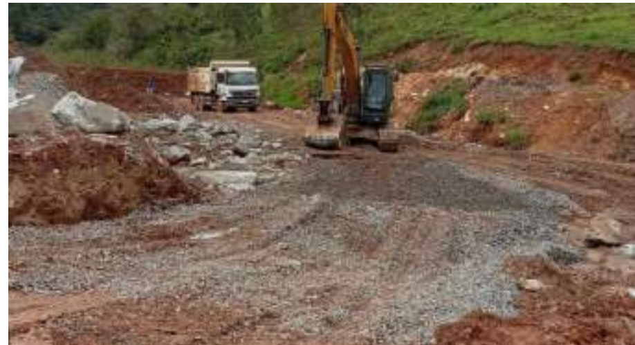
EXECUÇÃO DE BERÇO PARA CORPO BDTc – 1000 MM
