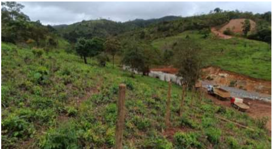
EXECUÇÃO DE CERCA E162 A E231
