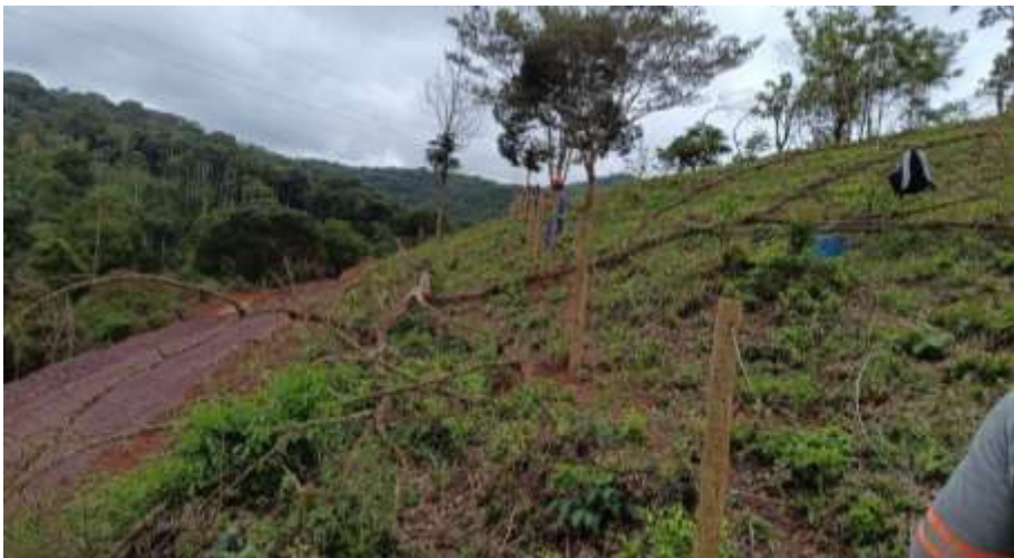
EXECUÇÃO DE CERCA E162 A E231
