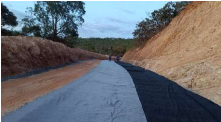
CAMADA HORIZONTAL DRENANTE E241 + 246+10
