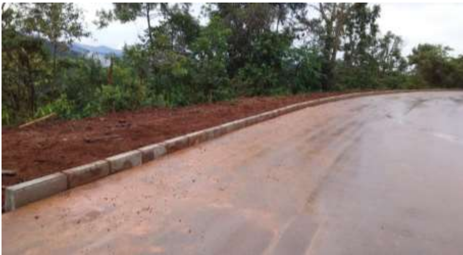
EXECUÇÃO DE MEIO-FIO E302 A E309 BE
