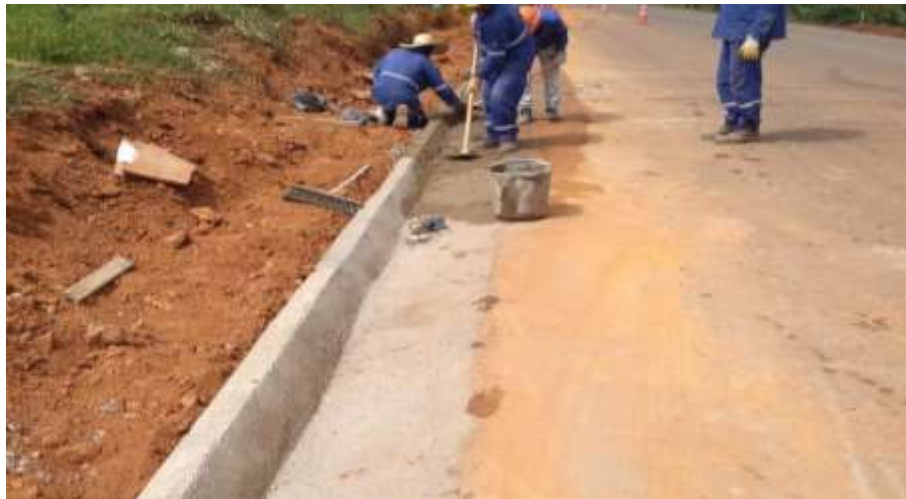
EXECUÇÃO DESARJETA E325+10 A E362
