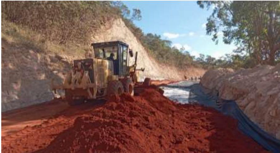
EXECUÇÃO DO SUBLEITO E 238 A E 246
