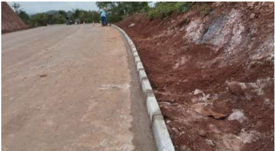
EXECUÇÃO DE MEIO-FIO E302 A E309 BE
