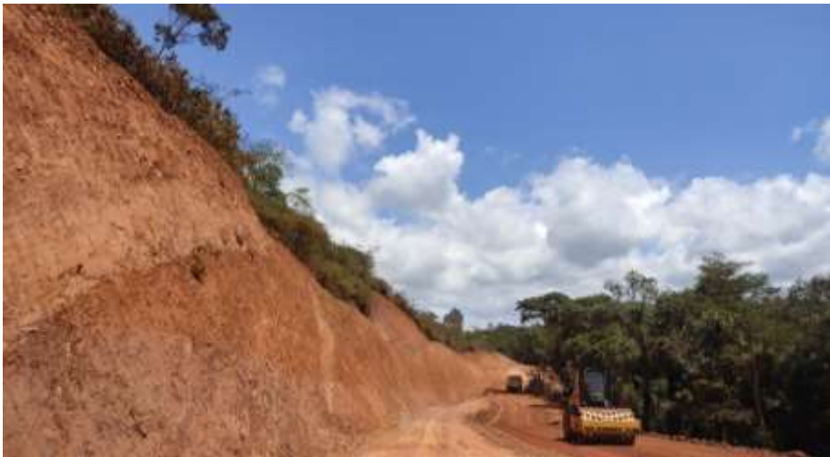
EXECUÇÃO DE ATERRO E160-E200
