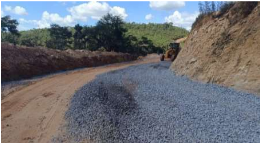
CAMADA HORIZONTAL DRENANTE E241 + 246+10
