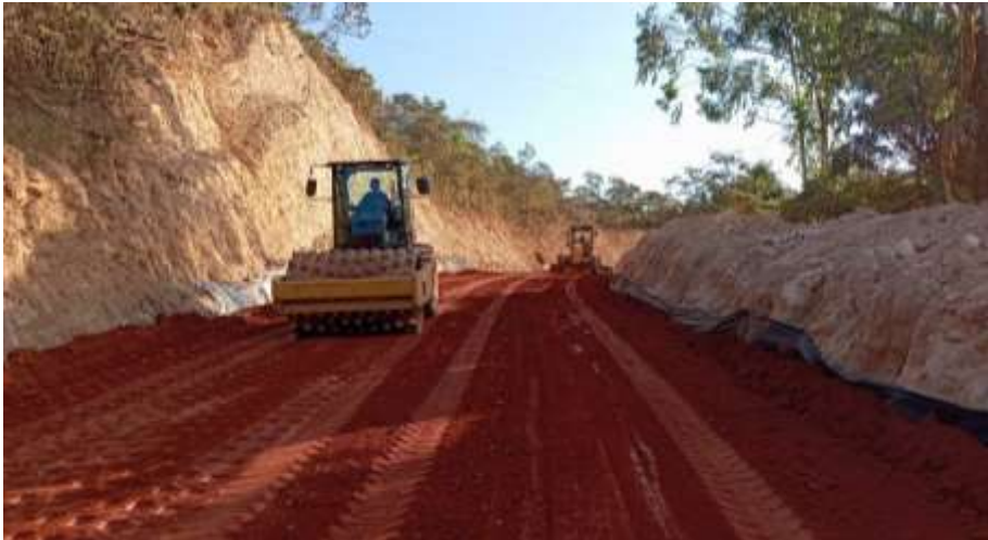
EXECUÇÃO DE BASE E 239 A E 246
