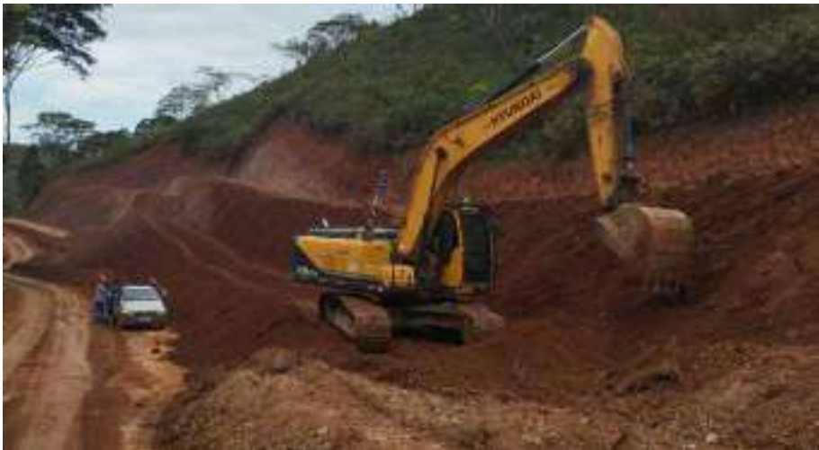
EXECUÇÃO DE CORTE E160 A 190
