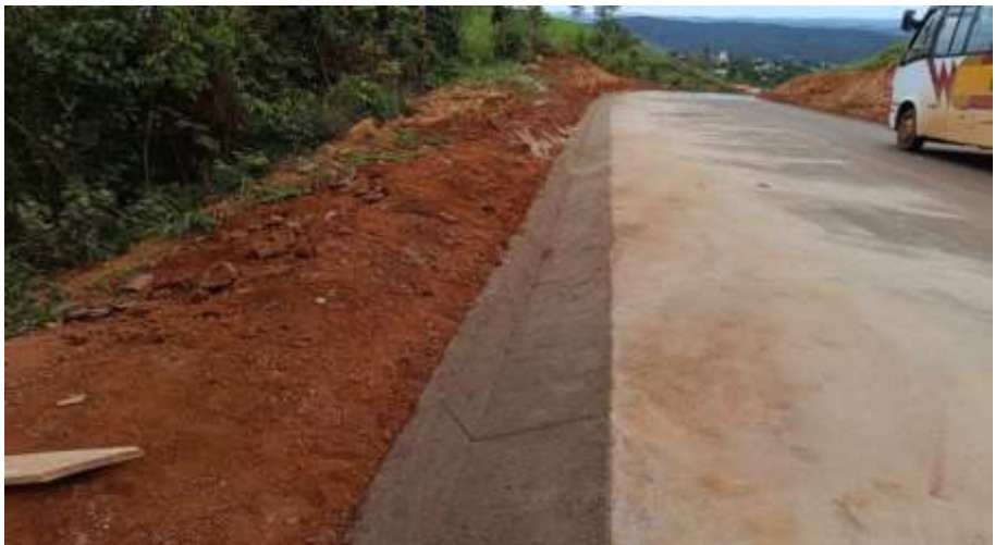
EXECUÇÃO DE SSCC60/15 E320+18,4-E325+10,3 BE
