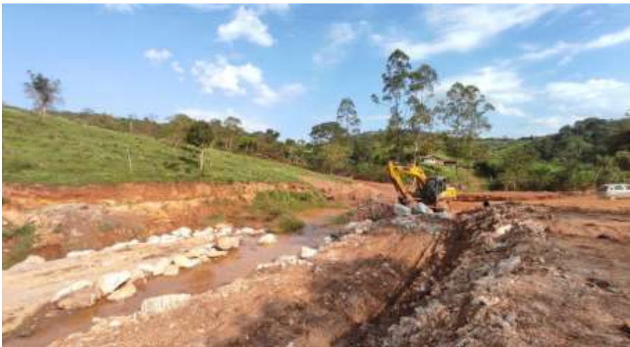
LIMPEZA DE SOLO MOLE E EXECUÇÃO DE ENRONCAMENTO
