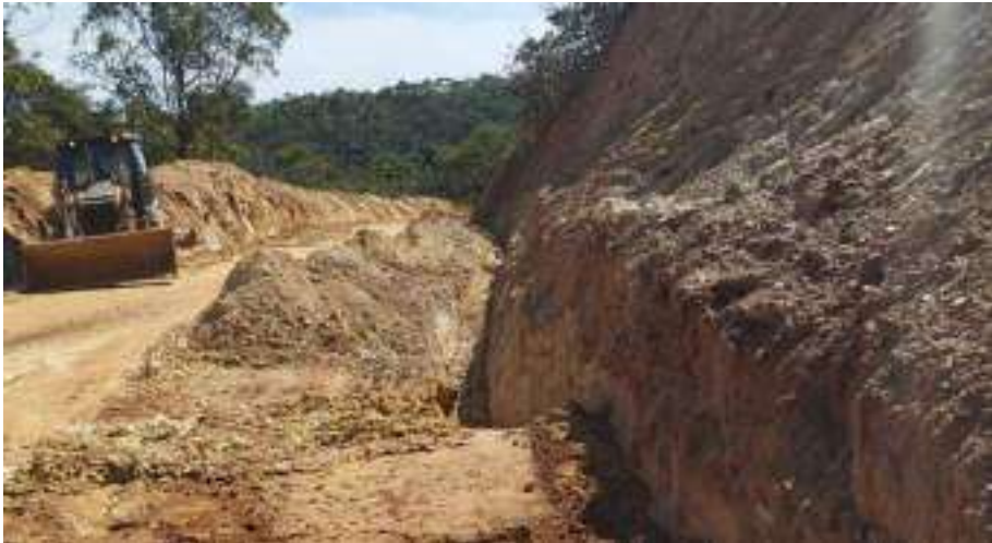
EXECUÇÃO DE CORTE 3º CATEGORIA E240-E246
