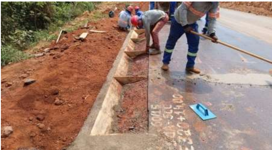
EXECUÇÃO DE SSCC60/15 E320+18,4-E325+10,3 BE
