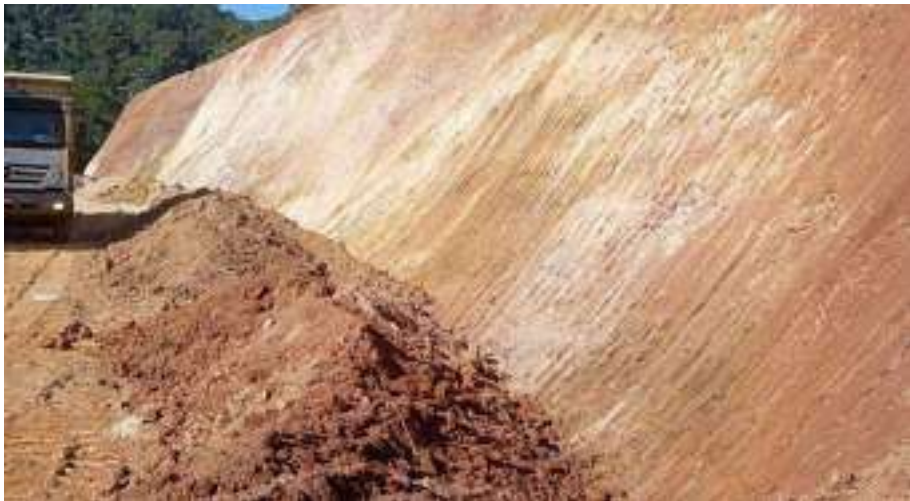
EXECUÇÃO DE CORTE E160 A E190
