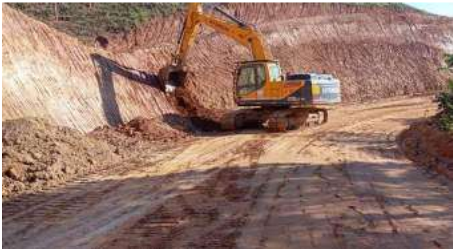
EXECUÇÃO DE CORTE E160 A E190
