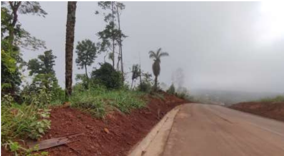
EXECUÇÃO DE SSCC60/15 E320+18,4-E325+10,3 BE
