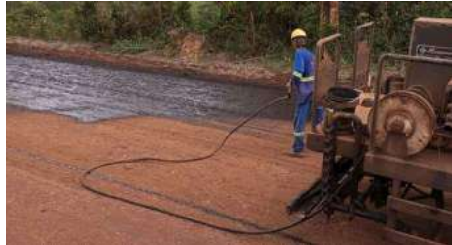
EXECUÇÃO DE IMPRIMAÇÃO E221 A E239
