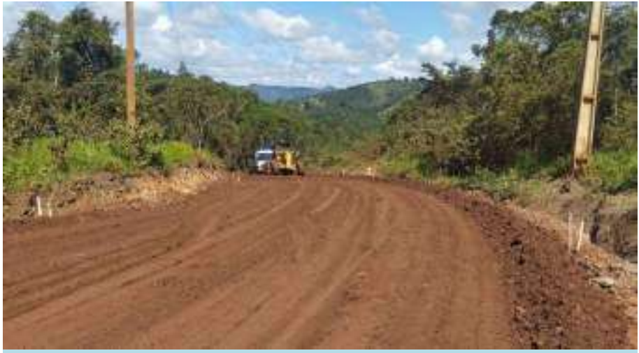
EXECUÇÃO DE BASE E210-236
