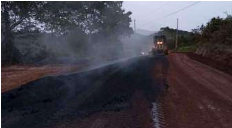
EXECUÇÃO DE SALGAMENTO E221 A E239
