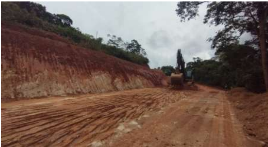
EXECUÇÃO DE CORTE E160 A E190
