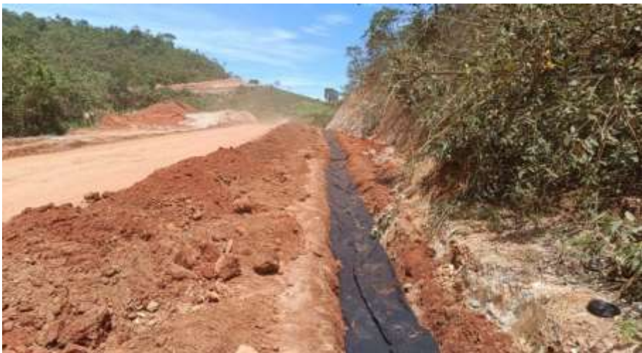
EXECUÇÃO DRP E252+2,78-259+14,13 BD
