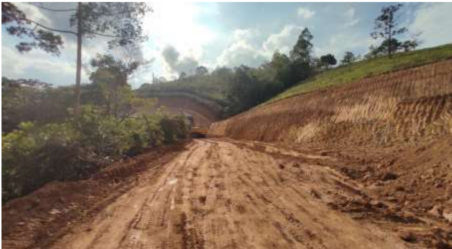
EXECUÇÃO DE CORTE E160 A E190
