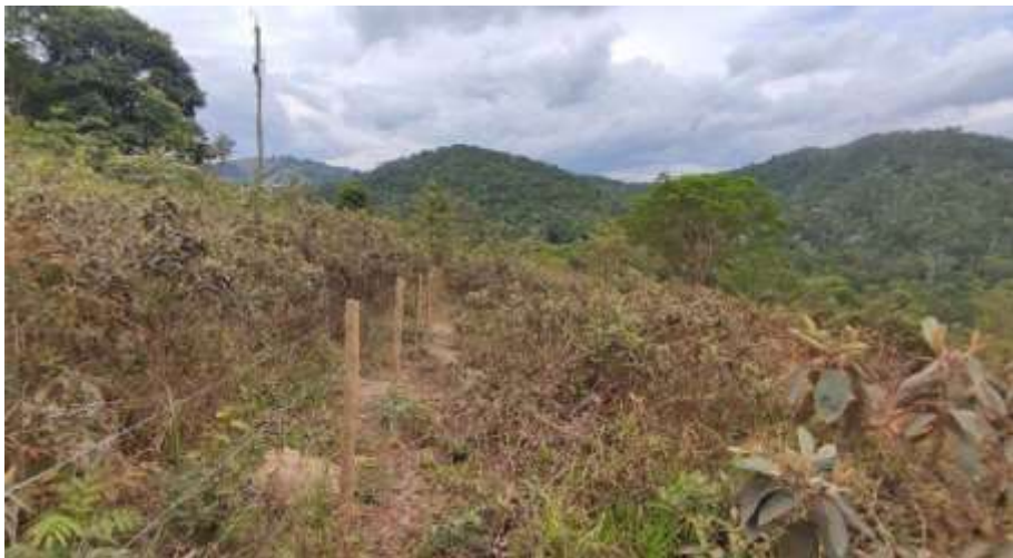
EXECUÇÃO DO CERCAMENTO E209-E225 BD
