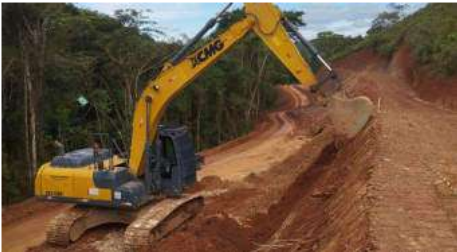
EXECUÇÃO DE CORTE E160 A 190
