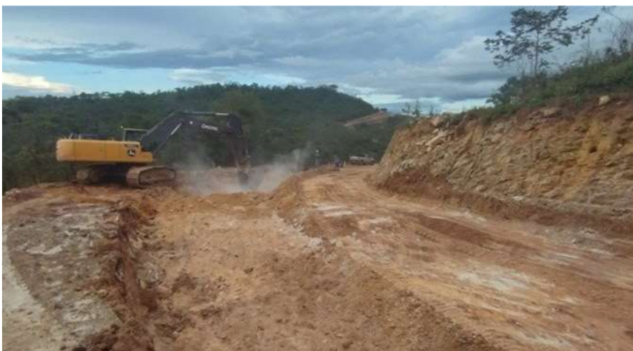
EXECUÇÃO DE CORTE 3º CATEGORIA E240-E246
