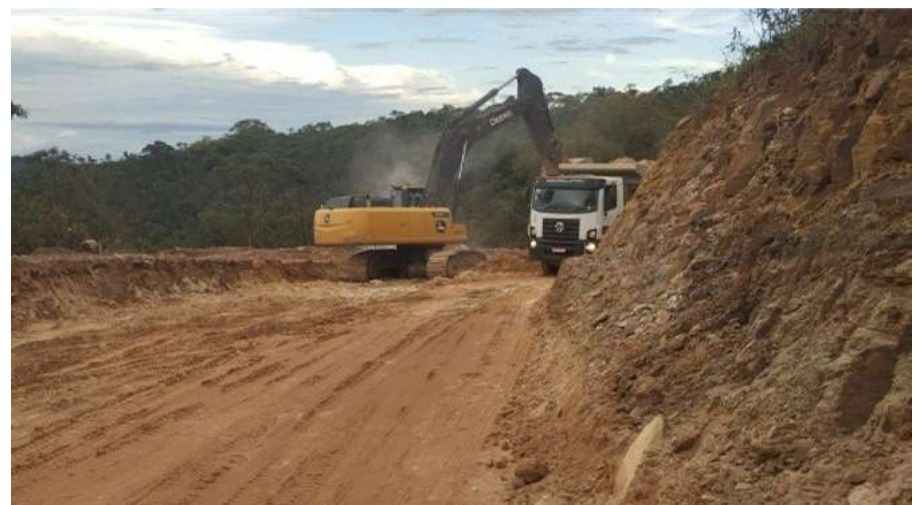
EXECUÇÃO DE CORTE 3º CATEGORIA E240-E246
