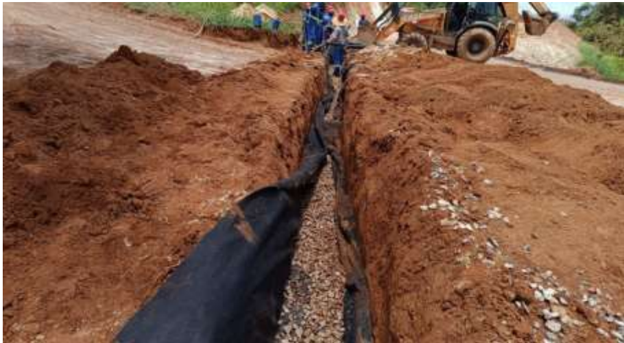
EXECUÇÃO DRP E252+2,78-259+14,13 BD
