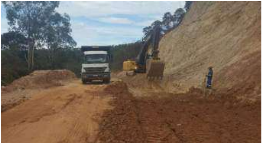
EXECUÇÃO DE CORTE 3º CATEGORIA E240-E246
