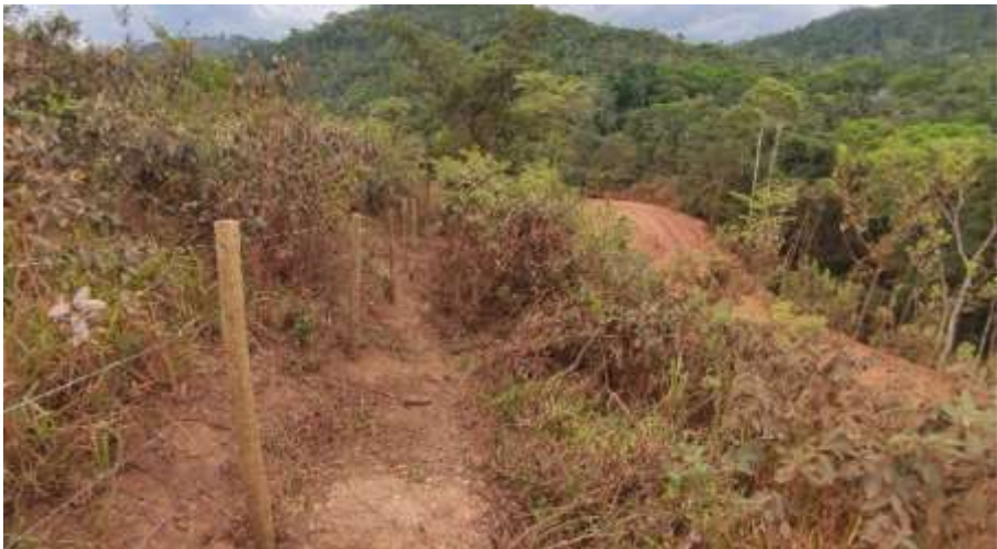
EXECUÇÃO DO CERCAMENTO E208+11,50-E225 BD
