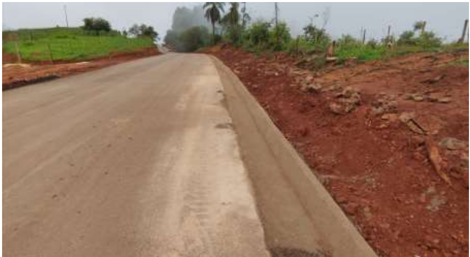
EXECUÇÃO DE SSCC60/15 E320+18,4-E325+10,3 BE
