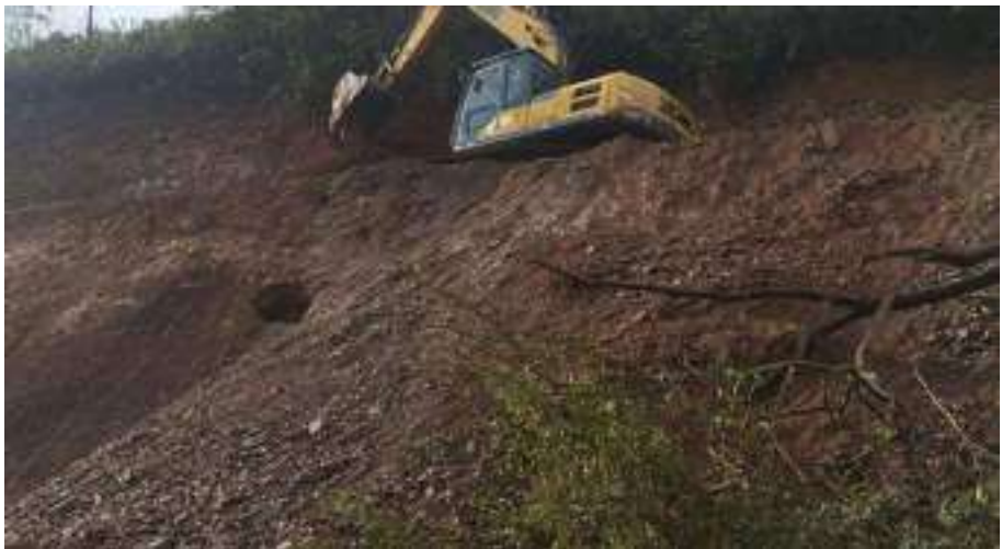
EXECUÇÃO DE CORTE E160 A 190
