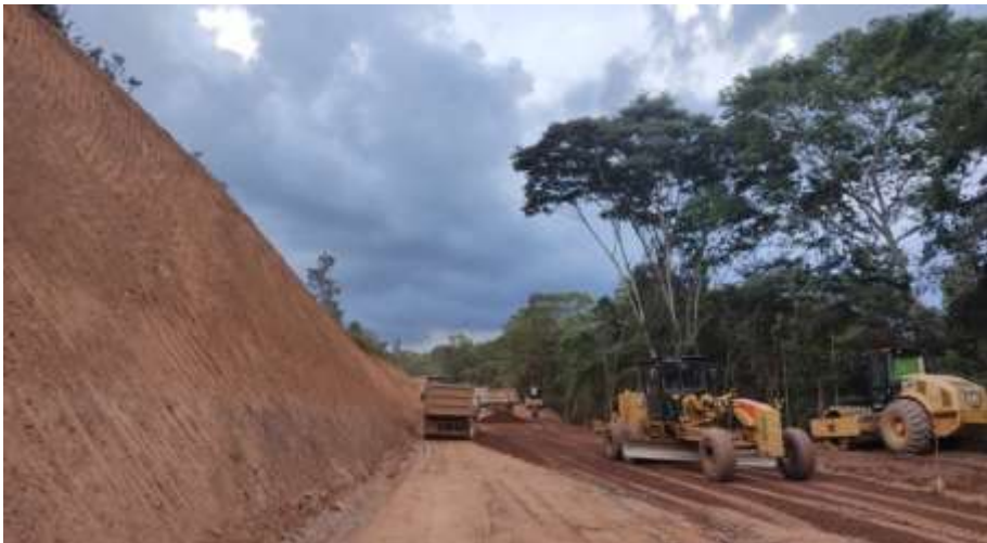
EXECUÇÃO DE ATERRO E170 A E180
