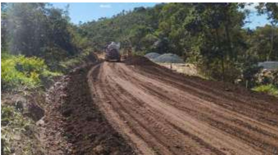
EXECUÇÃO DE BASE E210-236
