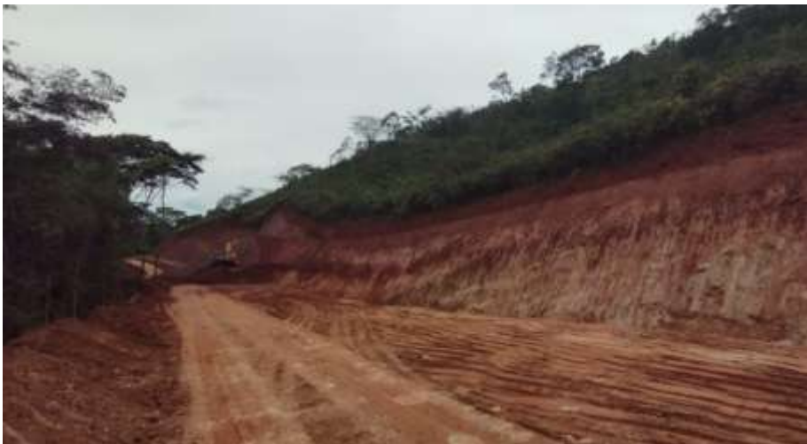
EXECUÇÃO DE CORTE E160 A E190
