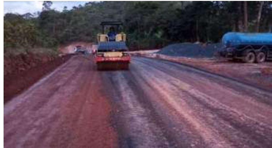
EXECUÇÃO DE SALGAMENTO E221 A E239
