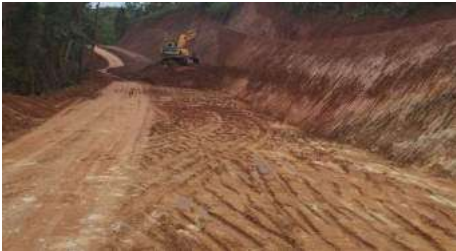
EXECUÇÃO DE CORTE E160 A E190
