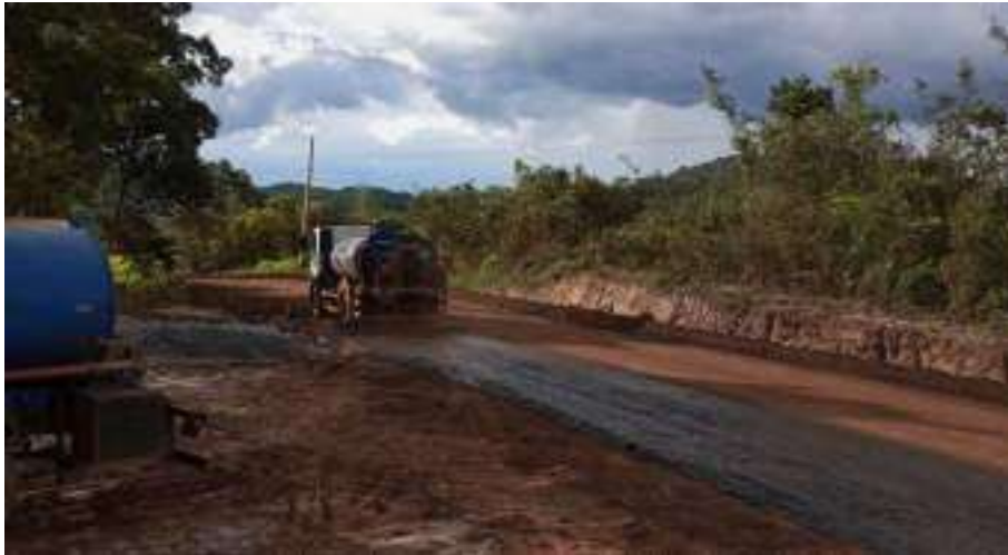
EXECUÇÃO DE IMPRIMAÇÃO E221 A E239
