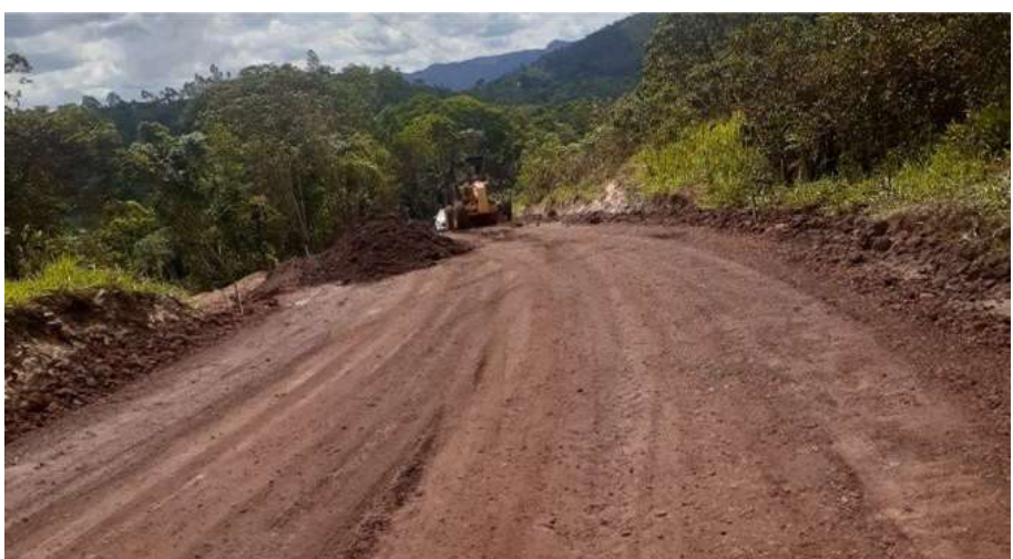
EXECUÇÃO DE BASE E210-236
