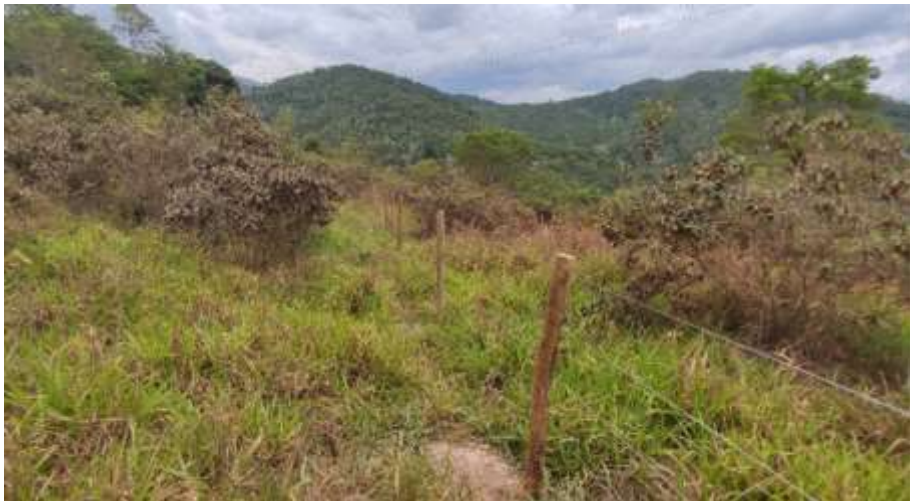
EXECUÇÃO DO CERCAMENTO E208+11,50-E225 BD
