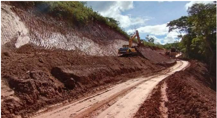
EXECUÇÃO DE CORTE E160 A 190
