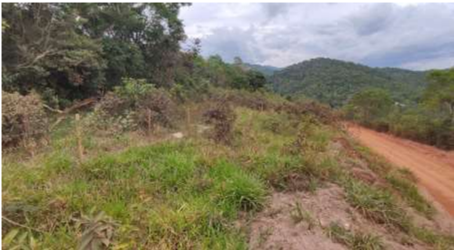
EXECUÇÃO DO CERCAMENTO E208+11,50-E225 BD
