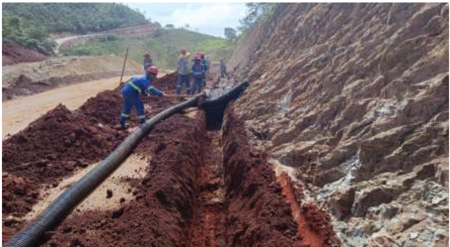
EXECUÇÃO DRP E252+2,78-259+14,13 BD
