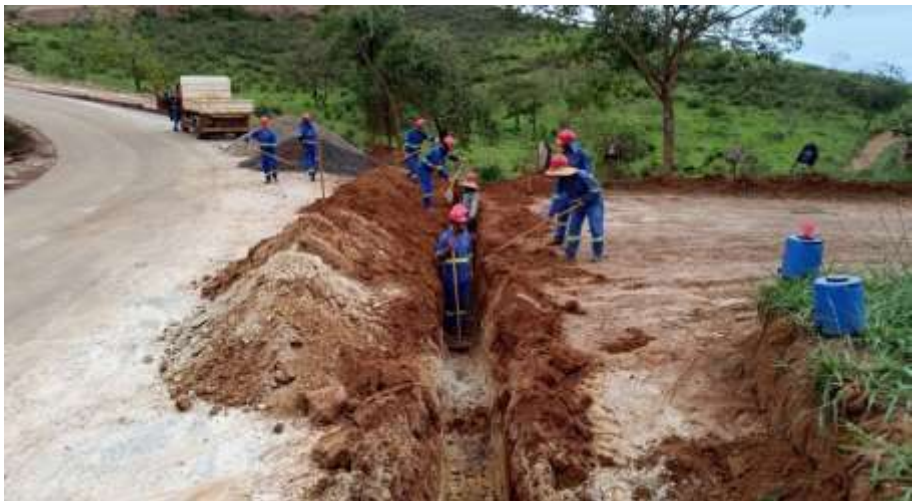
EXECUÇÃO DRP E252+2,78-259+14,13 BD
