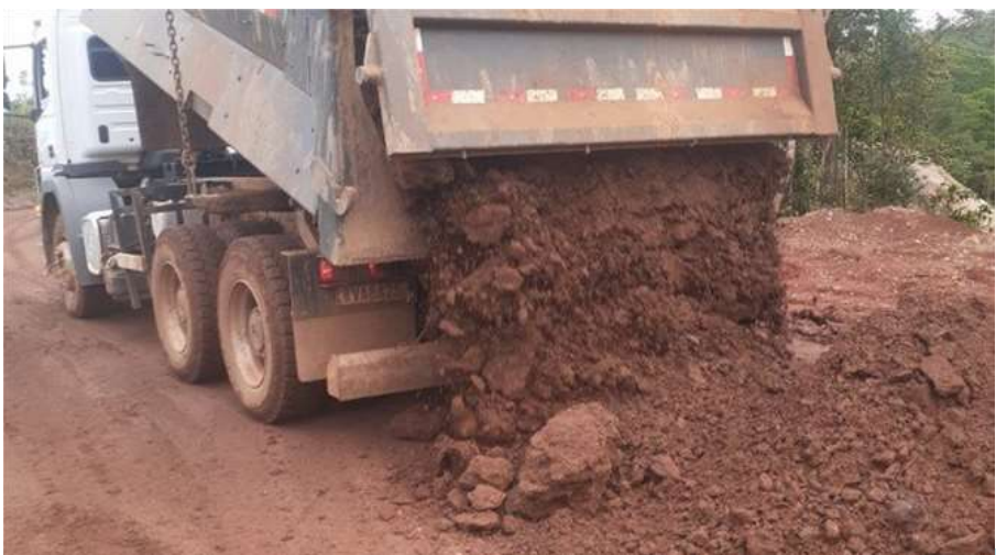
EXECUÇÃO DE BASE E210-236
