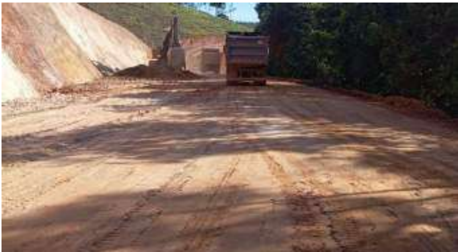
EXECUÇÃO DE CORTE E160 A E190
