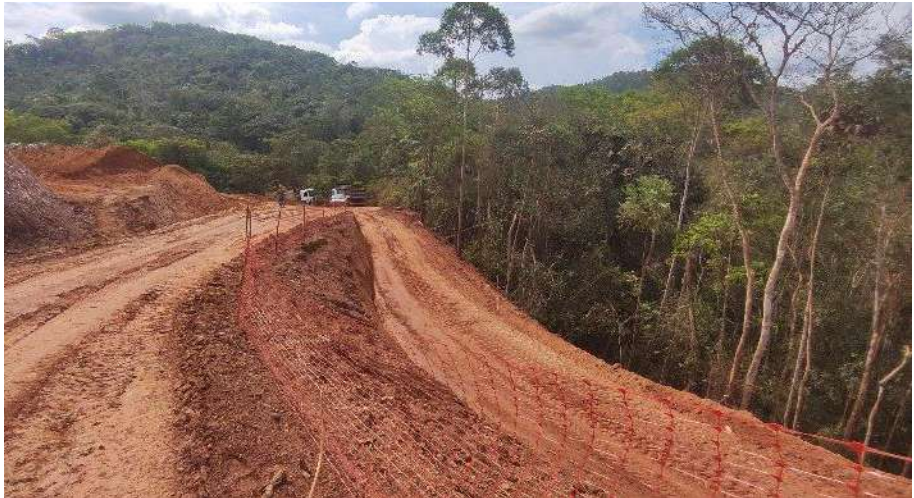
ATERRO COMPACTADO E209 A E231
