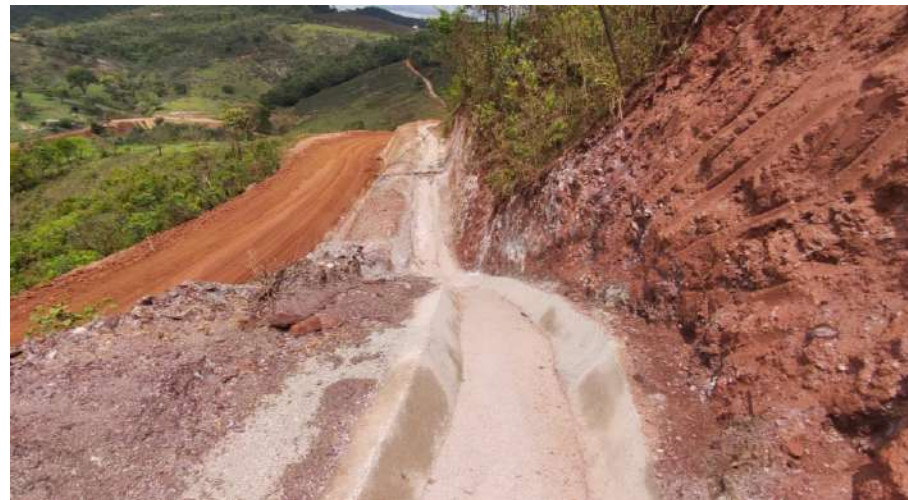
EXECUÇÃO DE VPC 04 E276+6,83 A E277+4,31 BE
