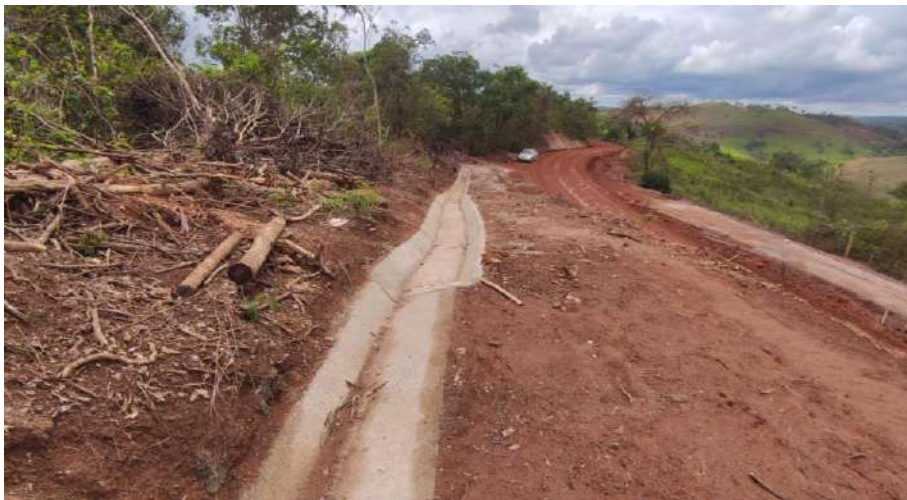
EXECUÇÃO DE SCC 60/10 E277+4,51 A E279+10,06 BE
