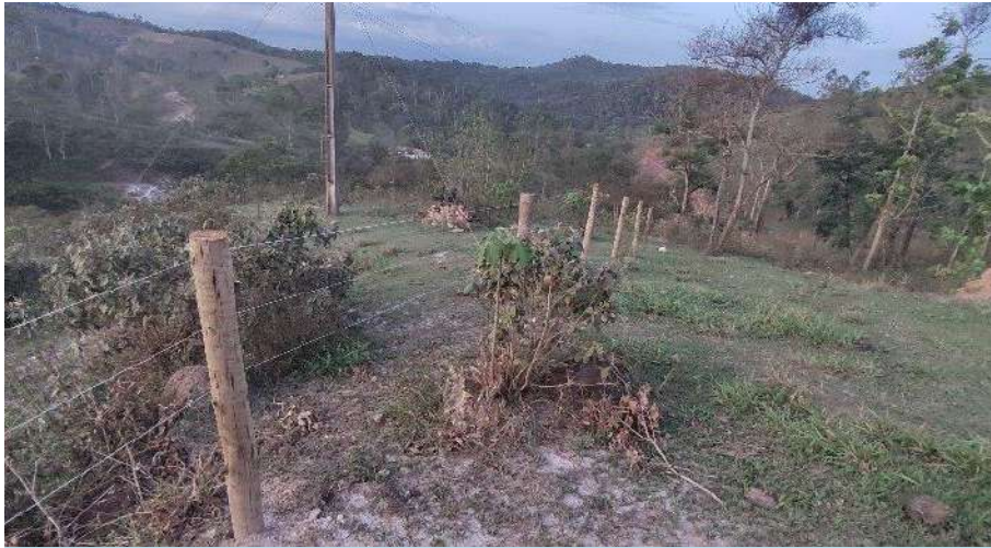
EXECUÇÃO DE CERCA E222+0,82 A E230+3,78 - BD
