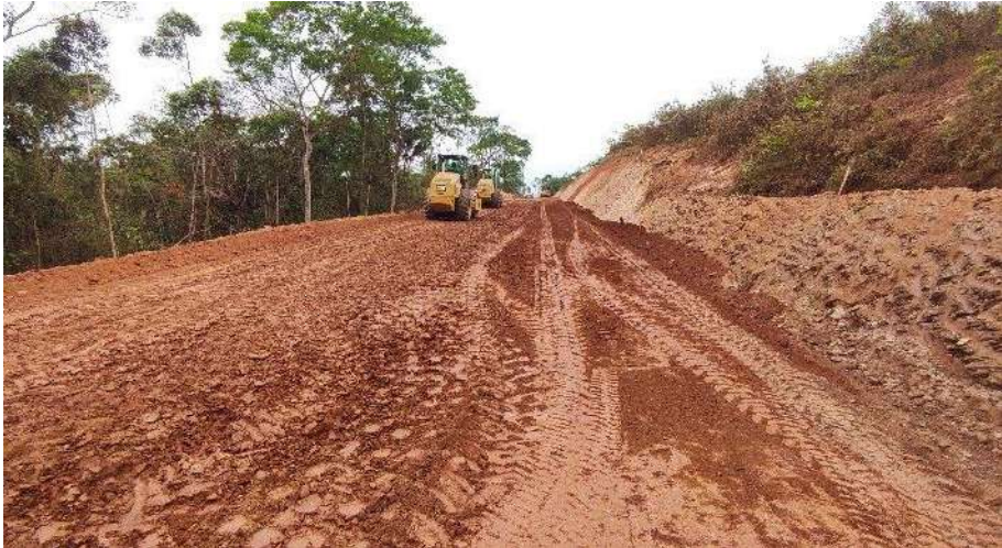
ATERRO COMPACTADO E209 A E231
