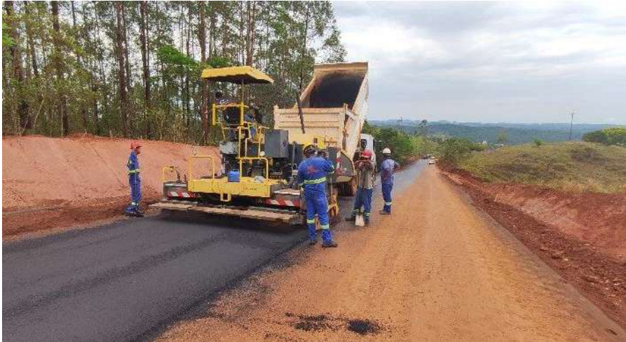
EXECUÇÃO DE PINTURA DE LIGAÇÃO E CAPA E309 A E362
