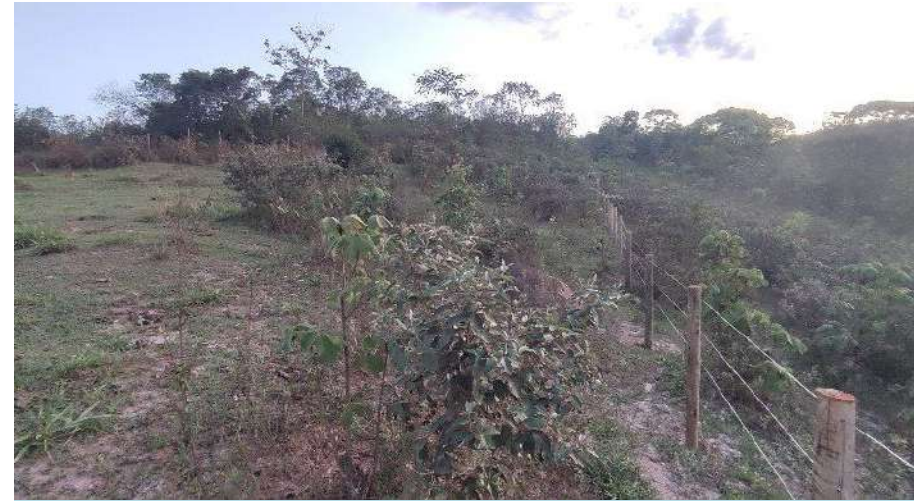
EXECUÇÃO DE CERCA E222+8,04 A E230+0,43 - BE
