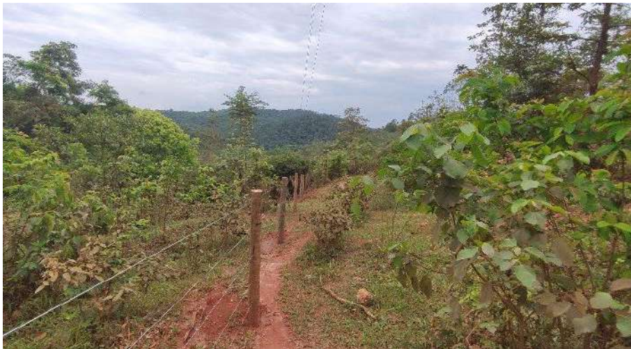
EXECUÇÃO DE CERCA E222+0,82 A E230+3,78 - BD
