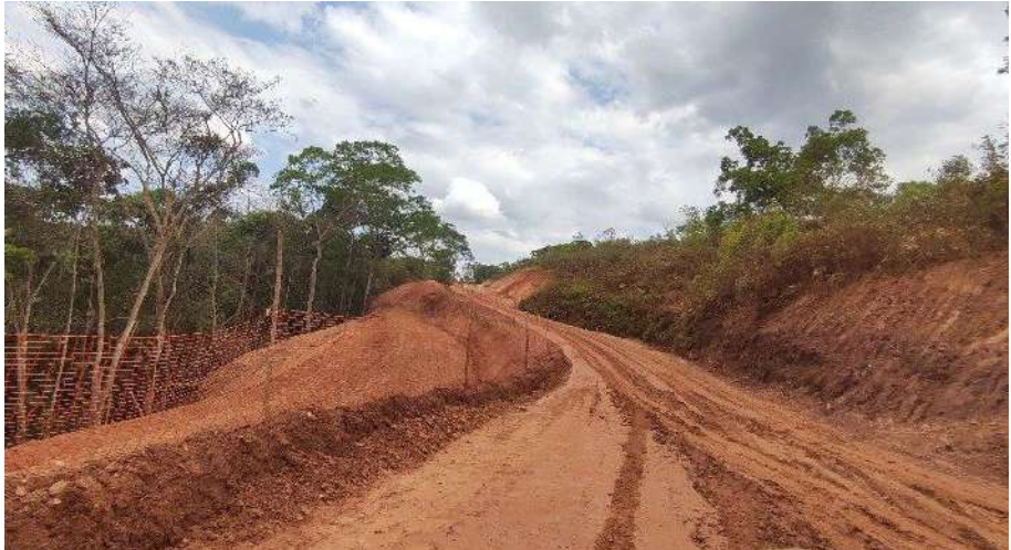
ATERRO COMPACTADO E209 A E231
