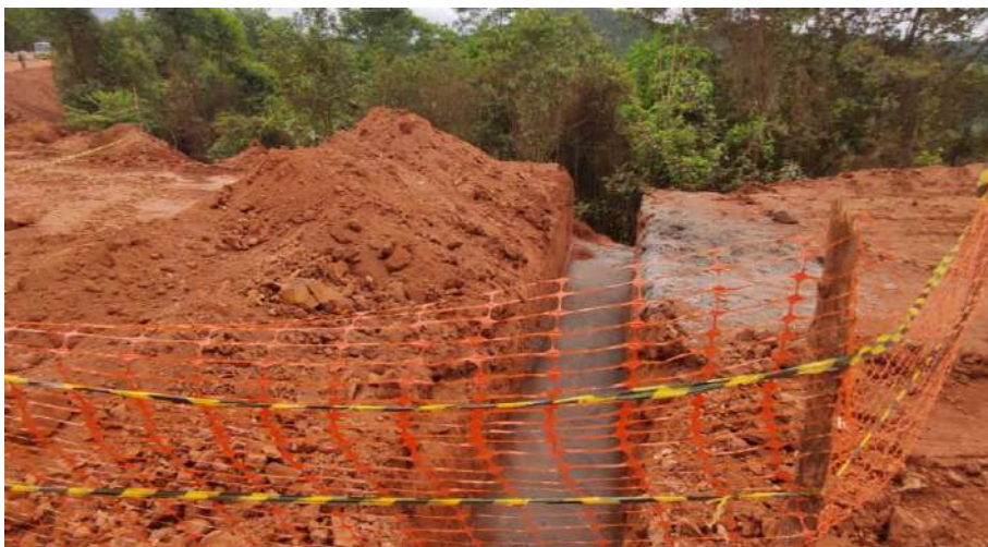
EXECUÇÃO DE BUEIRO DN 600 – E239+10
