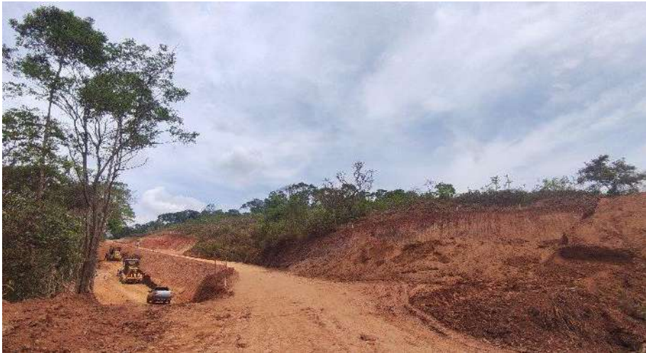
ATERRO COMPACTADO E209 A E231
