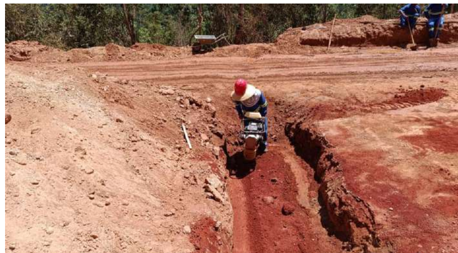
EXECUÇÃO DE BUEIRO DN 600 – E252
