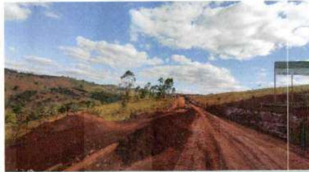
ATERRO COMPACTADO E355 A E363
