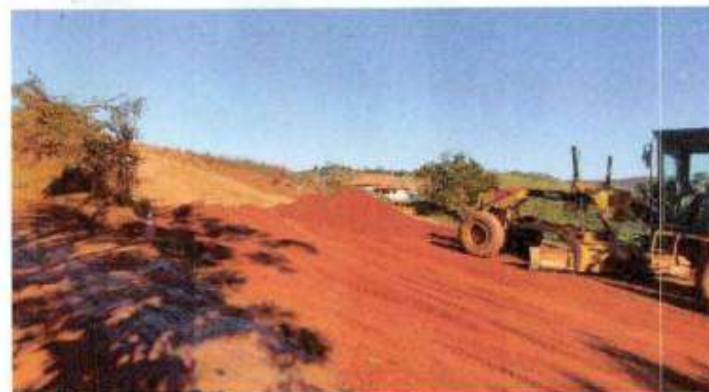
ATERRO COMPACTADO E341 A E351
