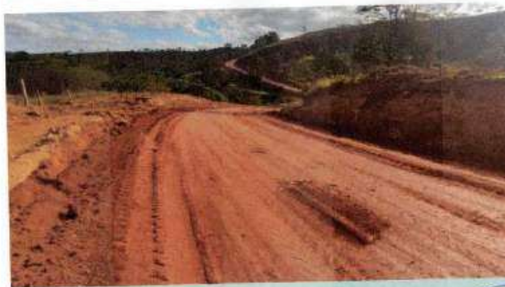
Tamboril ATERRO COMPACTADO E351 A E358
