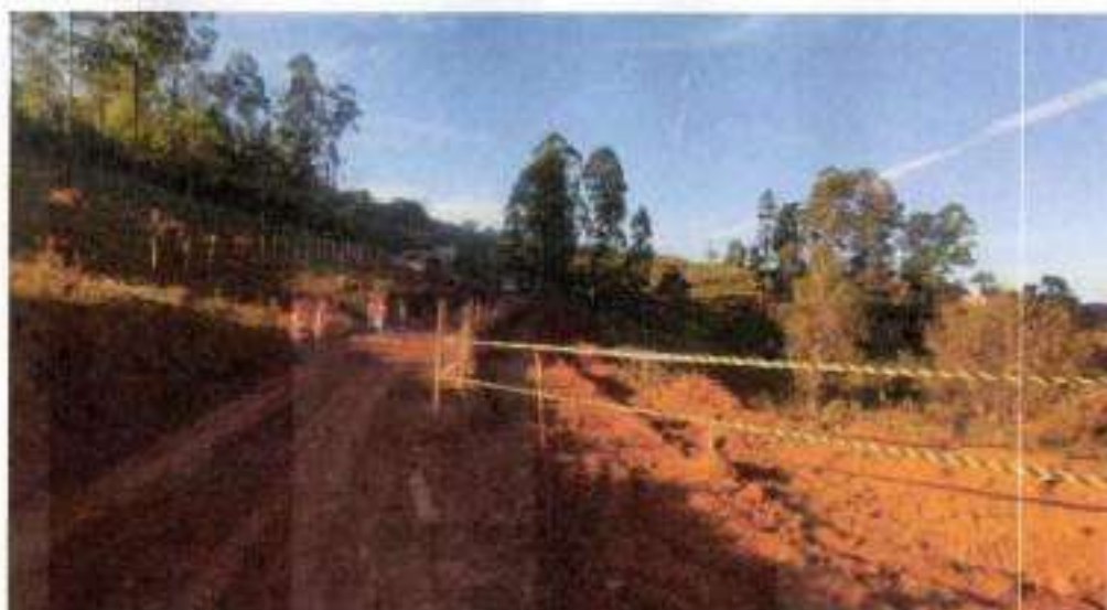
REMOÇÃO DA CAMADA VEGETAL E355 A E363
