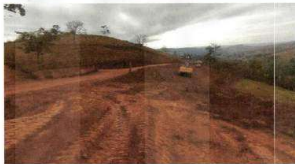
REMOÇÃO DA CAMADA VEGETAL E331 A E335
