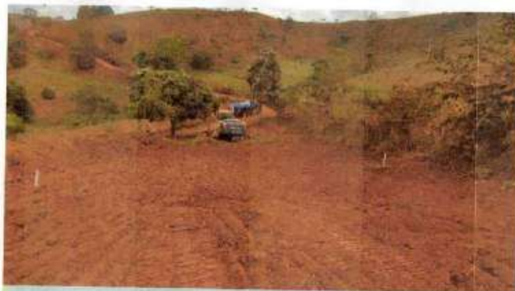
REMOÇÃO DA CAMADA VEGETAL E347 A E355
