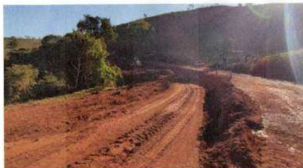
ATERRO COMPACTADO E341 A E351
