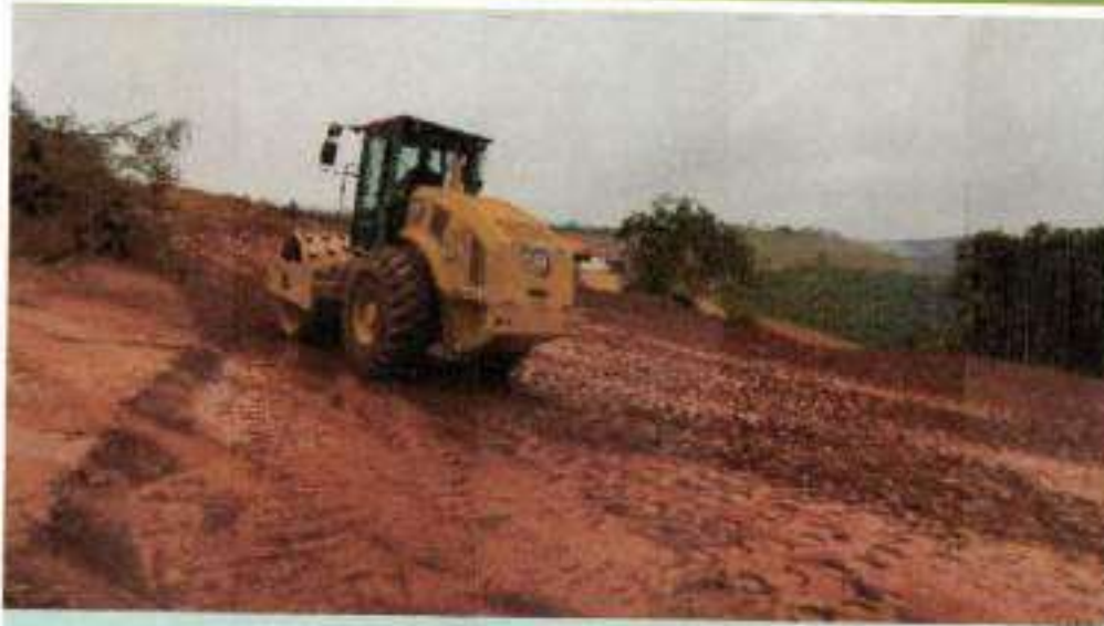
ATERRO COMPACTADO E341 A E351
