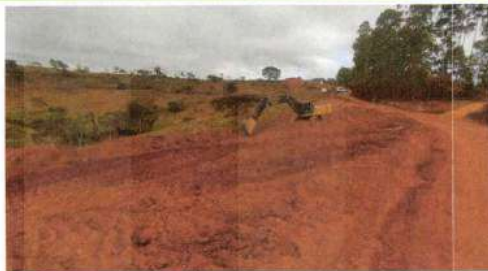
REMOÇÃO DA CAMADA VEGETAL E331 A E335
