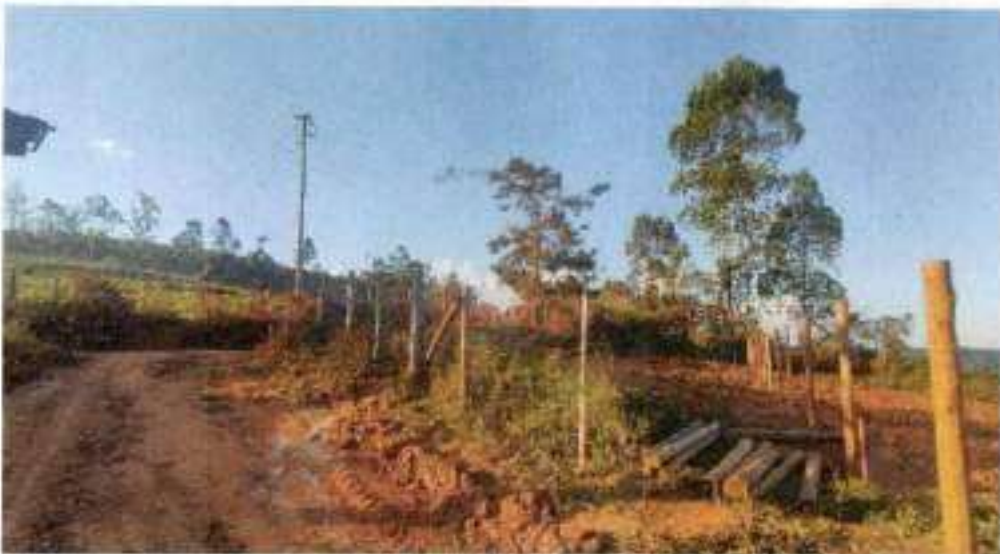
EXECUÇÃO DE CERCA E353 A E361 - BD
