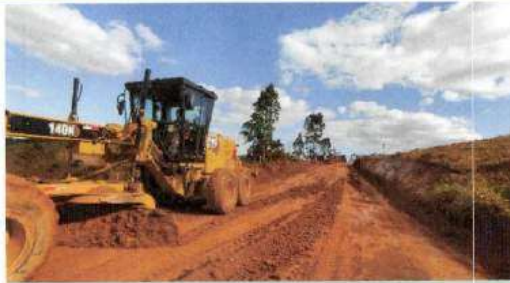
ATERRO COMPACTADO E355 A E363
