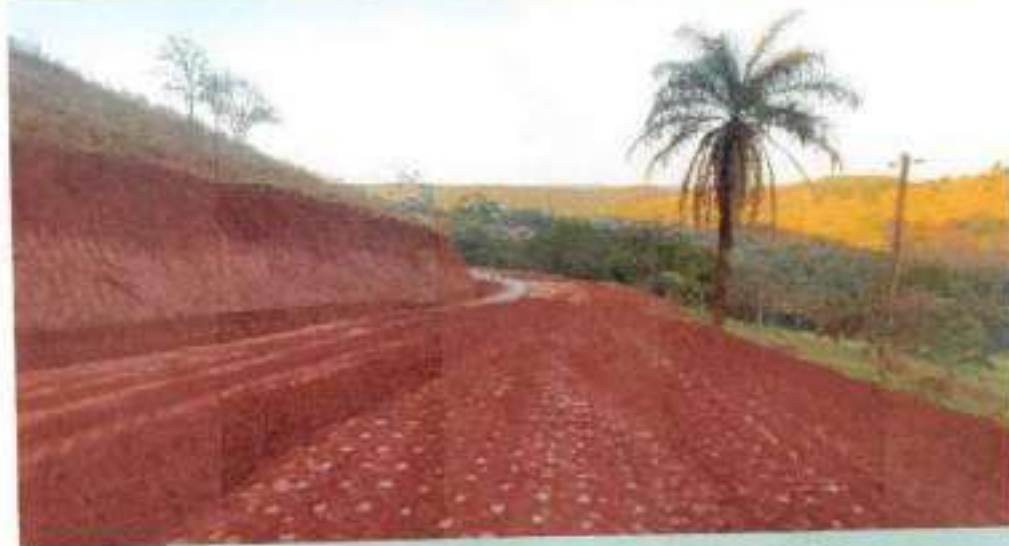
Tamboril ATERRO COMPACTADO E327 A E333
