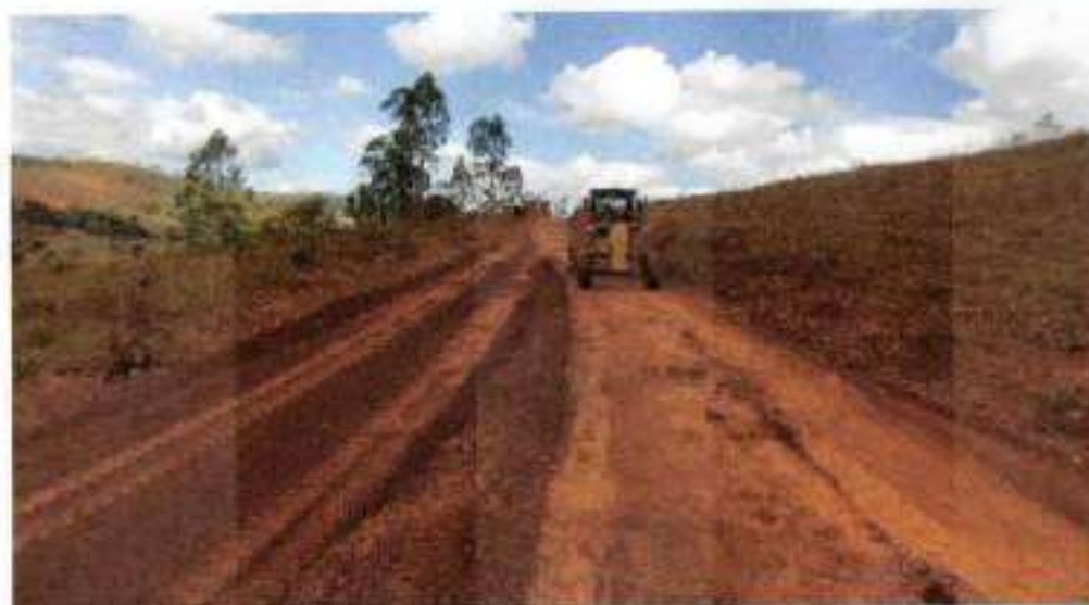
ATERRO COMPACTADO E355 A E363
