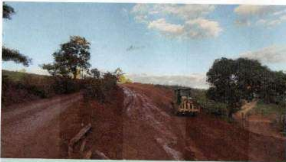
ATERRO COMPACTADO E341 A E351
