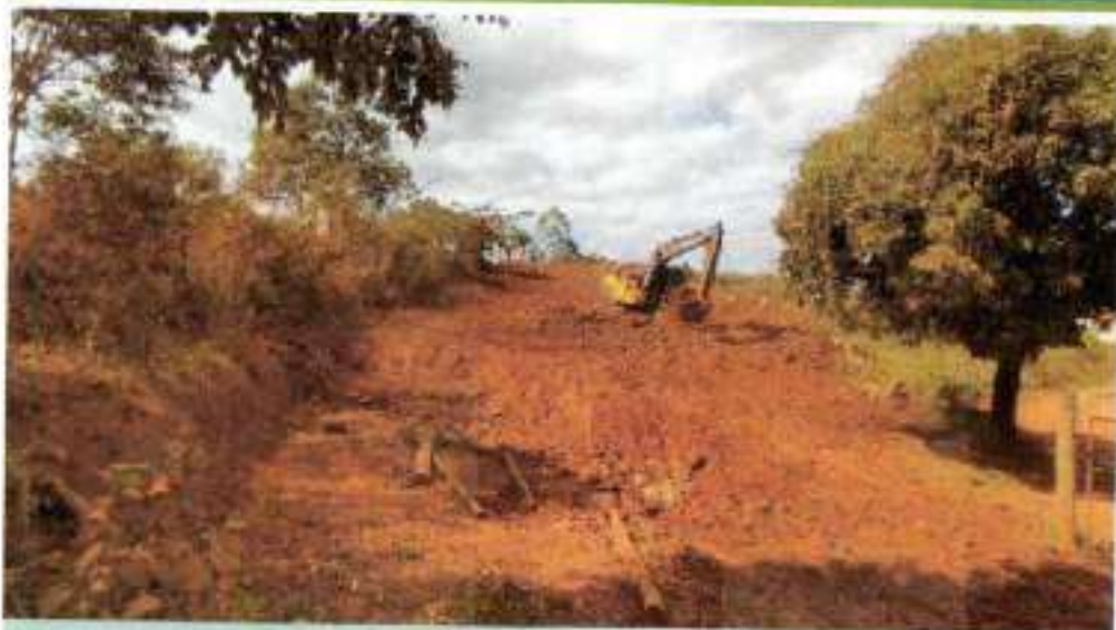
REMOÇÃO DA CAMADA VEGETAL E347 A E355
