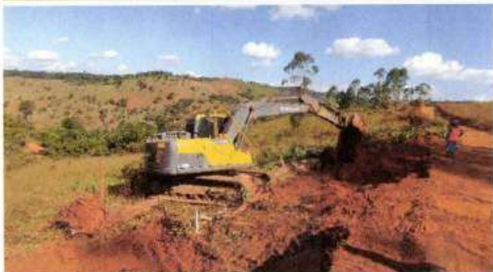
REMOÇÃO DA CAMADA VEGETAL E355 A E363
