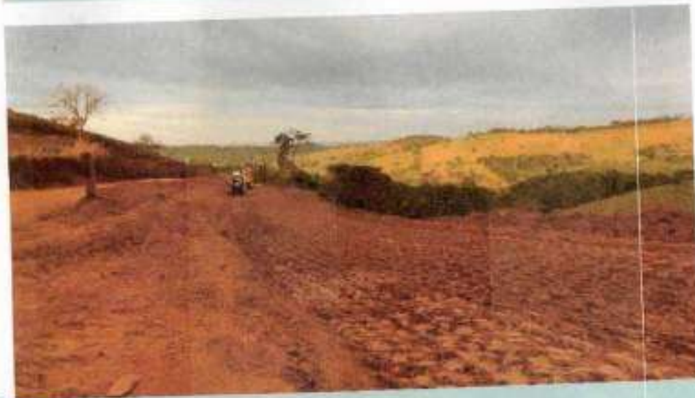
ATERRO COMPACTADO E327 A E333
