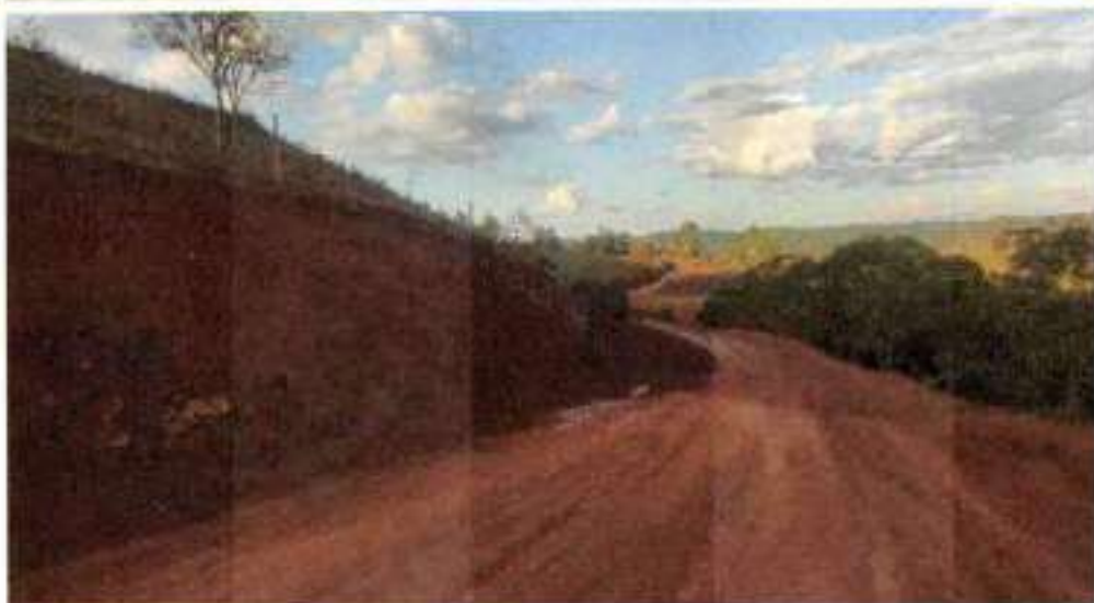
REMOÇÃO DA CAMADA VEGETAL E335 A E340
