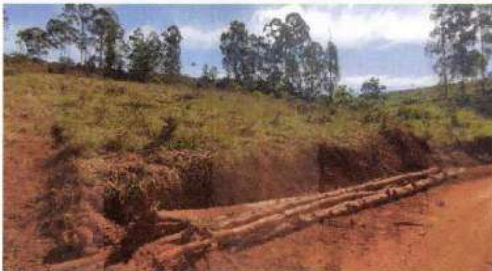
REMOÇÃO DA CAMADA VEGETAL E355 A E363
