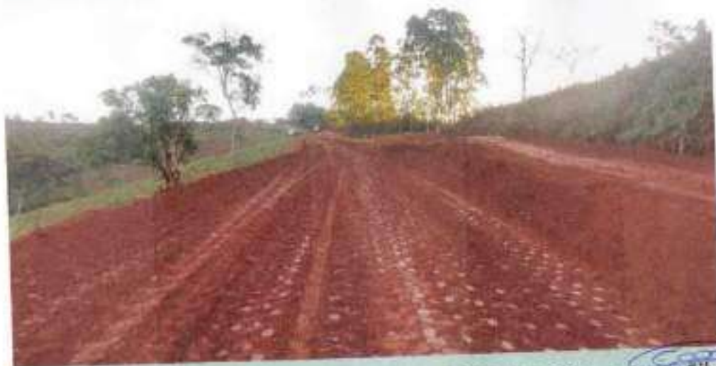
ATERRO COMPACTADO E327 A E333
