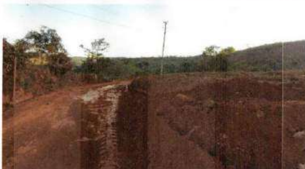
REMOÇÃO DA CAMADA VEGETAL E352 A E355
