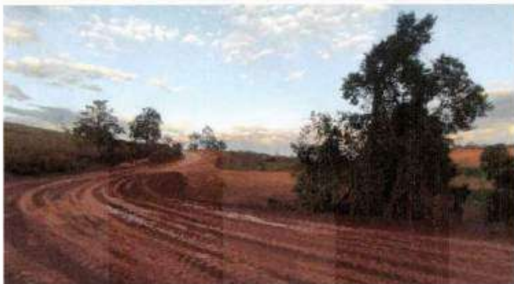
Tamanho: ATERRO COMPACTADO E341 A E351
