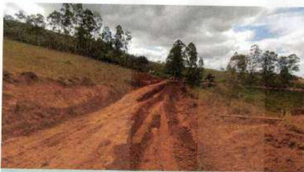
REMOÇÃO DA CAMADA VEGETAL E355 A E363
