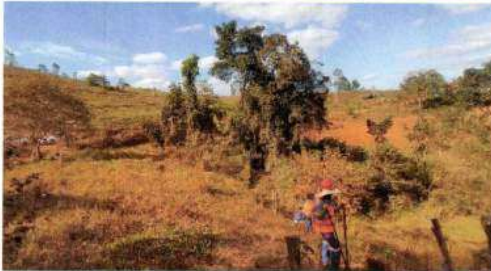
EXECUÇÃO DE CERCA E353 A E361- BD
