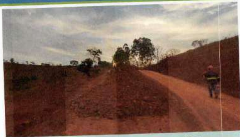
ATERRO COMPACTADO E327 A E333
