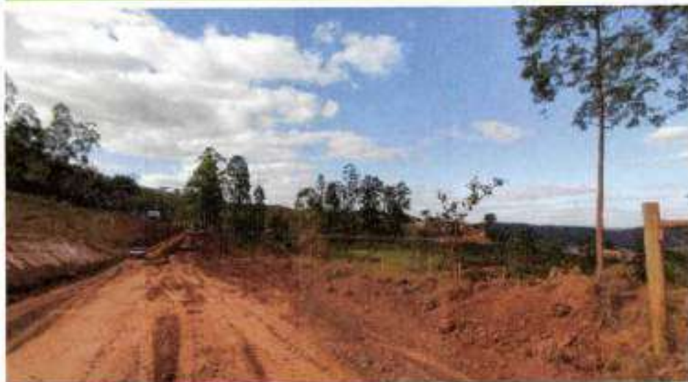
ATERRO COMPACTADO E355 A E363
