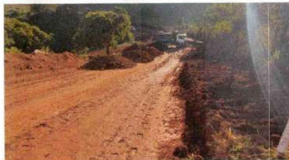
ATERRO COMPACTADO E341 A E351
