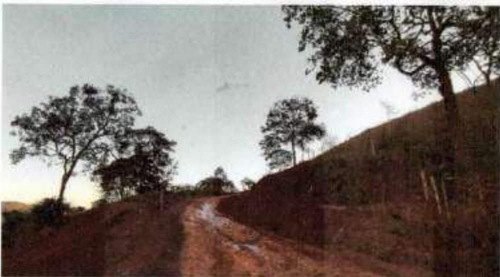
REMOÇÃO DA CAMADA VEGETAL E335 A E340
