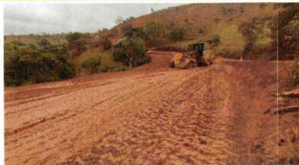
Tamanho ATERRO COMPACTADO E341 A E351
