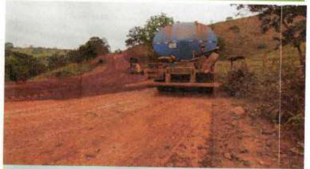
ATERRO COMPACTADO E341 A E351
