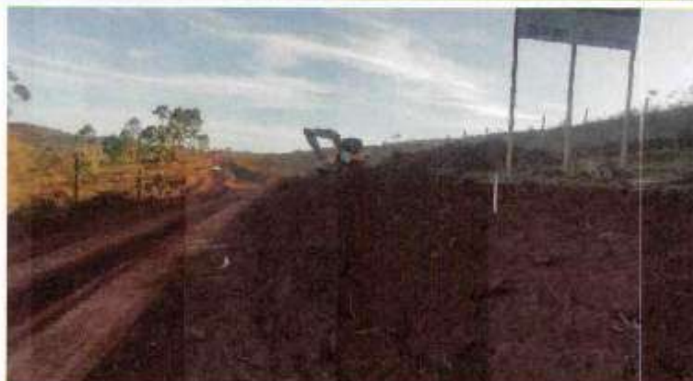
REMOÇÃO DA CAMADA VEGETAL E355 A E363
