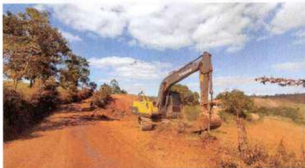
REMOÇÃO DA CAMADA VEGETAL E347 A E355
