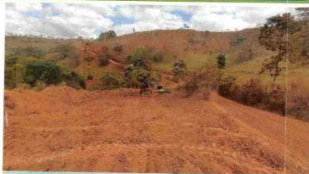
REMOÇÃO DA CAMADA VEGETAL E347 A E355
