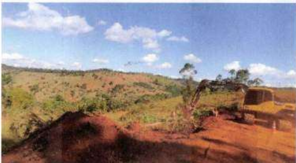
REMOÇÃO DA CAMADA VEGETAL E355 A E363
