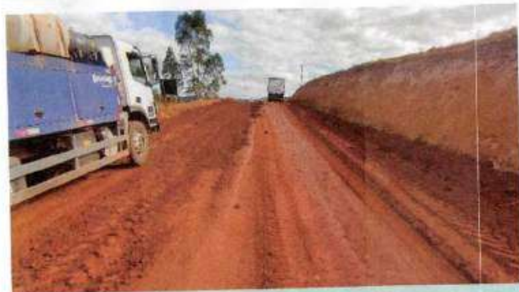
ATERRO COMPACTADO E351 A E358
