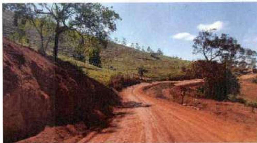
Tamanho ATERRO COMPACTADO E341 A E351
