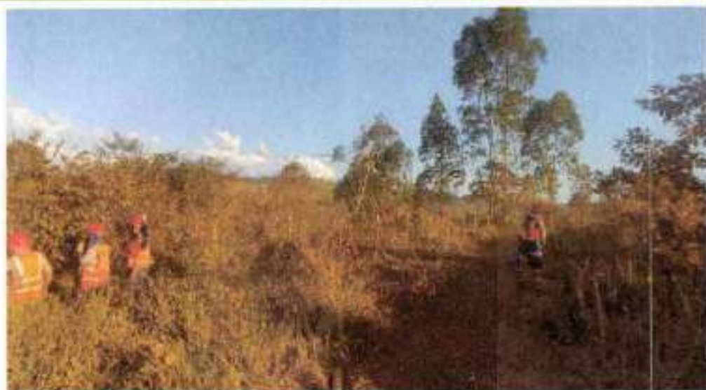
REMOÇÃO DA CAMADA VEGETAL E355 A E363
