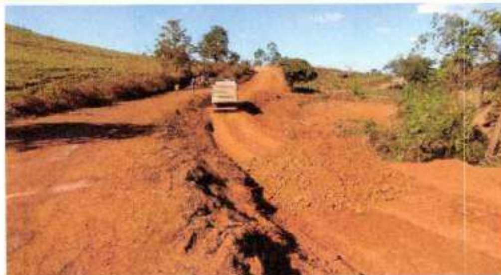
ATERRO COMPACTADO E341 A E351
