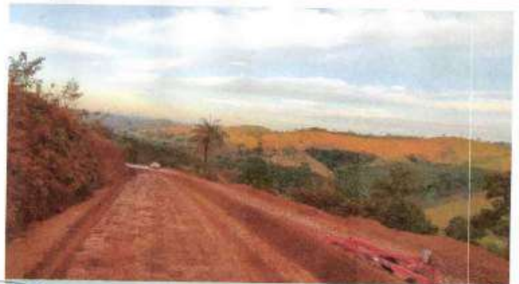
ATERRO COMPACTADO E333 A E335
