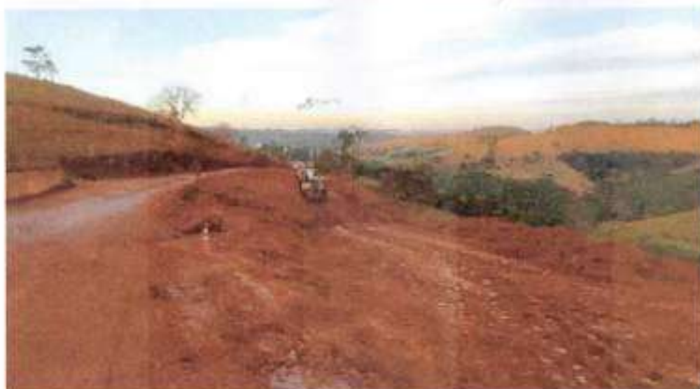
Tamanho: ATERRO COMPACTADO E327 A E333
