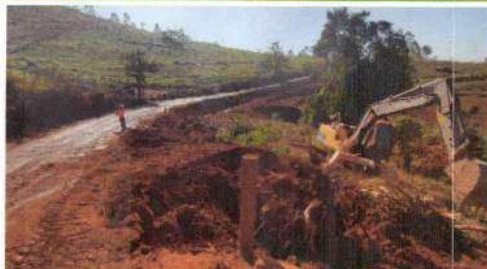
REMOÇÃO DA CAMADA VEGETAL E340 A E347
