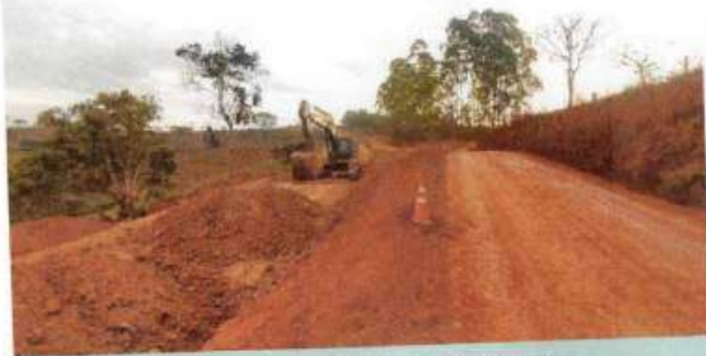
ATERRO COMPACTADO E327 A E333
