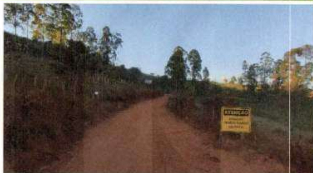
INSTALAÇÃO DE SINALIZAÇÃO VERTICAL
