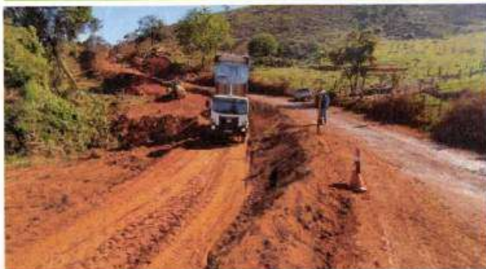
ATERRO COMPACTADO E341 A E351
