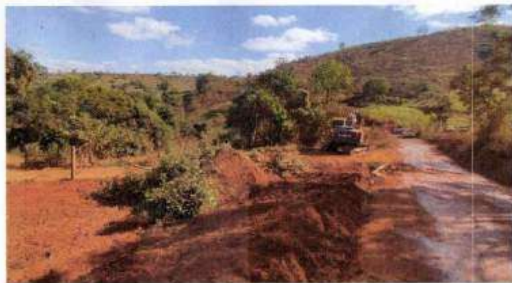
REMOÇÃO DA CAMADA VEGETAL E347 A E355
