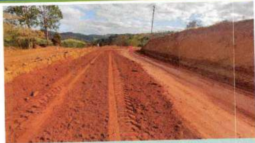
Engenheiro ATERRO COMPACTADO E351 A E358
