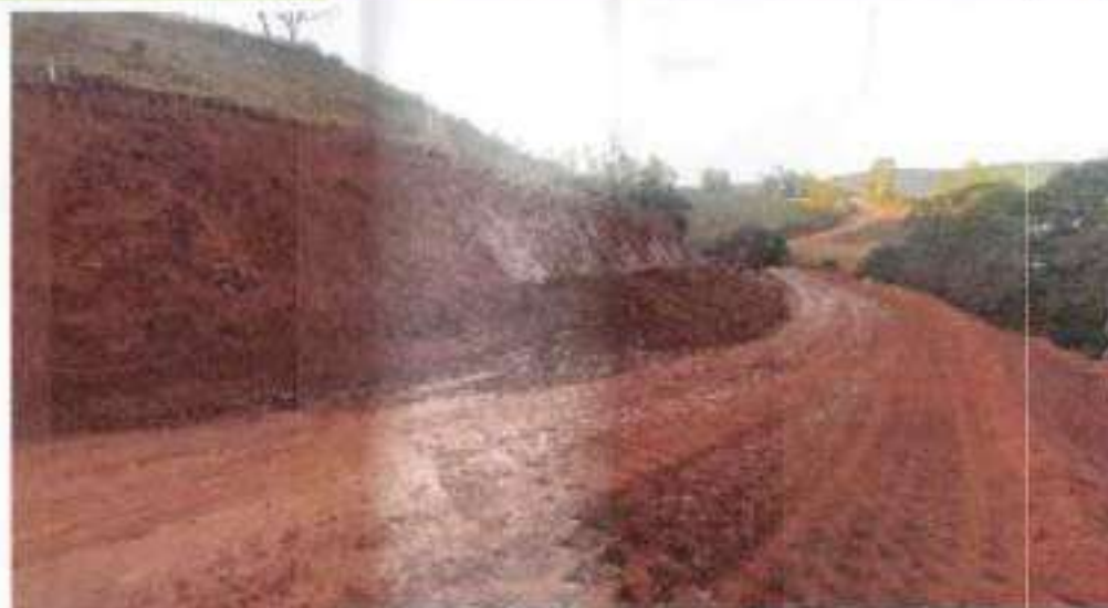
Tamanho: ATERRO COMPACTADO E333 A E335
