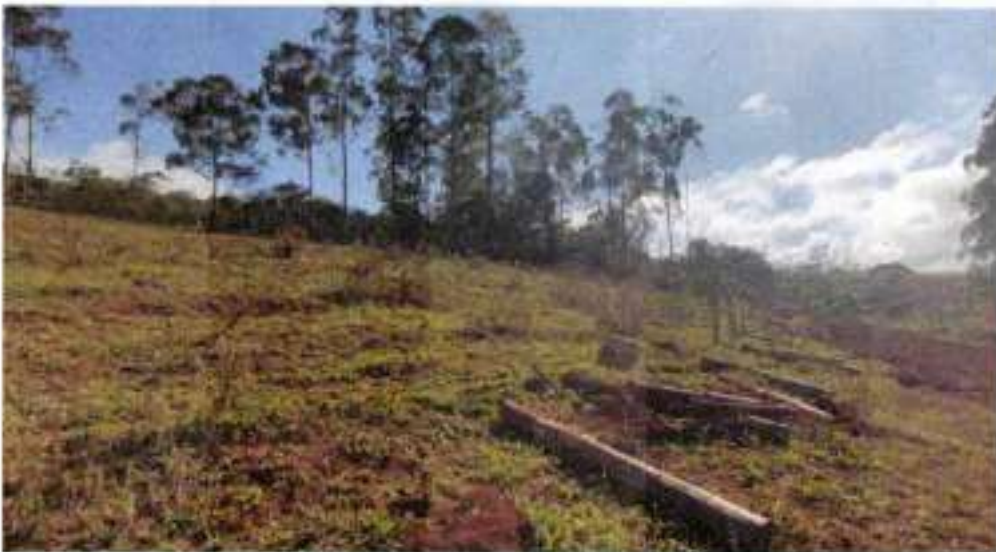
Tamaná EXECUÇÃO DE CERCA E361 A E363 - BE
