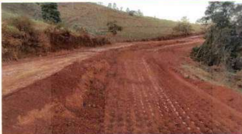
Tamanho ATERRO COMPACTADO E341 A E351
