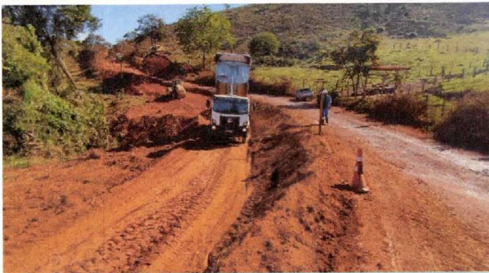
Tamanho ATERRO COMPACTADO E341 A E351
