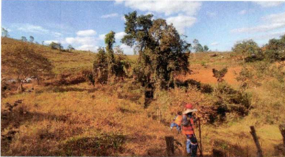
Tamamho EXECUÇÃO DE CERCA E353 A E361- BD
