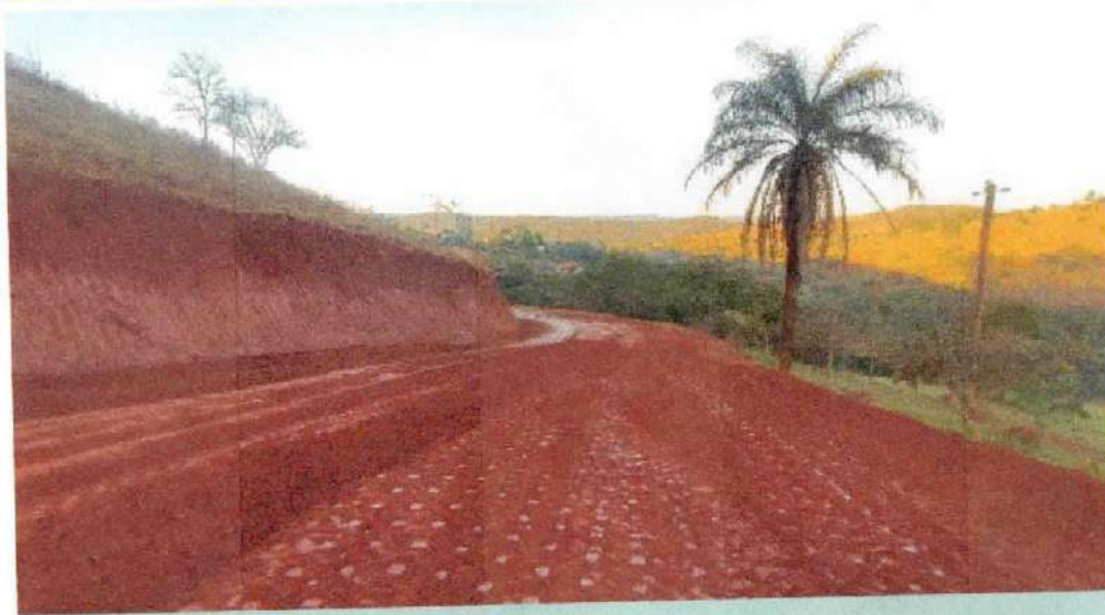
Tamanho ATERRO COMPACTADO E327 A E333
