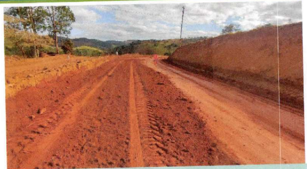
Tamanho ATERRO COMPACTADO E351 A E358
