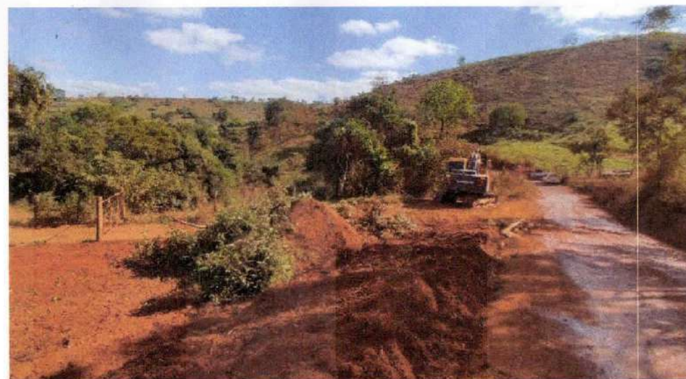
REMOÇÃO DA CAMADA VEGETAL E347 A E355
