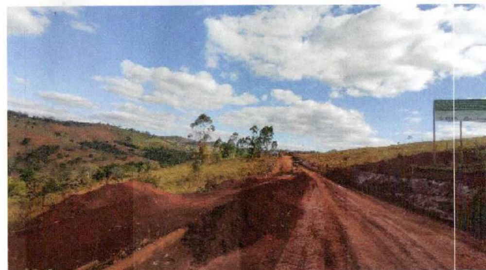
Tamanho ATERRO COMPACTADO E355 A E363
