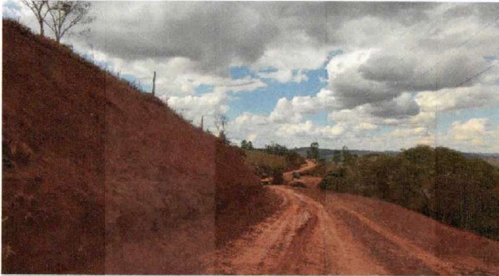
REMOÇÃO DA CAMADA VEGETAL E335 A E340
