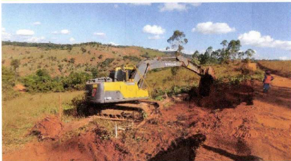
Tam REMOÇÃO DA CAMADA VEGETAL E355 A E363
