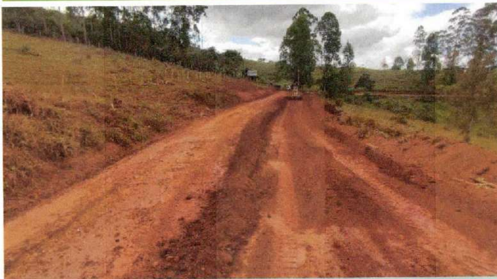
Tamanho ATERRO COMPACTADO E355 A E363
