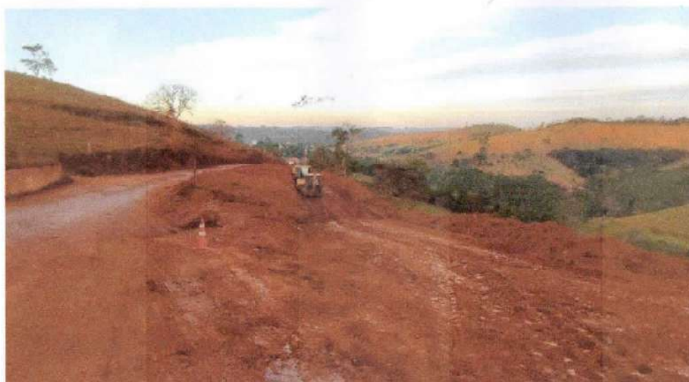
Tamanho ATERRO COMPACTADO E327 A E333
