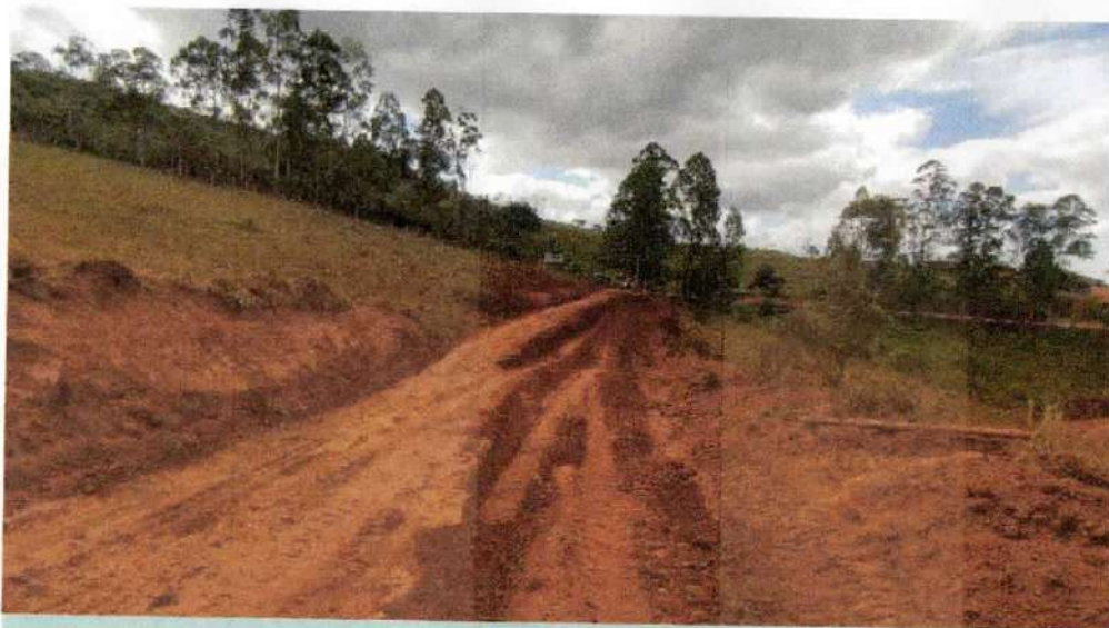
REMOÇÃO DA CAMADA VEGETAL E355 A E363
