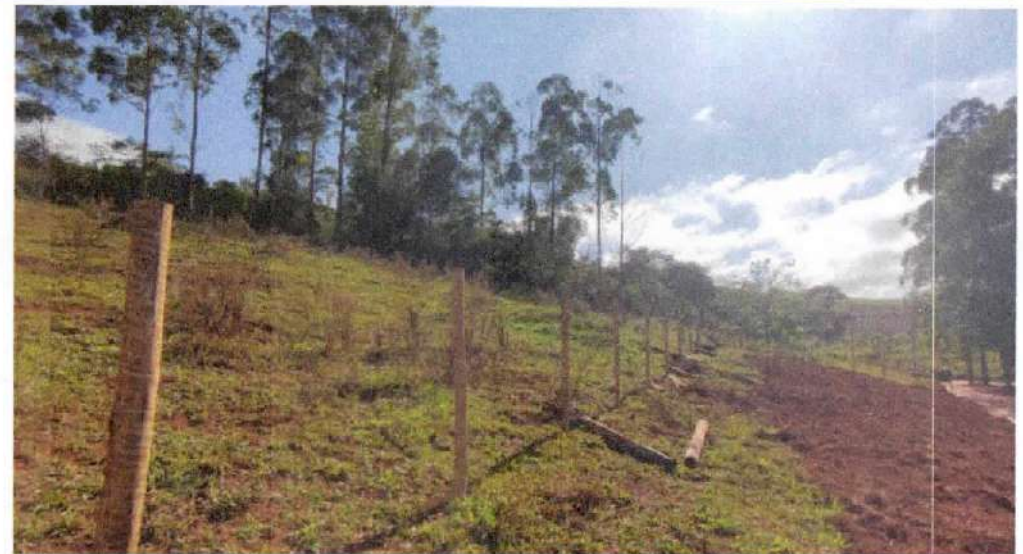
Tamari EXECUÇÃO DE CERCA E361 A E363 - BE
