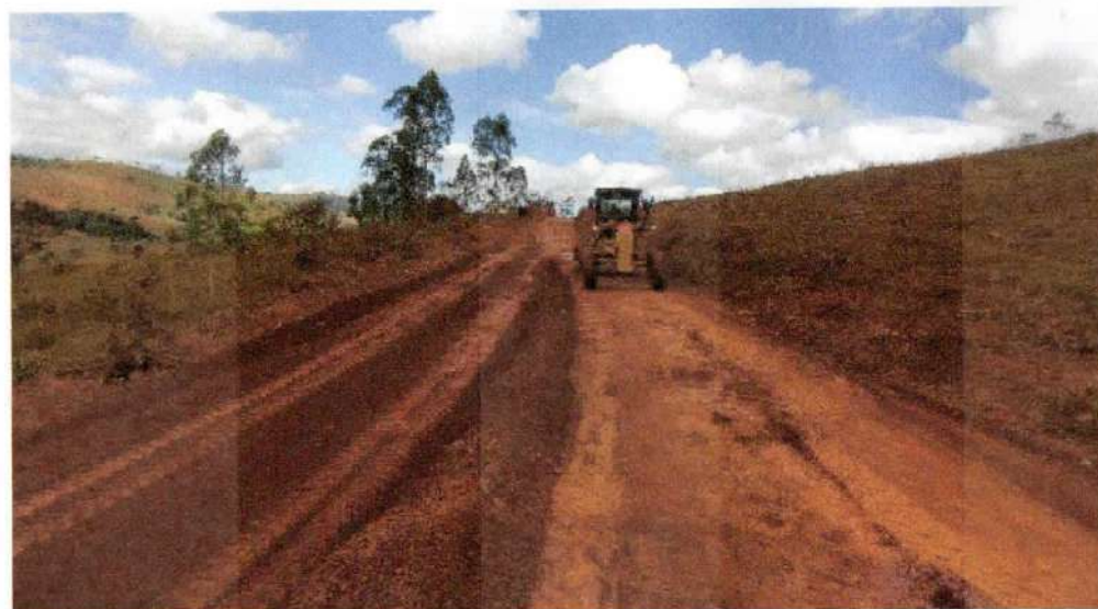
Tamanho ATERRO COMPACTADO E355 A E363
