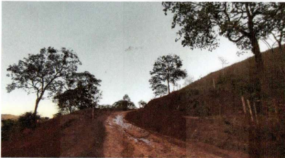
REMOÇÃO DA CAMADA VEGETAL E335 A E340
