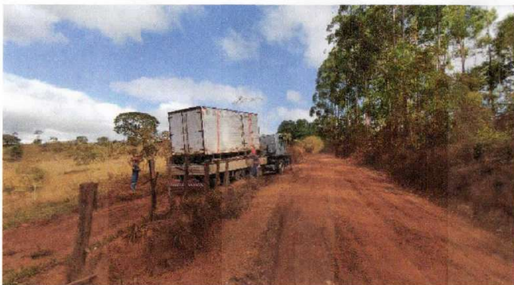
Tamanho: 1,0 INSTALAÇÃO DE CONTEINER 16,5
