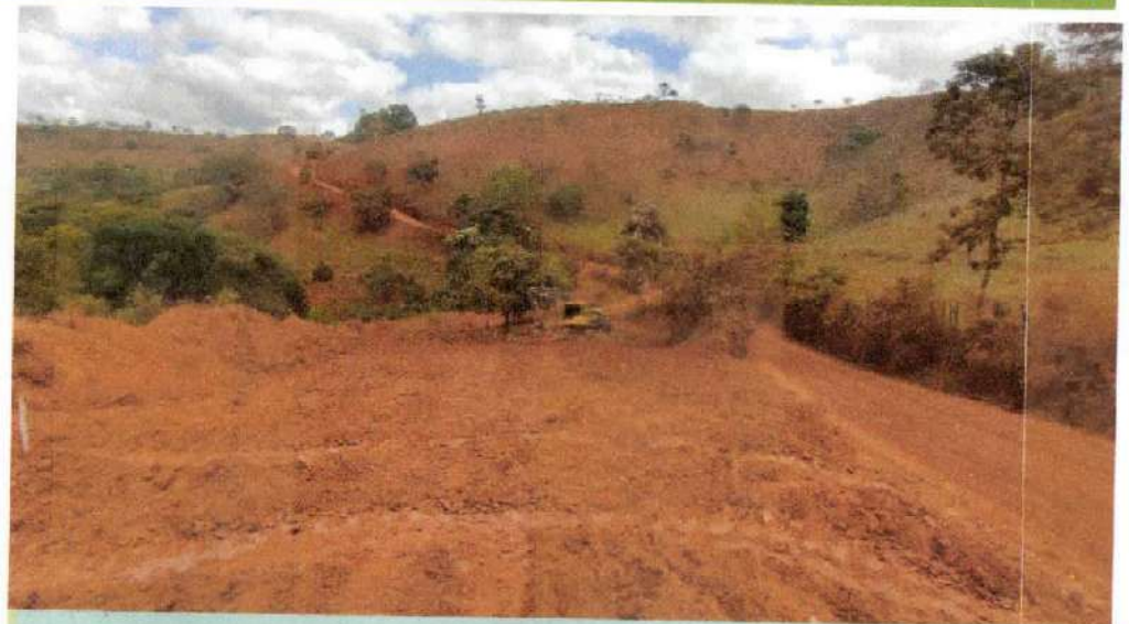
REMOÇÃO DA CAMADA VEGETAL E347 A E355
