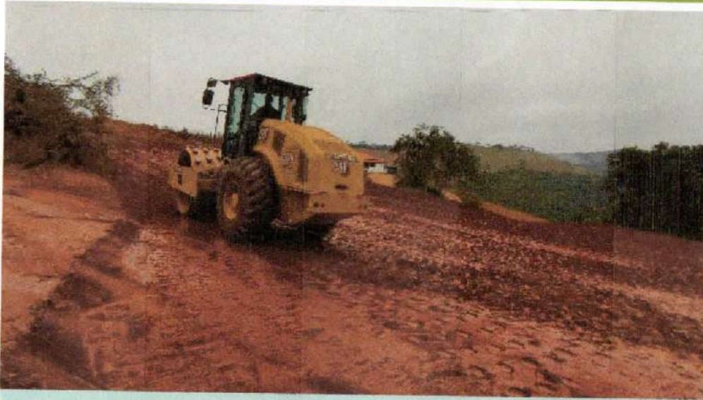
Tamanho ATERRO COMPACTADO E341 A E351
