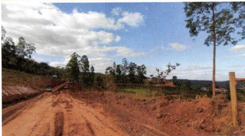
Tamanho ATERRO COMPACTADO E355 A E363
