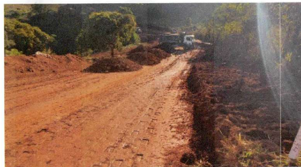
Tamanho ATERRO COMPACTADO E341 A E351
