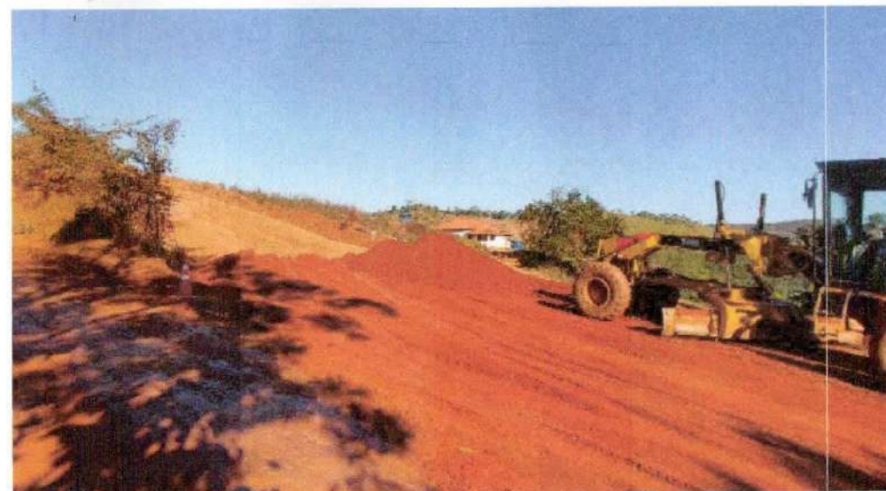
Tamanho ATERRO COMPACTADO E341 A E351
