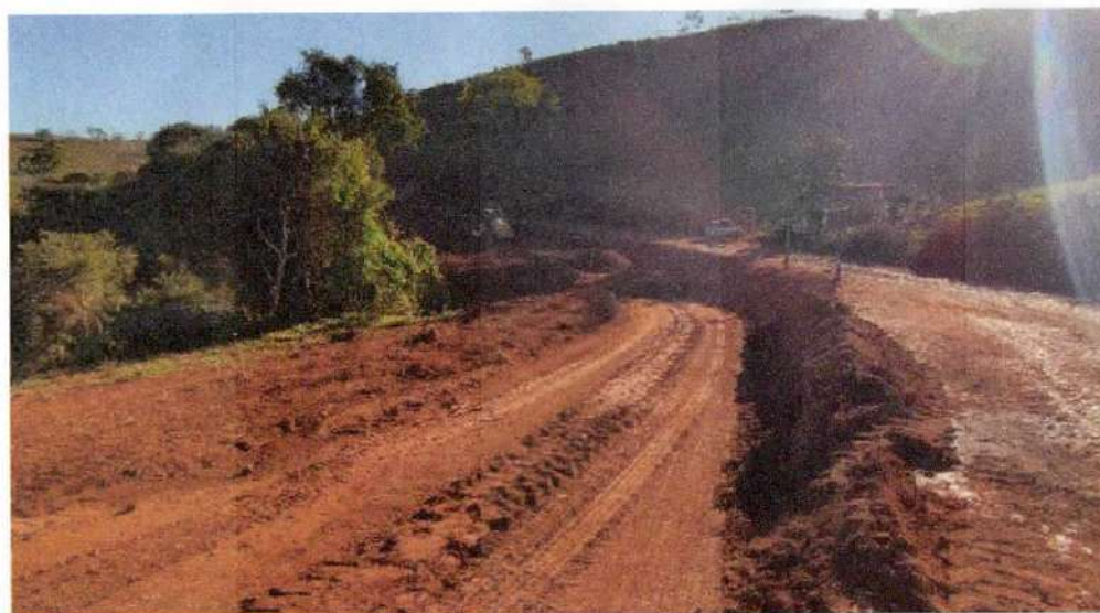
Tamanho ATERRO COMPACTADO E341 A E351
