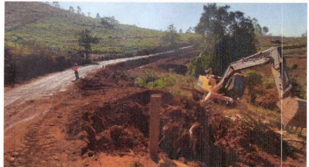
REMOÇÃO DA CAMADA VEGETAL E340 A E347
