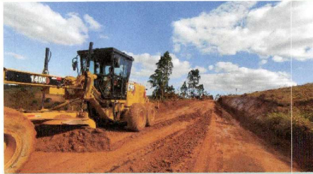
Tamanho ATERRO COMPACTADO E355 A E363
