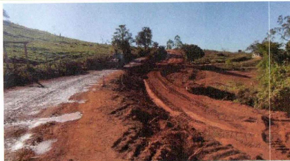
Tamanho ATERRO COMPACTADO E341 A E351
