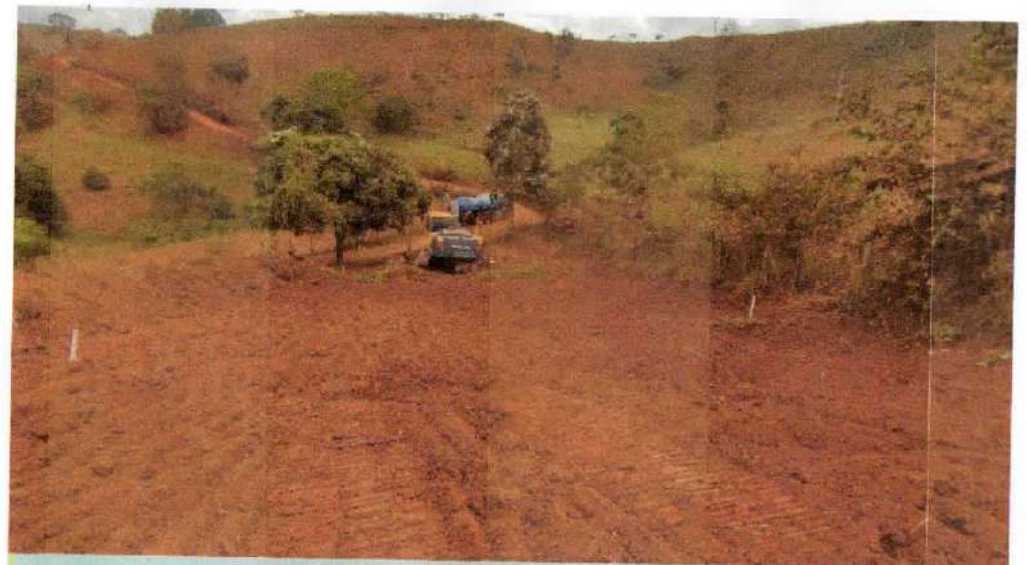
REMOÇÃO DA CAMADA VEGETAL E347 A E355
