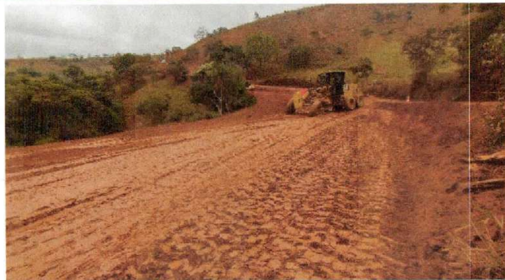
Tamanho ATERRO COMPACTADO E341 A E351
