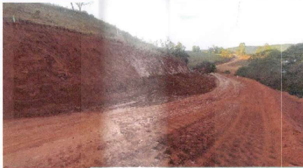
Tamanho ATERRO COMPACTADO E333 A E335
