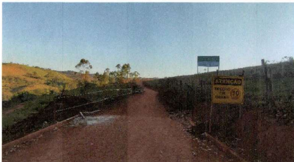
INSTALAÇÃO DE PLACA DE IDENTIFICAÇÃO DE OBRA
