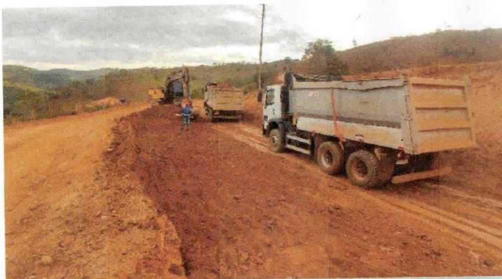
Tamanho: CORTE 1ª CATEGORIA SUBSTITUIÇÃO DE SUB LEITO E351 A E358
