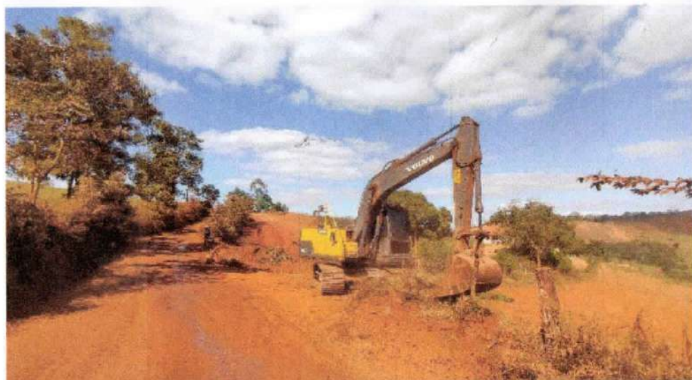
Tam REMOÇÃO DA CAMADA VEGETAL E347 A E355
