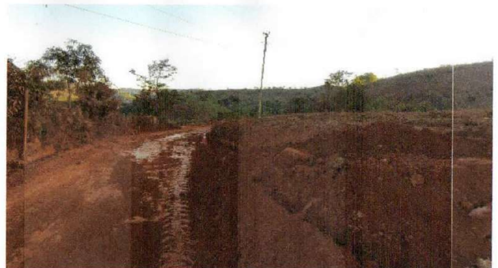
REMOÇÃO DA CAMADA VEGETAL E352 A E355
