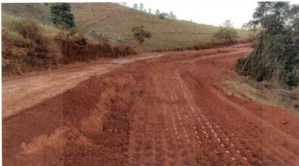
Tamanho ATERRO COMPACTADO E341 A E351
