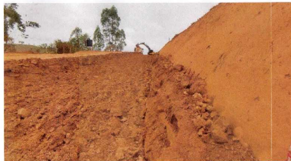
CORTE 1ª CATEGORIA SUBSTITUIÇÃO DE SUB LEITO E351 A E358
