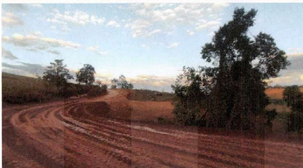
Tamanho ATERRO COMPACTADO E341 A E351
