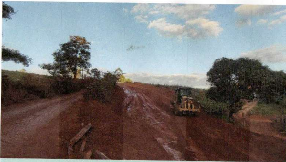
Tamanho ATERRO COMPACTADO E341 A E351
