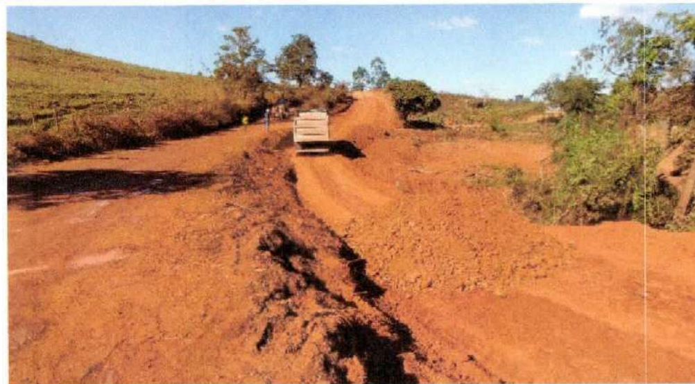
Tamanho ATERRO COMPACTADO E341 A E351
