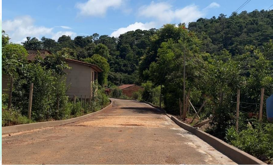
Foto 001: Obras na Fazenda da Ponte
