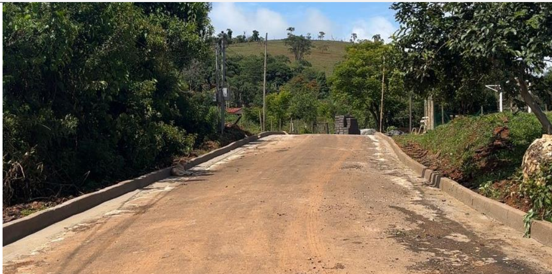
Foto 002: Obras na Fazenda da Ponte
