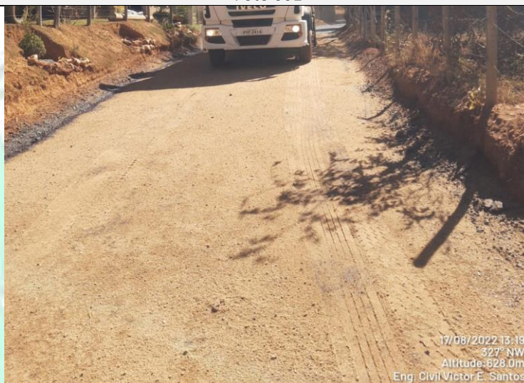
Foto 001: Etapa final da pavimentação
