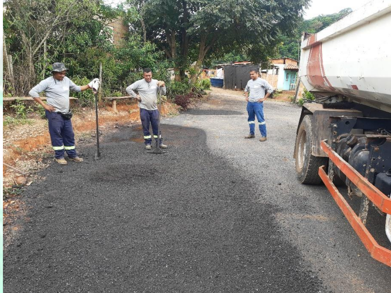
Foto 001: Obras na Fazenda da Ponte
