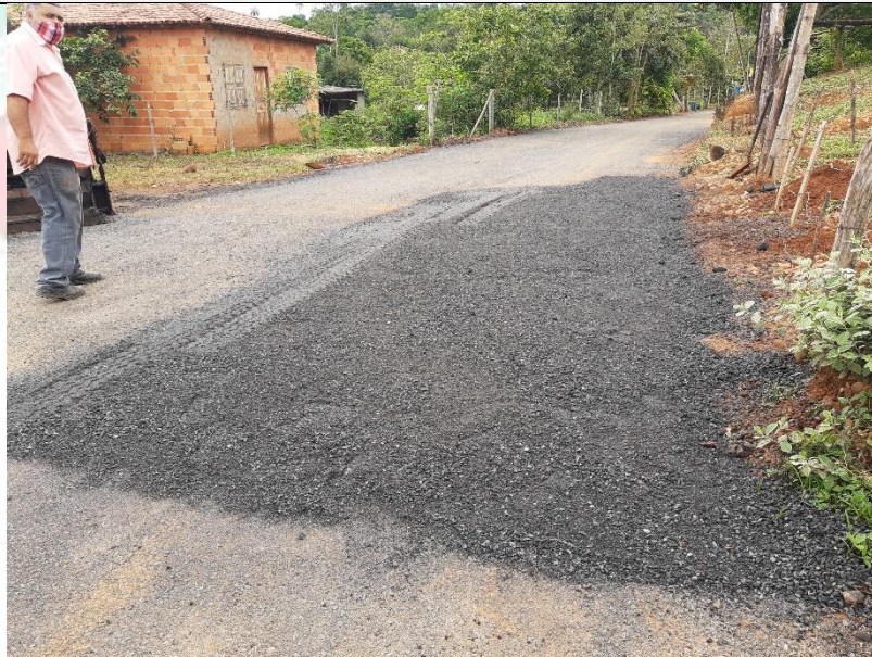
Foto 002: Obras na Fazenda da Ponte
