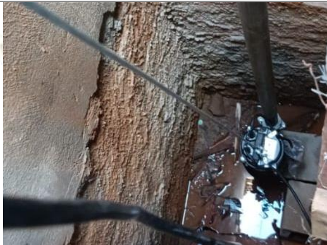
Foto 001: Bombas devidamente instaladas
