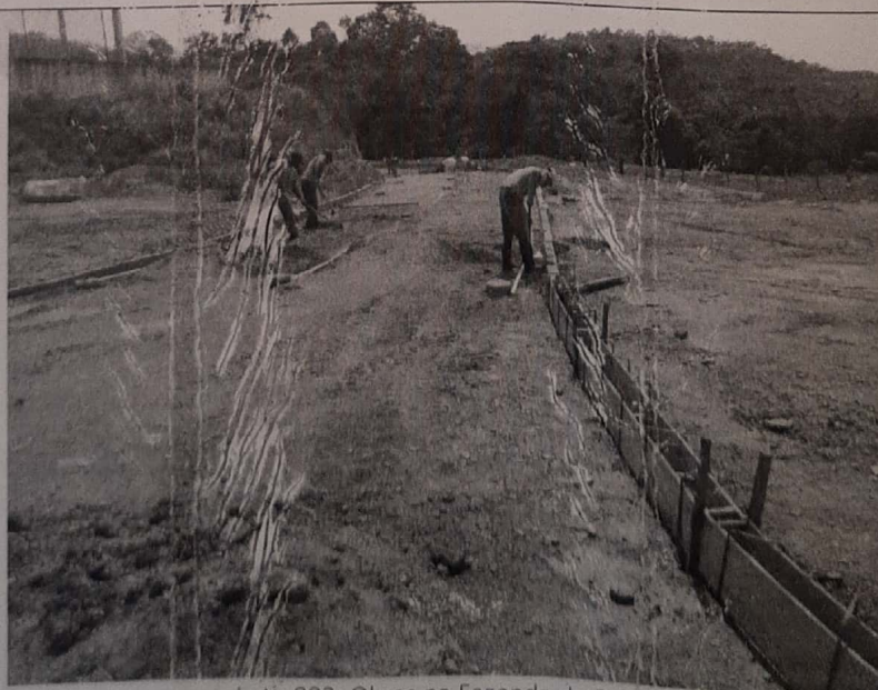
Foto 002: Obras na Fazenda da Ponte
