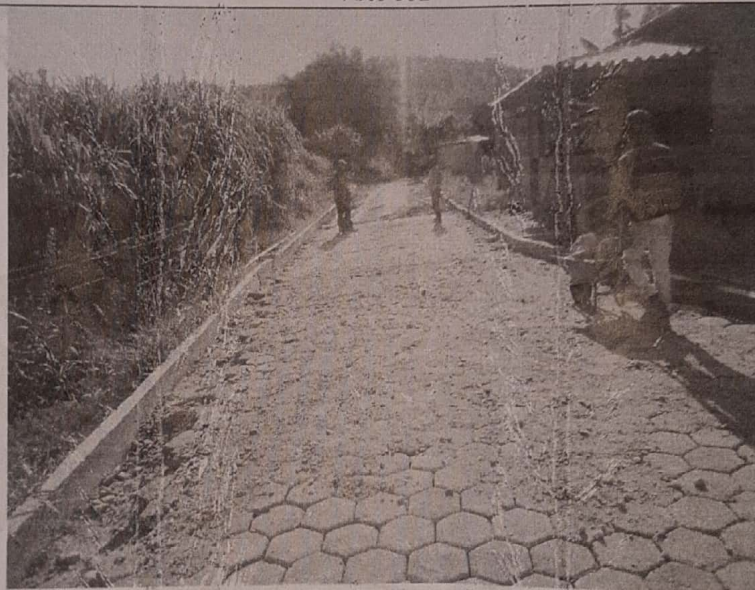
Foto 001: Obras na Fazenda da Ponte
