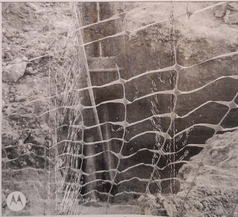
Foto 002: Obras na Fazenda da Ponte
